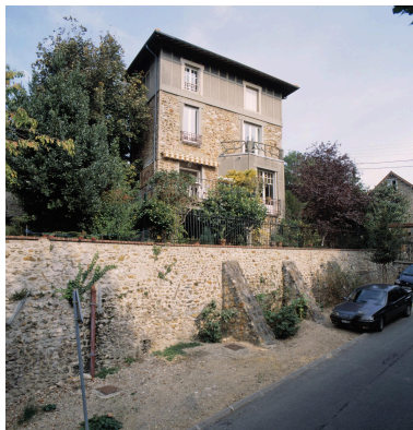
Vue d'ensemble. Phot. Philippe Ayrault IVR11_20029101409XA
