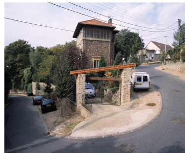
Vue de la maison dans la boucle de l'avenue Constance, côté façade latérale est. Phot. Philippe Ayrault IVR11_20029101412XA
