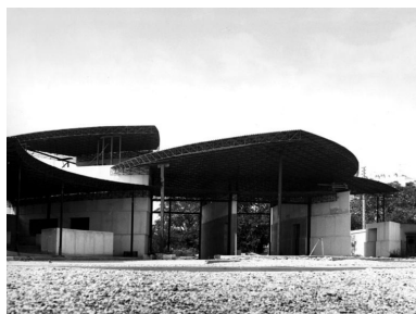
Vue ancienne de la station service.
