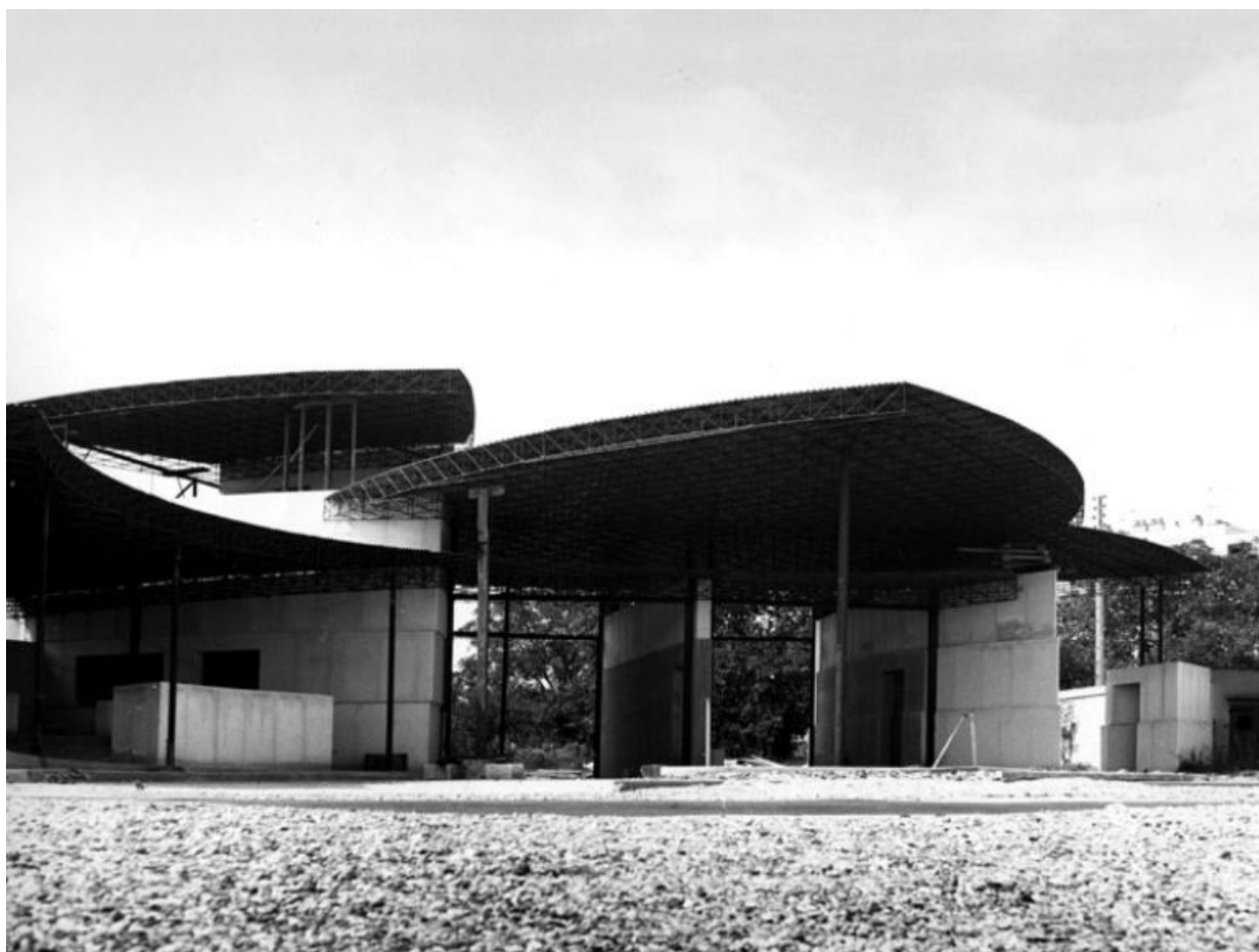
Vue ancienne de la station service.
