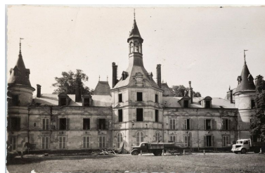
Le château de la Garenne en démolition. Carte postale. (Collection particulière). Phot. Laurent Kruszyk IVR11_20147800373NUC4A
