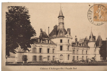
Photographie du château de la Garenne. Carte postale, vers 1920. (Collection particulière). Phot. Laurent Kruszyk IVR11_20147800222NUC4A
