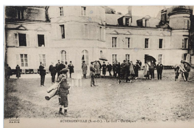
Le château de la Garenne. Carte postale, vers 1925. (Collection particulière). Phot. Laurent Kruszyk IVR11_20147800365NUC4A
