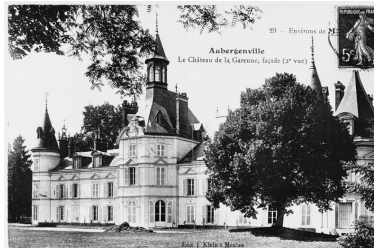
Façade du Château de la Garenne (2e vue). Carte postale, vers 1920. (AM Aubergenville). Phot. Laurent Kruszyk IVR11_20137800243NUC4A
