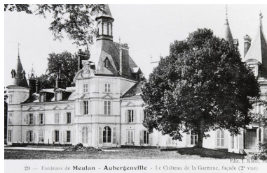
Façade du Château de la Garenne (2e vue). Carte postale, vers 1920. (AM Aubergenville). Phot. Laurent Kruszyk IVR11_20137800224NUC4A
