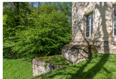
Détail du mur de soubassement. Phot. Kruszyk Laurent IVR11_20247800220NUC4A
