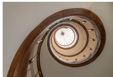
L'escalier à vis central est éclairé par une verrière sommitale en dôme. Elle est protégée par un second toit en pavillon, de verre également. Phot. Kruszyk Laurent IVR11_20247800227NUC4A
