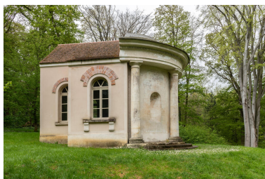
Vue latérale du temple au dieu Pan dont seule la façade antérieure, qui fait face à la colonne, a l'aspect d'un temple antique. Phot. Kruszyk Laurent IVR11_20247800209NUC4A
