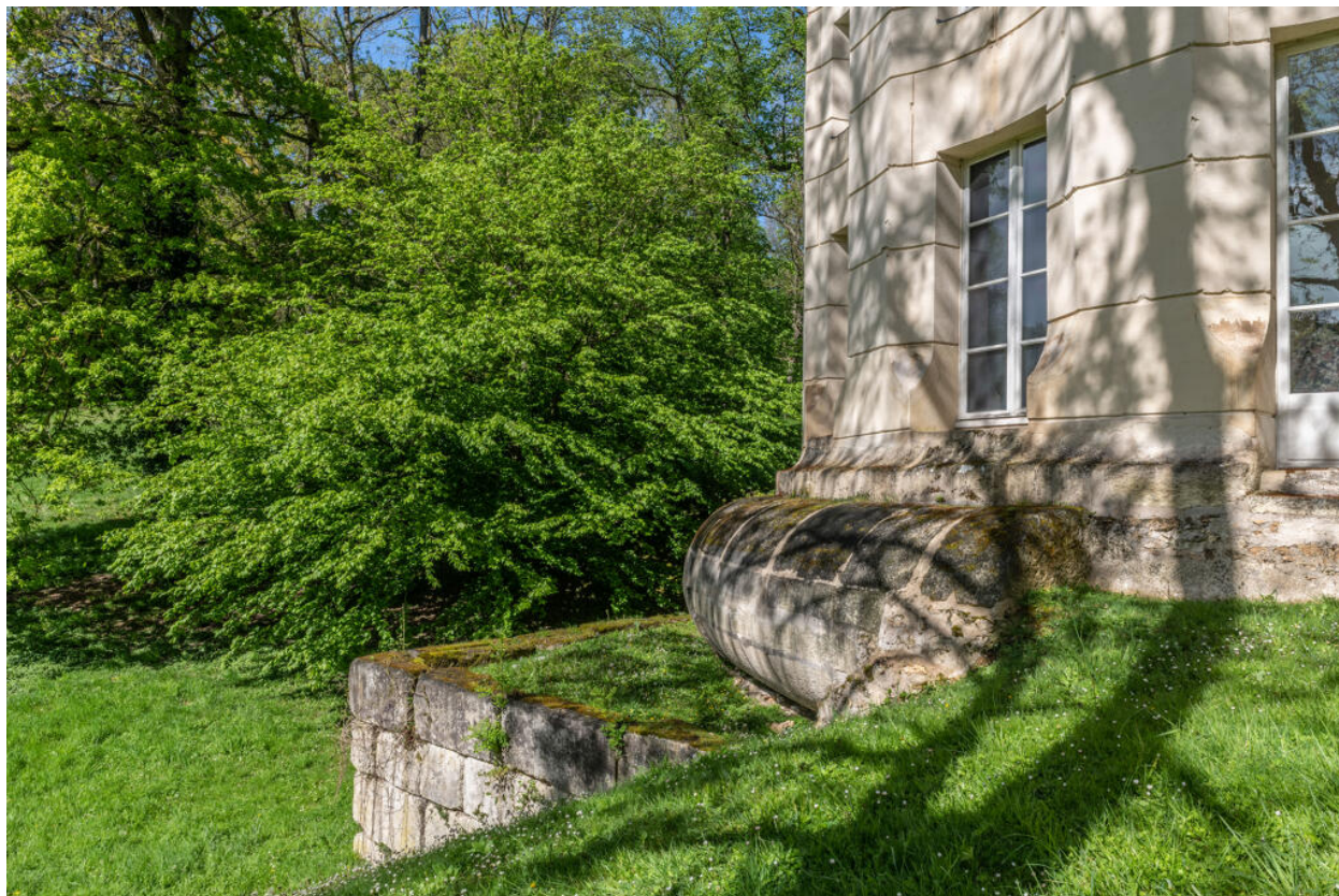
Détail du mur de soubassement.
