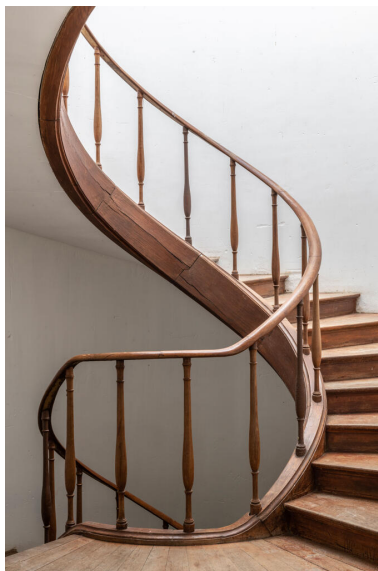
L'escalier en charpente est pourvu d'une rampe d'appui à balustres étirés, très raffinés dans leur simplicité. Phot. Kruszyk Laurent IVR11_20247800225NUC4A
