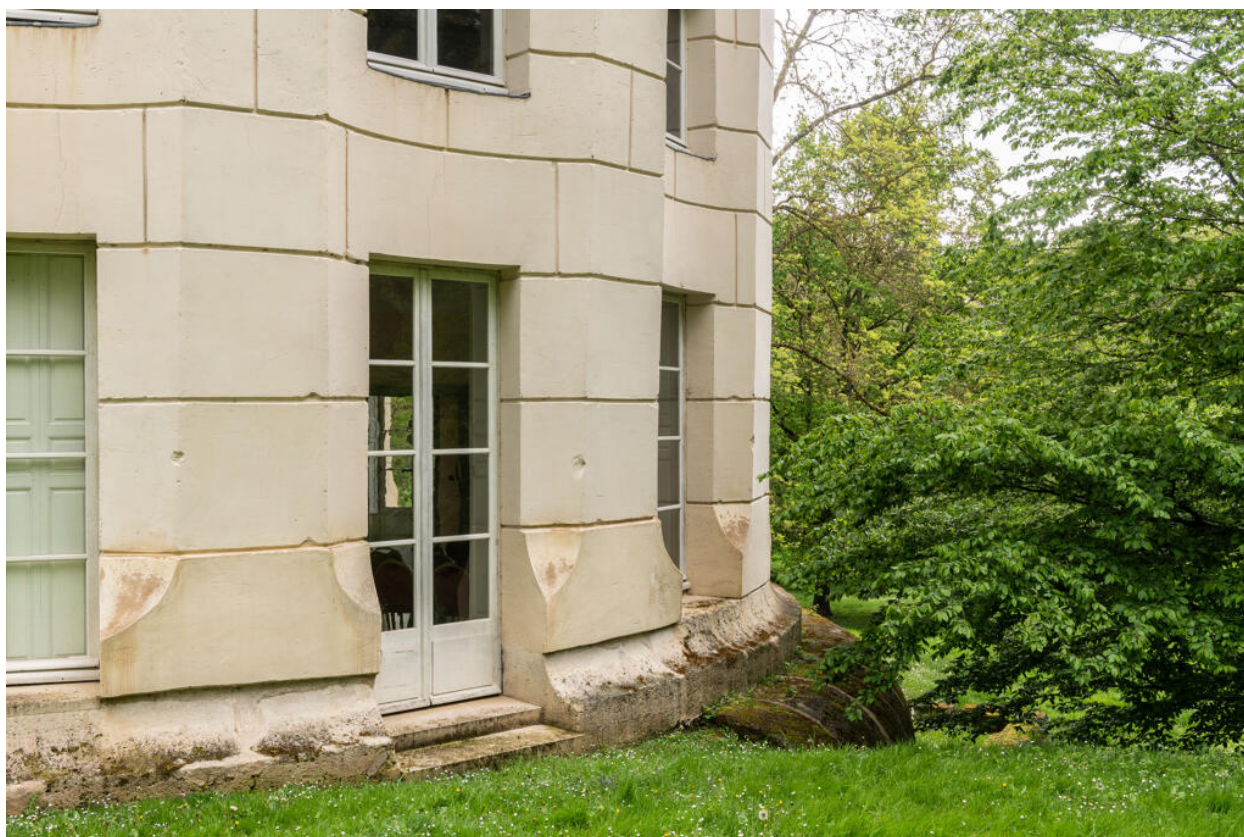
Détail d'une porte-fenêtre côté nord.
