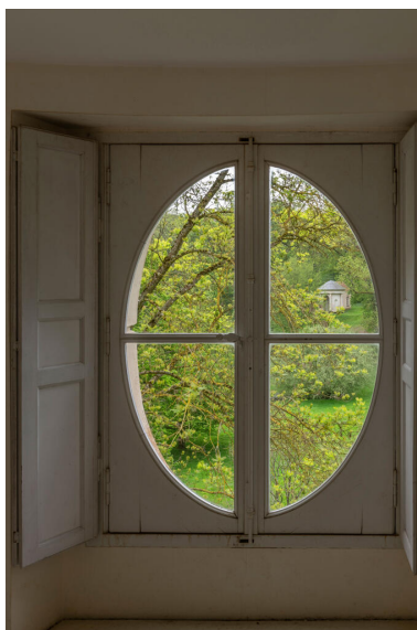
Fenêtre du deuxième étage carré. L'ouverture extérieure est ovale, les battants lui sont adaptés. Phot. Kruszyk Laurent IVR11_20247800229NUC4A
