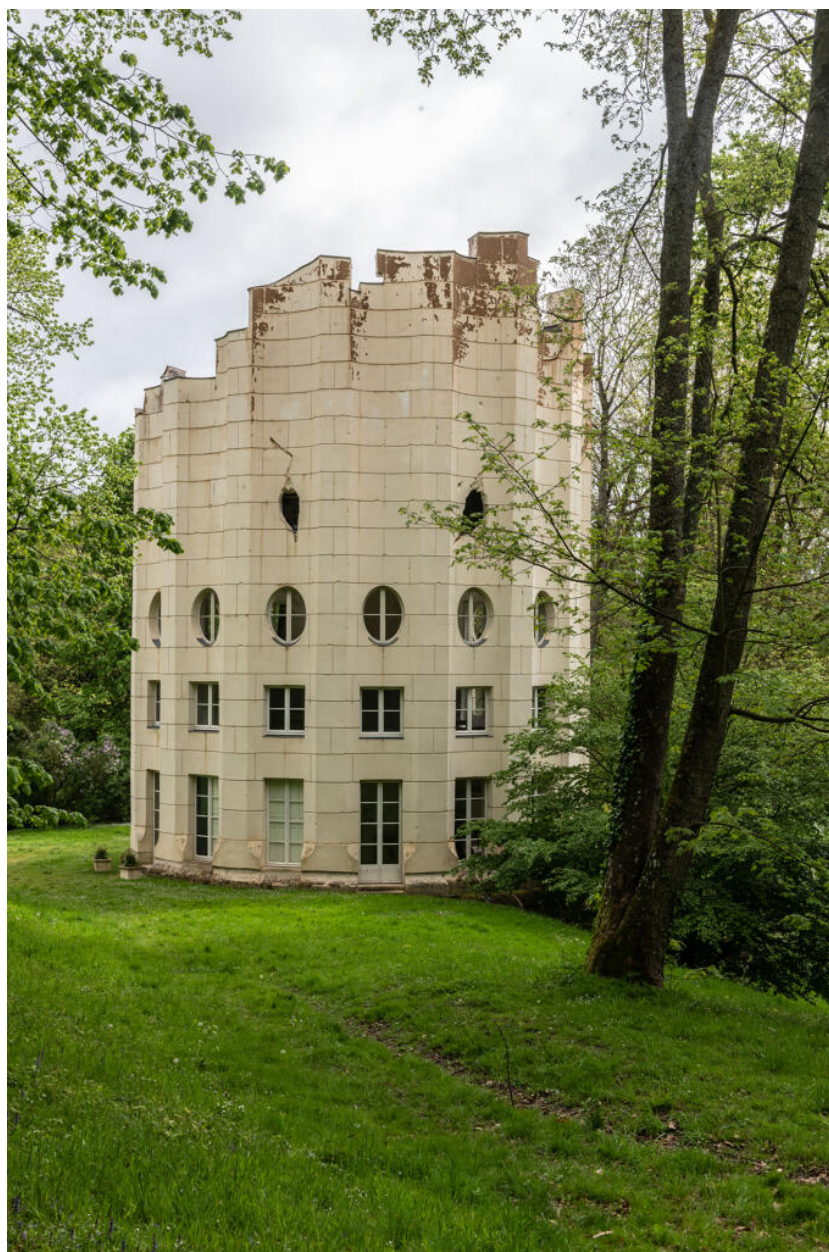
Vue générale depuis l'angle nord-ouest.
