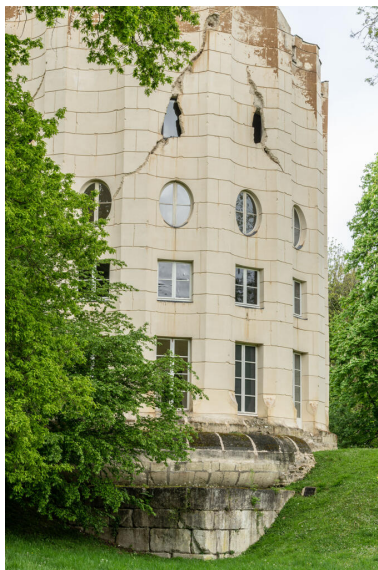
Détail du côté sud. Le mur du soubassement forme un carré, sur lequel est posé le socle circulaire de la colonne. Phot. Kruszyk Laurent IVR11_20247800219NUC4A
