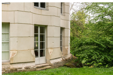
Détail d'une porte-fenêtre côté nord. Phot. Kruszyk Laurent IVR11_20247800221NUC4A
