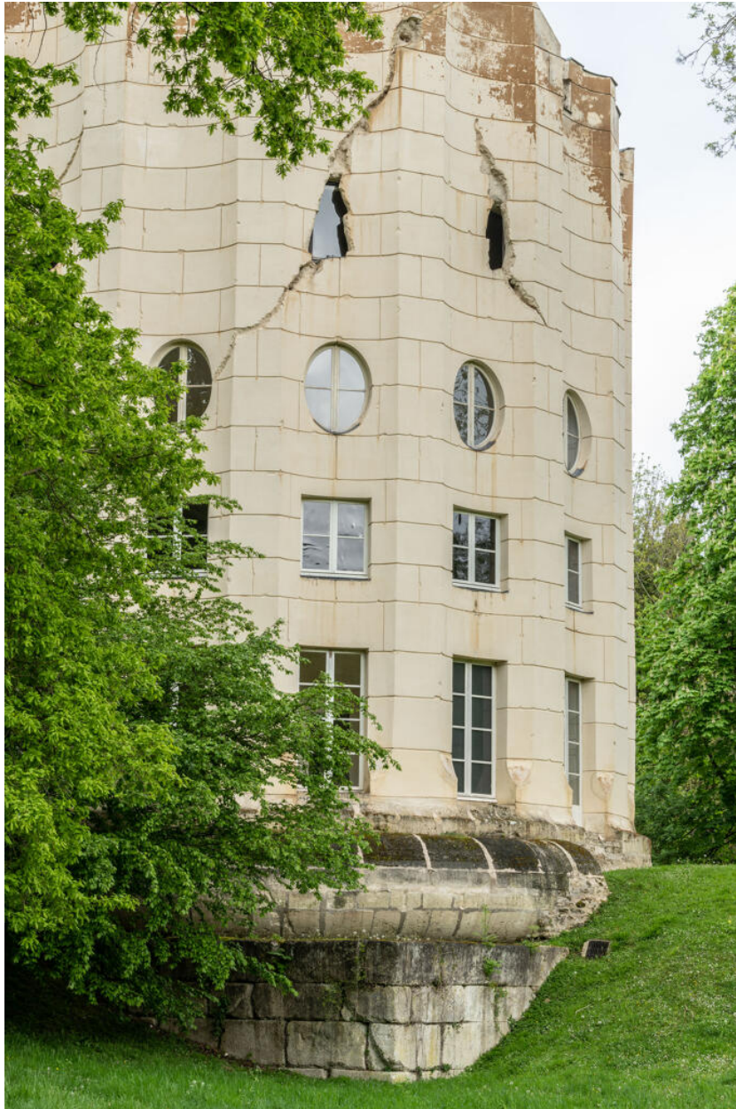
Détail du côté sud. Le mur du soubassement forme un carré, sur lequel est posé le socle circulaire de la colonne.
