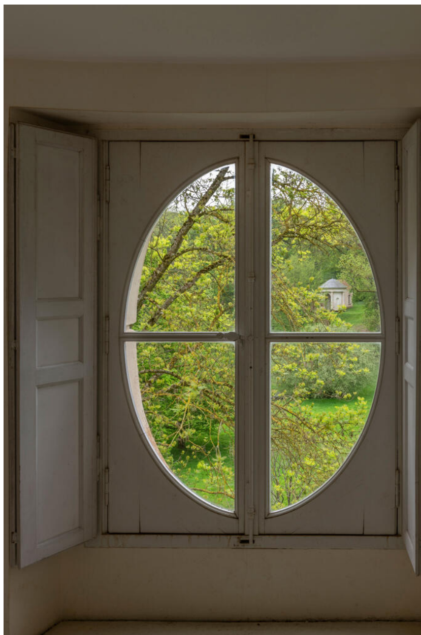
Fenêtre du deuxième étage carré. L'ouverture extérieure est ovale, les battants lui sont adaptés.
