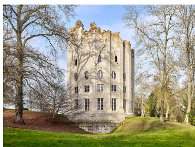
La tour détruite se dresse sur un soubassement en pierre de taille de deux niveaux. IVR11_20207800118NUC4A
