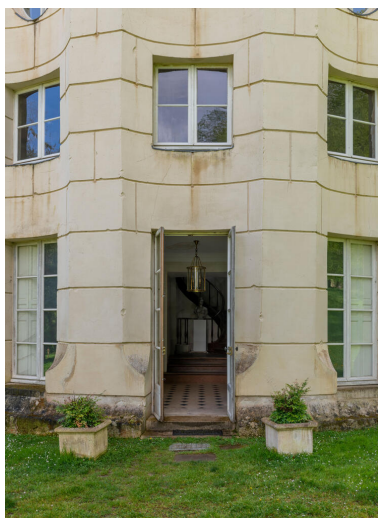
L'entrée principale, côté nord-est. Elle ouvre sur le vestibule et l'escalier qui monte de fond. Phot. Kruszyk Laurent IVR11_20247800222NUC4A
