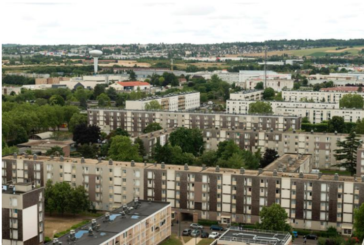
Vue du Val Fourré et de son château d'eau prise depuis une tour du quartier des aviateurs.
