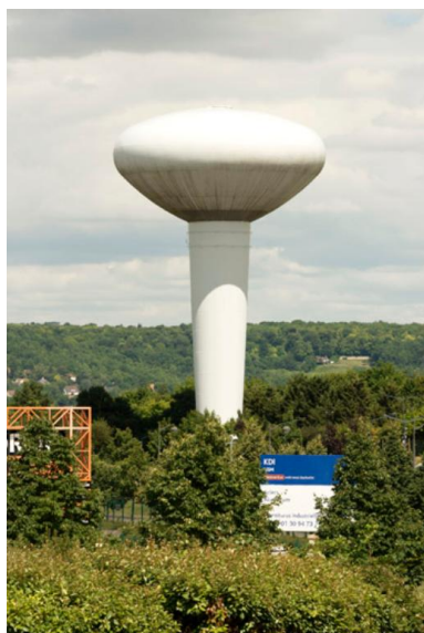
Vue d'ensemble. Phot. Laurent Kruszyk IVR11_20177800718NUC4A
