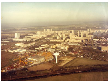
Le château d'eau fait partie du paysage du Val Fourré comme le montre cette photographie des années 1980. (Région Île-de-France, onds CREDOP) IVR11_20167800139NUC4AB
