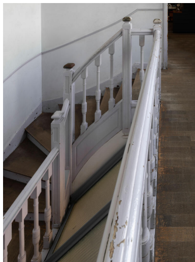
L'escalier principal, en bois peint. Phot. Kruszyk Laurent IVR11_20249300088NUC4A
