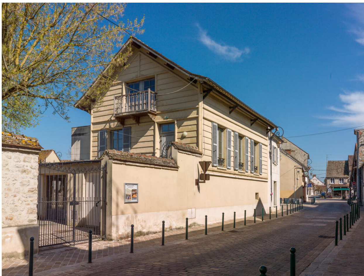
Vue générale du 45 rue Langlois, depuis le sud-ouest.
