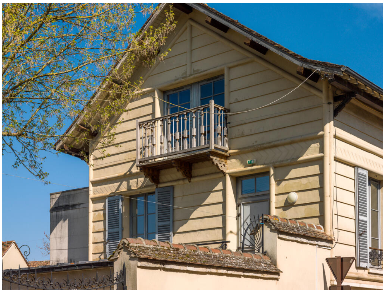
Détail du pignon ouest du 45 rue Langlois.
