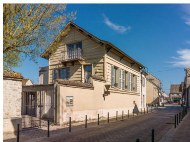
Vue générale du 45 rue Langlois, depuis le sud-ouest. Phot. Asseline Stéphane IVR11_20259100179NUC4A
