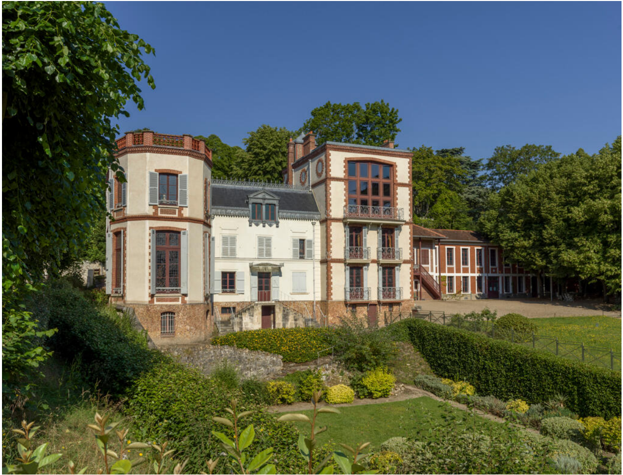
La façade côté Seine. Au centre, le bâtiment d'origine (années 1840). Au nord, la tour Nana, de section carrée (1878) et au sud la tour Germinal de plan hexagonal (1885-1886).
