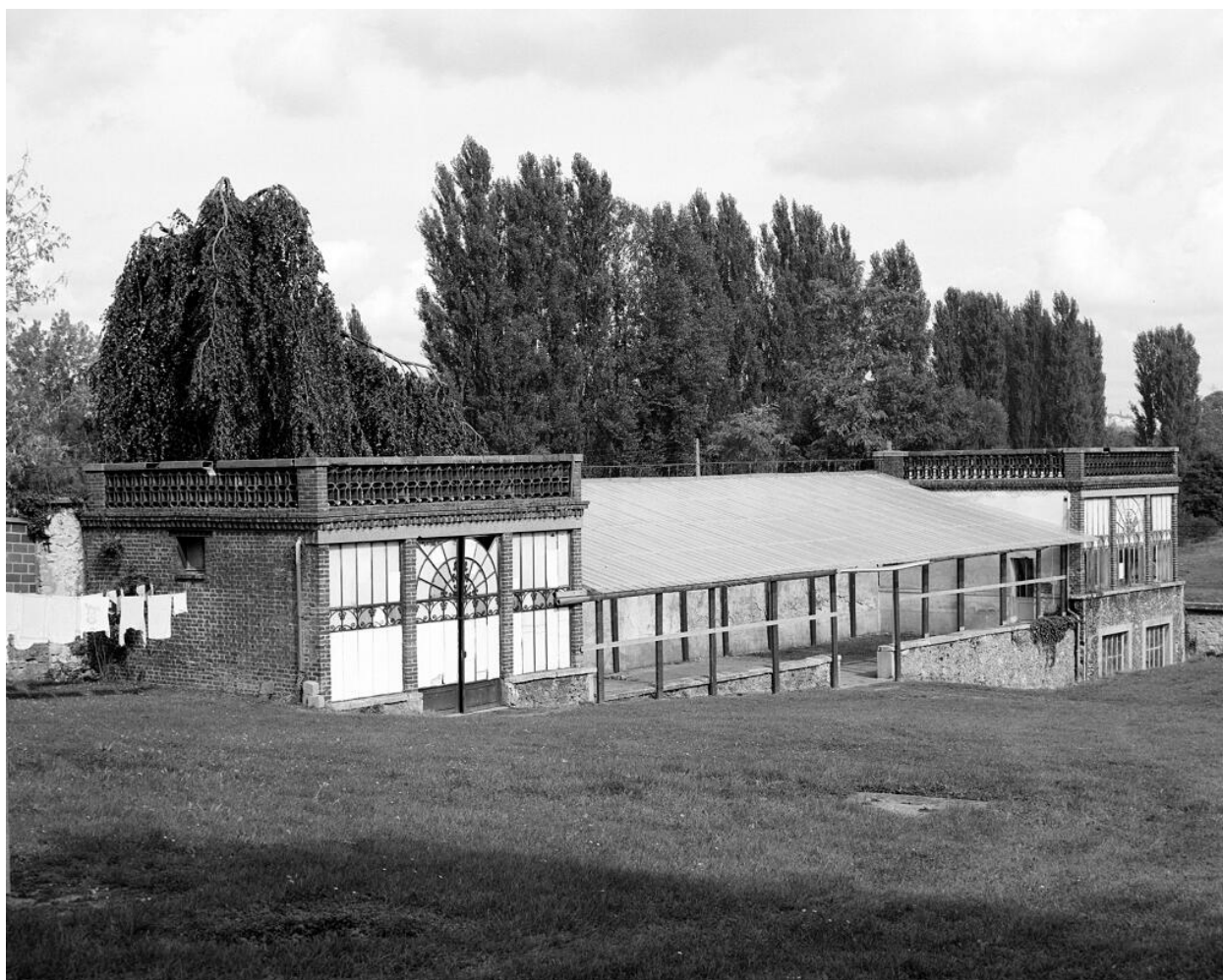
Serres (en cours de restauration).
