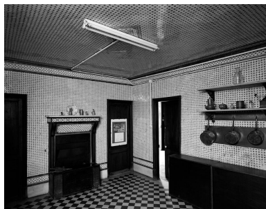
Tour Nana : la cuisine au rez-de-chaussée Phot. Vialles Jean-Bernard IVR11_19927800830V
