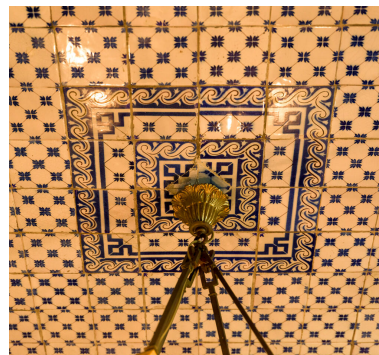
Tour Nana : la cuisine. Détail du plafond. La pièce est entièrement carrelée, du sol au plafond. Phot. Stéphane Asseline IVR11_20247800428NUC4A
