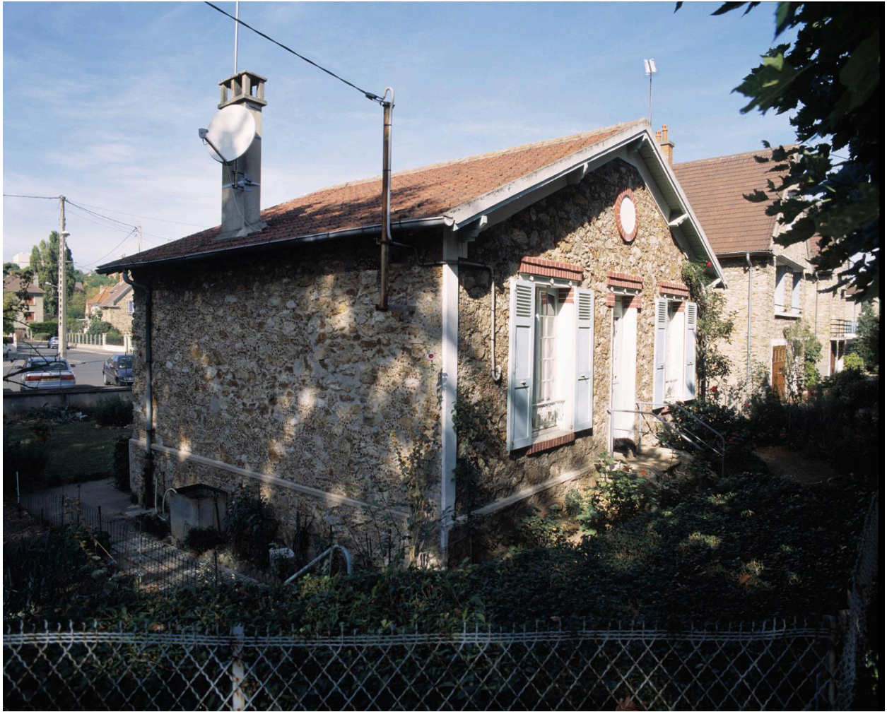
Vue d'ensemble. Le comble est percé d'un simple oculus.
