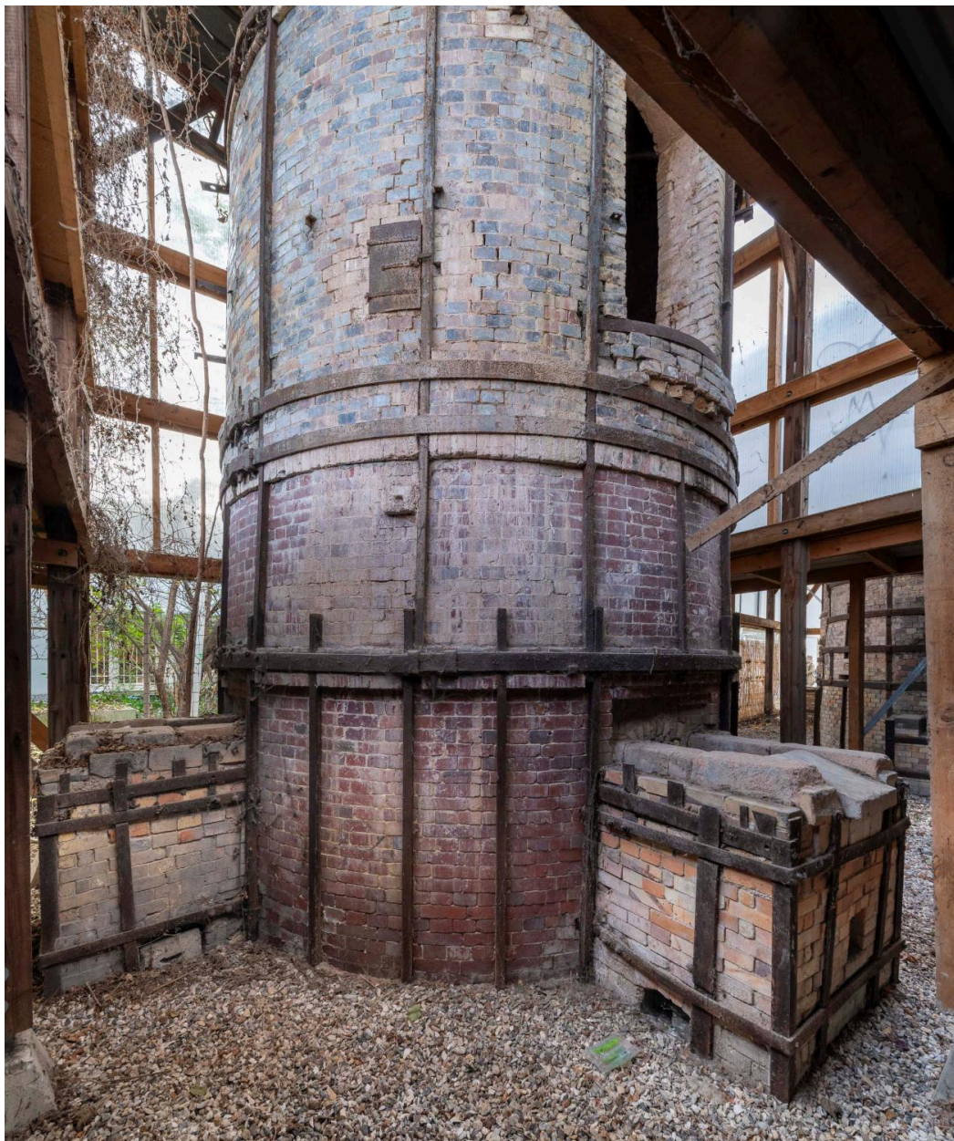
Base du four rond à globe et à flamme renversée, brevet 1878, mis en place avant 1912.
