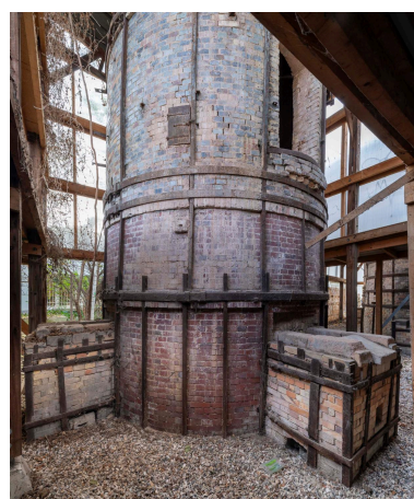
Base du four rond à globe et à flamme renversée, brevet 1878, mis en place avant 1912. Phot. Philippe Ayrault IVR11_20239300695NUC4A
