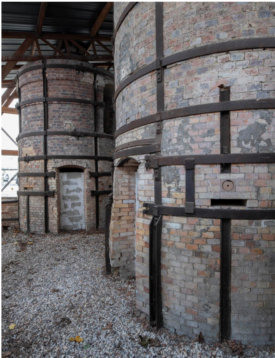
Fours ronds à globe et à flamme directe, fin des années 1870.
