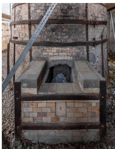
Alandier du second four à flamme directe. Phot. Philippe Ayrault IVR11_20239300697NUC4A
