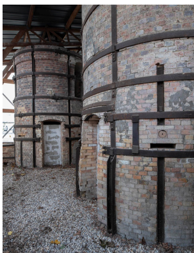
Fours ronds à globe et à flamme directe, fin des années 1870. Phot. Philippe Ayrault IVR11_20239300689NUC4A
