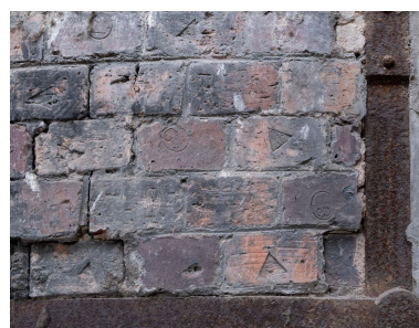
Briques estampillées du second four à flamme directe. Phot. Philippe Ayrault IVR11_20239300692NUC4A
