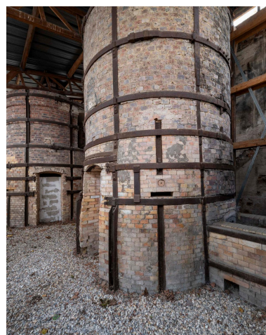
Four rond à globe et à flamme directe, fin des années 1870. Phot. Philippe Ayrault IVR11_20239300690NUC4A
