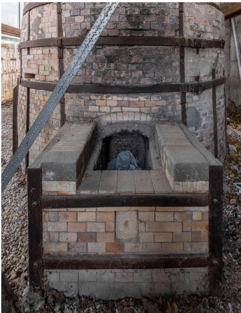
Alandier du second four à flamme directe.
