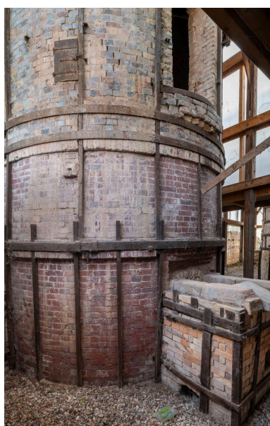
Alandier du second four à flamme directe. Phot. Philippe Ayrault IVR11_20239300697NUC4A
