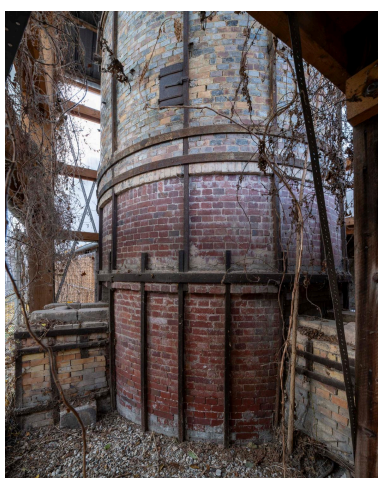
Base du four rond à globe et à flamme renversée, brevet 1878, mis en place avant 1912. Phot. Philippe Ayrault
