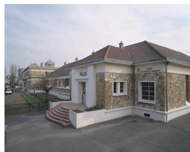
Vue de l'aile sud-ouest du bâtiment. Phot. Philippe Ayrault IVR11_20029100297XA
