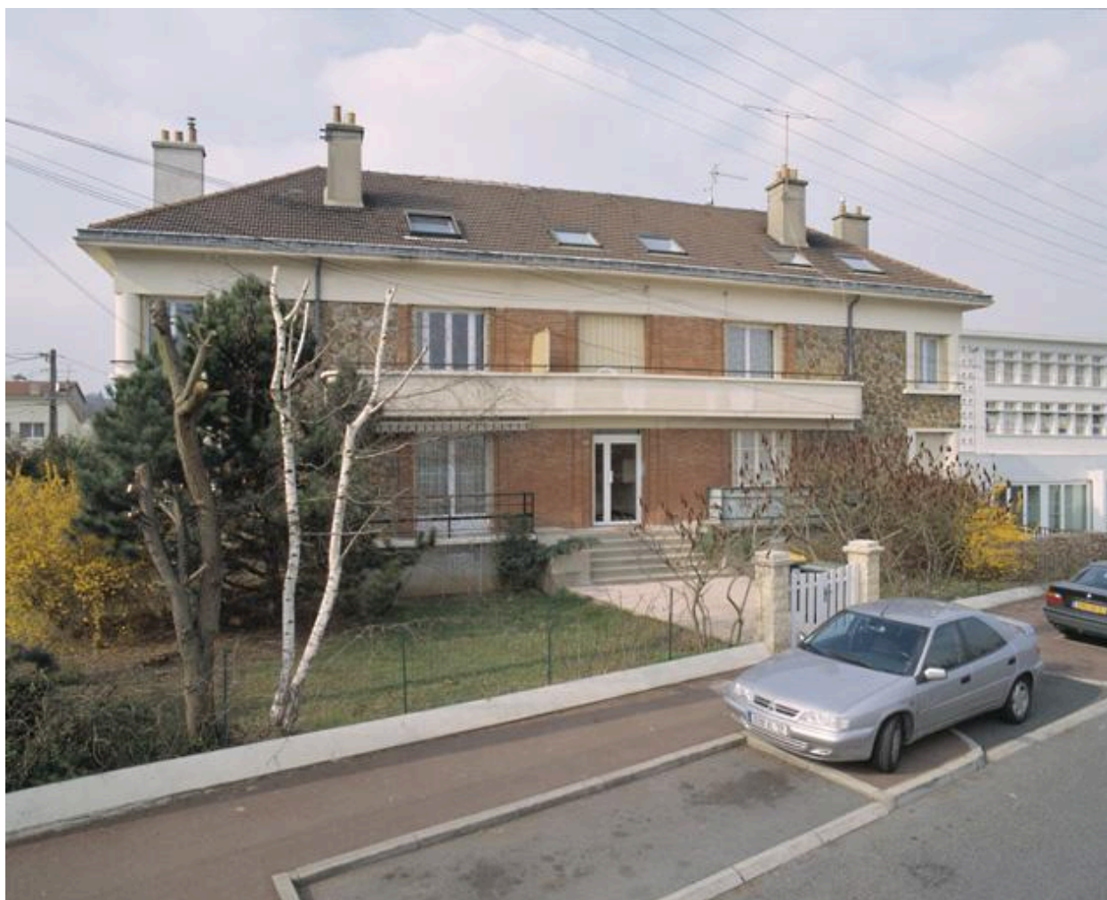
Vue d'ensemble du logement des instituteurs, situé au 93 rue de Juvisy.
