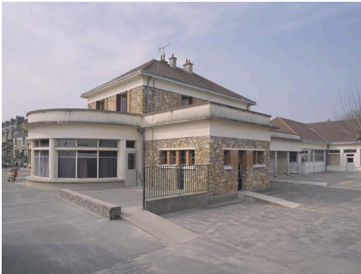
Vue de la rotonde (côté est) située à l'arrière du bâtiment.
