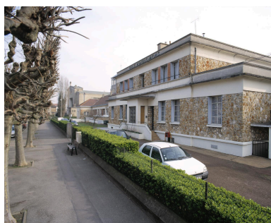
Vue d'ensemble (corps central et aile est). Phot. Philippe Ayrault IVR11_20029100294XA
