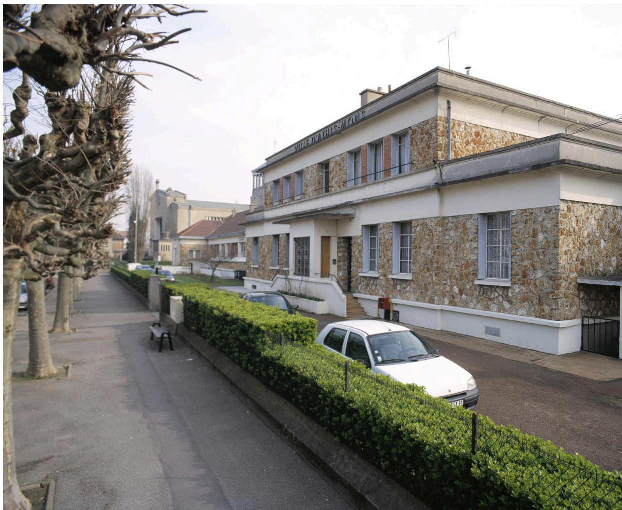
Vue d'ensemble (corps central et aile est).
