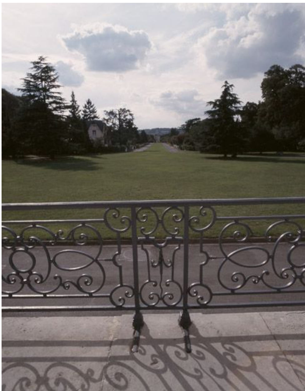
Détail de la grille en fer forgé qui orne le perron. A l'arrière plan, dans l'axe du château, l'allée de la Perspective.
