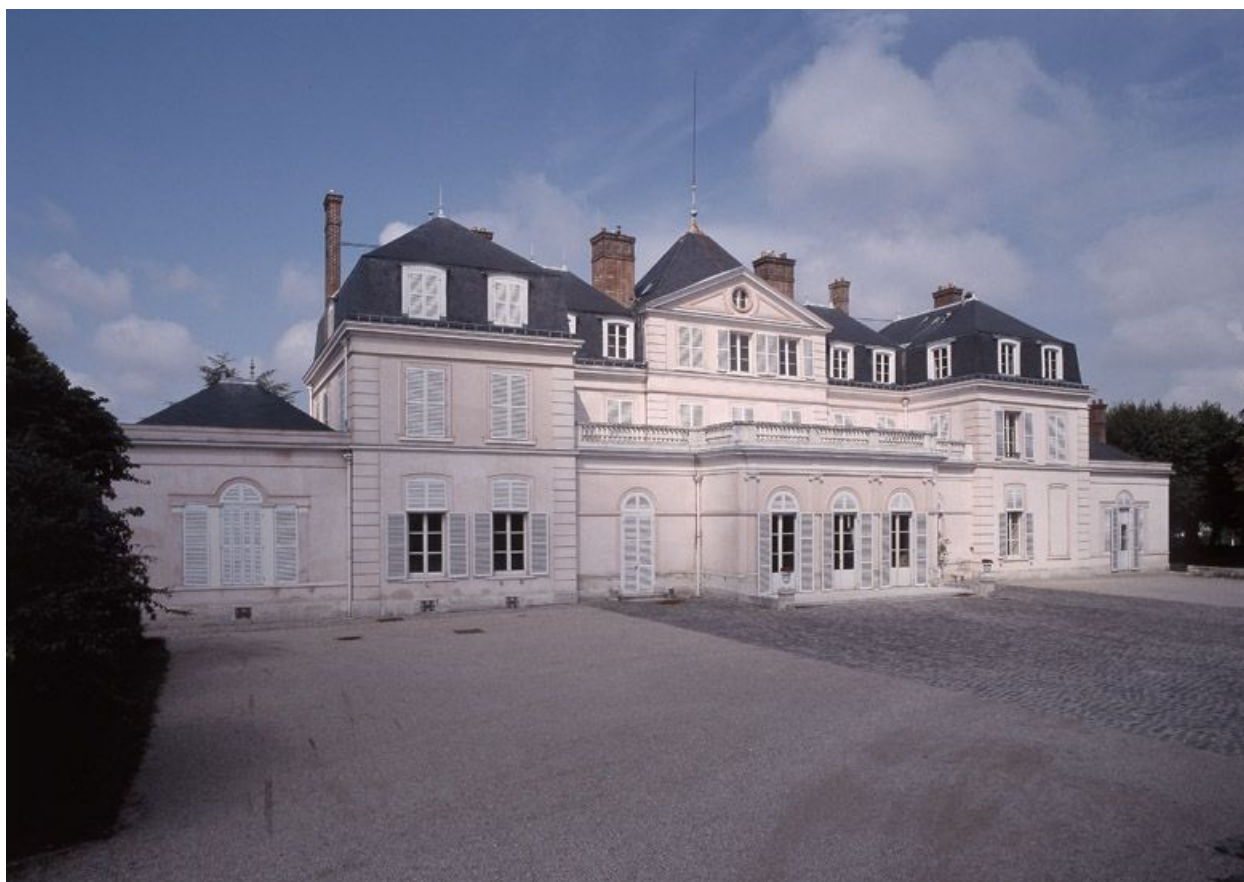
Vue de la façade antérieure.
