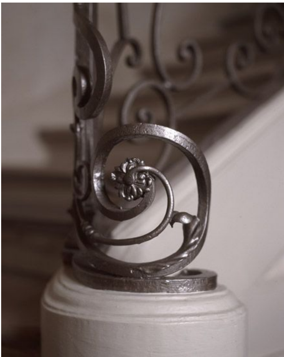
L'escalier intérieur situé à droite dans le hall d'entrée : détail de l'amortissement de la rampe.
