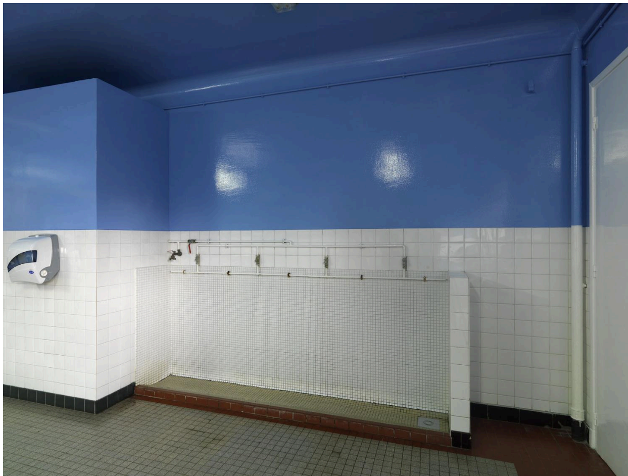
Vue des toilettes.
