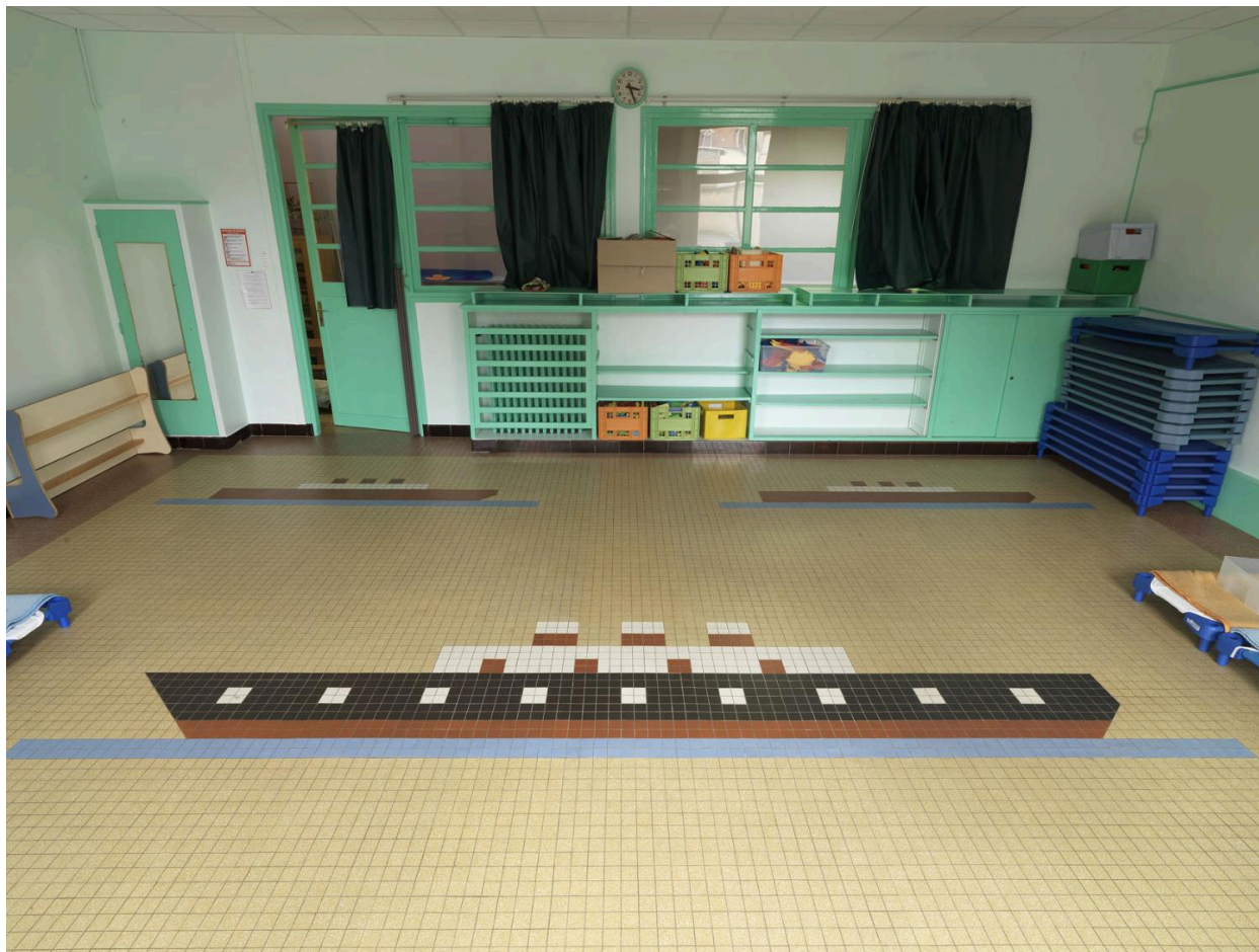
Détail des décors de pavement des salles de classe, réalisés par René Grégoire : les paquebots.
