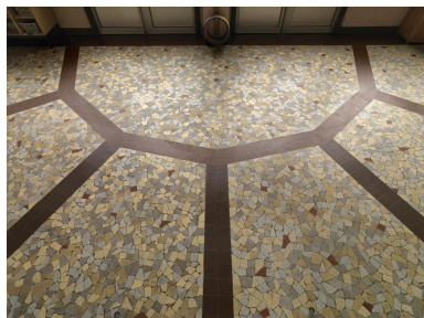
Vue du pavement du préau couvert. Phot. Laurent Kruszyk IVR11_20099300254NUC4A
