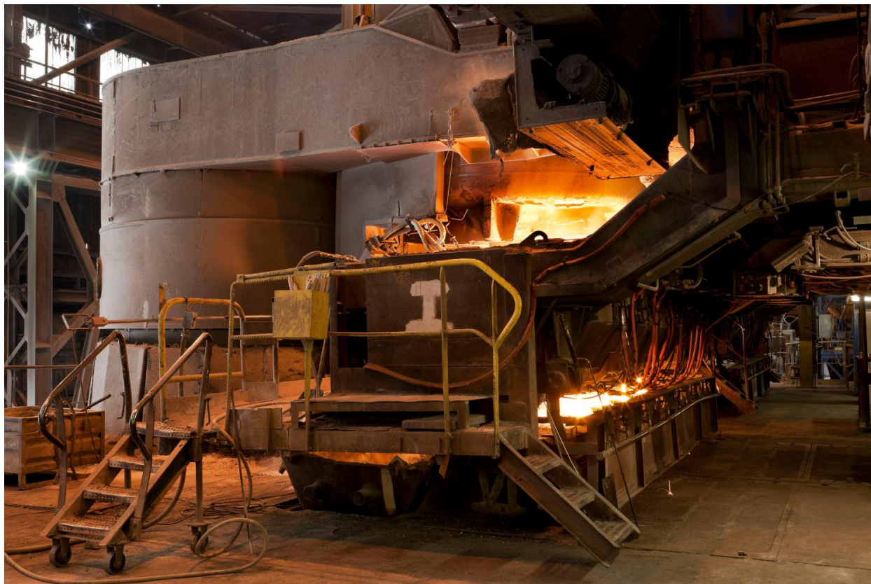
Halle de coulée, coulée continue. (réf. Département Seine-et-Marne : IVD77_2013_77_00244_NUCA)
