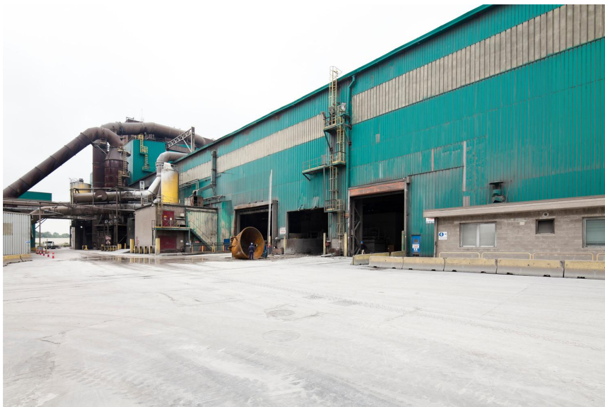
Extérieur de la halle de coulée. (réf. Département de Seine-et-Marne : IVD77_2013_77_00265_NUCA)
