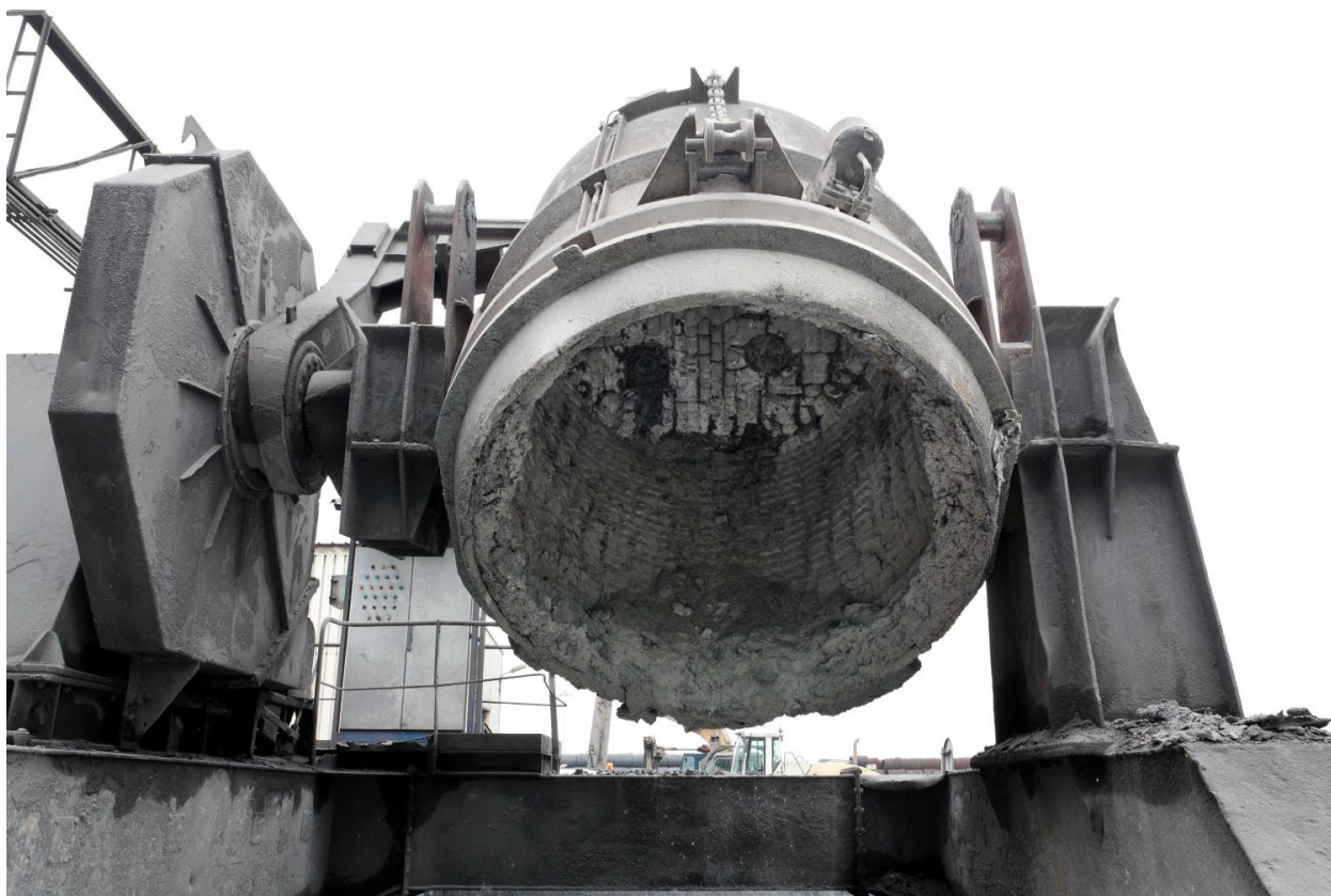
Cuve. (réf. Département de Seine-et-Marne : IVD77_2013_77_00263_NUCA)
