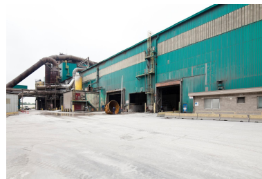
Extérieur de la halle de coulée. (réf. Département de Seine-et-Marne : IVD77_2013_77_00265_NUCA) Phot. Yvan Bourhis IVR11_20197700443NUC4A
