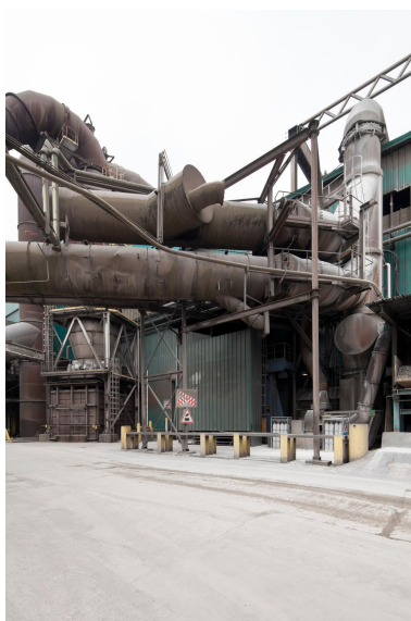
Système de dépoussiérage. (réf. Département de Seine-et-Marne : IVD77_2013_77_00266_NUCA) Phot. Yvan Bourhis IVR11_20197700444NUC4A
