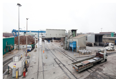
Parc à ferrailles. (réf. Département Seine-et-Marne : IVD77_2013_77_00234_NUCA) Phot. Yvan Bourhis IVR11_20197700414NUC4A
