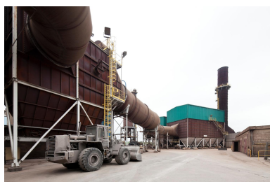
Système de dépoussiérage. (réf. Département de Seine-et-Marne : IVD77_2013_77_00267_NUCA) Phot. Yvan Bourhis IVR11_20197700445NUC4A
