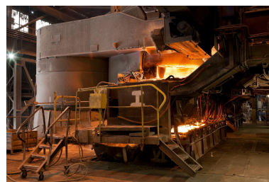
Halle de coulée, coulée continue. (réf. Département Seine-et-Marne : IVD77_2013_77_00244_NUCA) Phot. Yvan Bourhis IVR11_20197700422NUC4A
