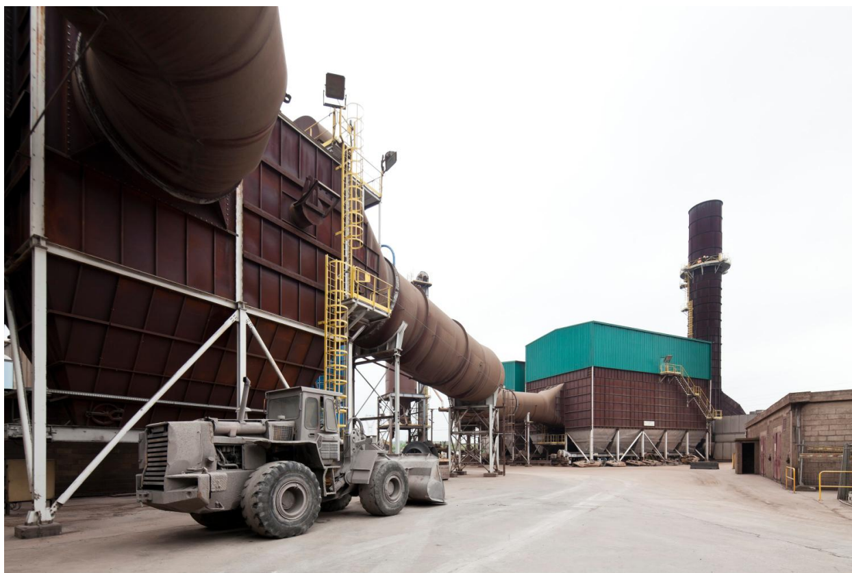
Système de dépoussiérage. (réf. Département de Seine-et-Marne : IVD77_2013_77_00267_NUCA)
