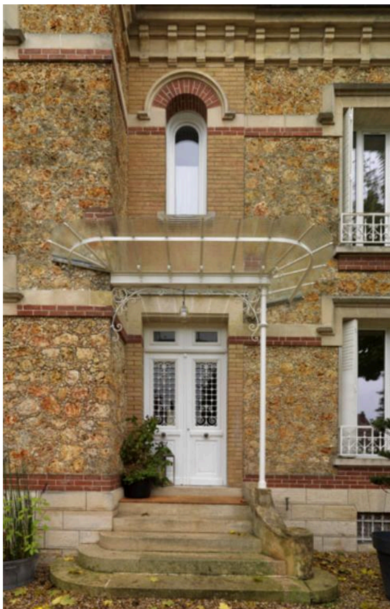
Vue de détail de la marquise d'entrée
