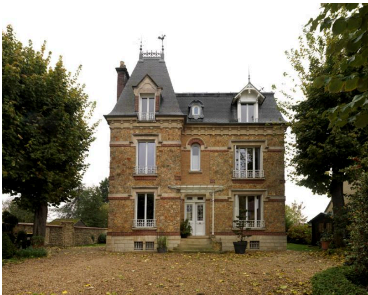
Façade principale sur rue.
