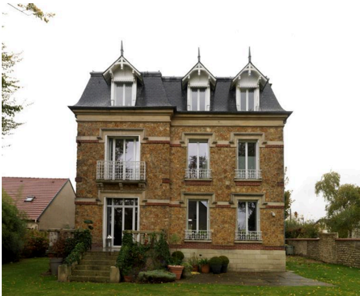
Façade arrière sur jardin
