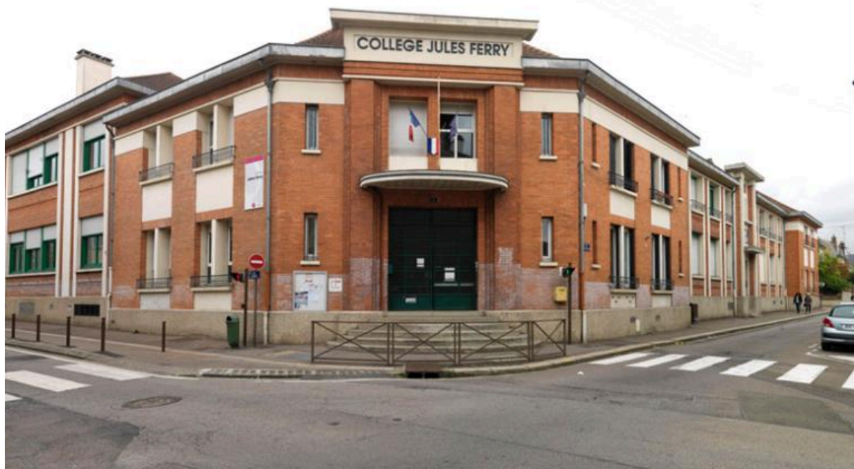
Vue d'ensemble de l'entrée de l'ancienne école de garçon, à l'angle des rues Castor et des Ecoles.
