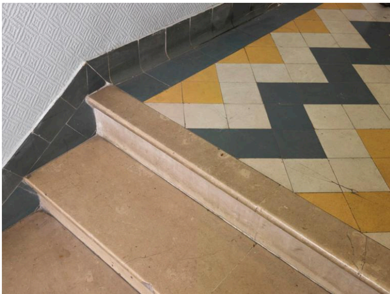
Carrelage du sol de l'entrée des logements.
