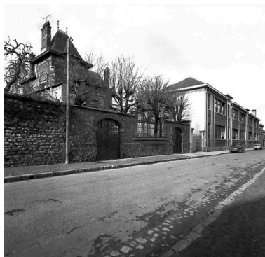
La rue Castor. (Fonds Bertin). Phot. Bertin IVR11_20177800590NUC2B
