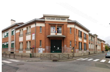
Vue d'ensemble de l'entrée de l'ancienne école de garçon, à l'angle des rues Castor et des Ecoles. Phot. Laurent Kruszyk IVR11_20177801391NUC4A
