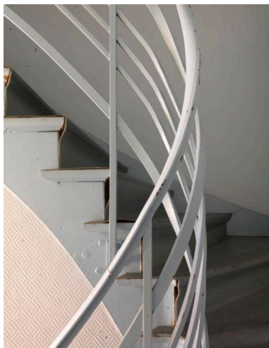
L'escalier conduisant aux logements. Phot. Laurent Kruszyk IVR11_20177801404NUC4A
