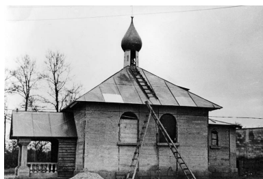
Photo ancienne. Construction de l'église orthodoxe en 1937-1938 sur les plans de J.Papandopoulos, ingénieur de la société PIC de Fontainebleau. Repro. Académie François Bourdon-Le Creusot IVR11_20117700113NUC
