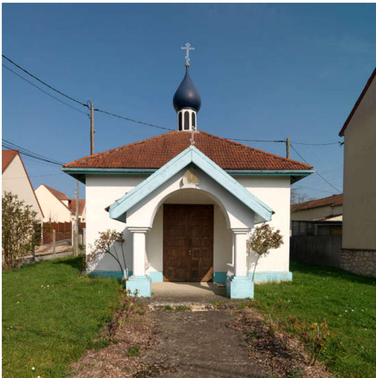
Vue extérieure. Le toit en pavillon est couronné d'un bulbe.
