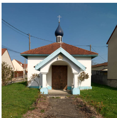
Vue extérieure. Le toit en pavillon est couronné d'un bulbe. Phot. Philippe Ayrault
