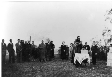
Photo ancienne. Office en plein air par un prêtre orthodoxe, lors de la construction de l'église (1937-1938). Repro. Académie François Bourdon-Le Creusot IVR11_20117700111NUC
