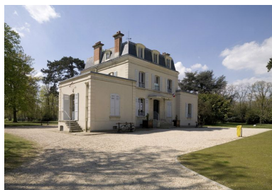
Vue d'ensemble. Phot. Philippe Ayrault IVR11_20089100341NUC4A
