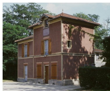
Vue d'ensemble de la maison du gardien. Phot. Stéphane Asseline IVR11_20079101425XA
