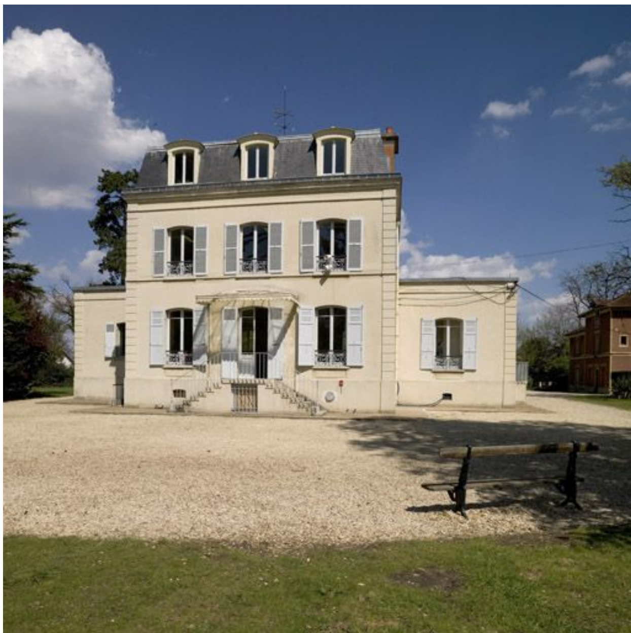
Vue de la façade arrière.
