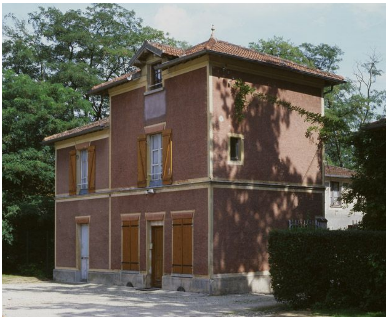
Vue d'ensemble de la maison du gardien.
