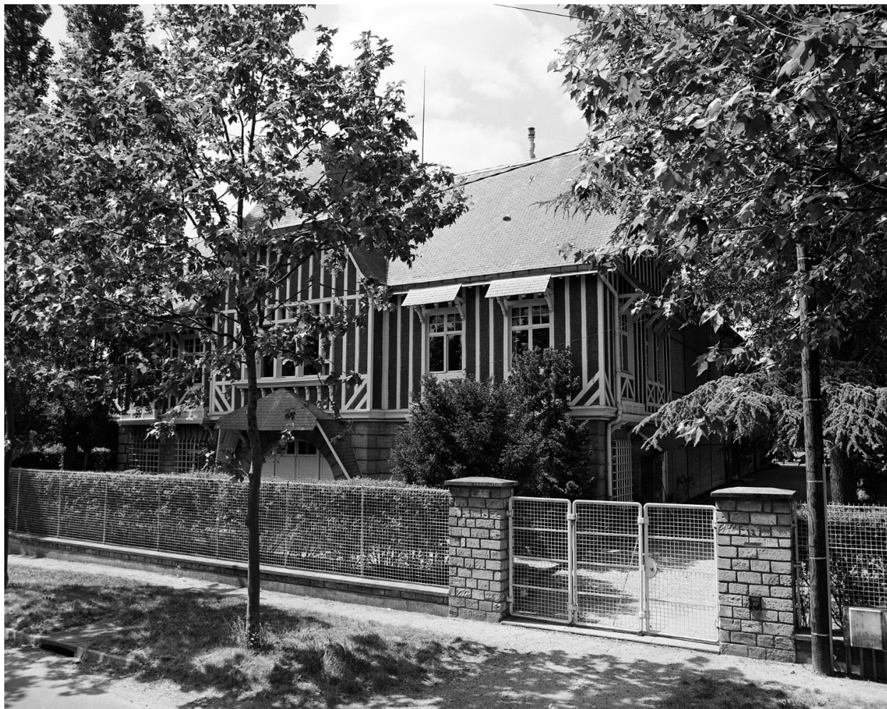
Vue d'ensemble de la façade antérieure
