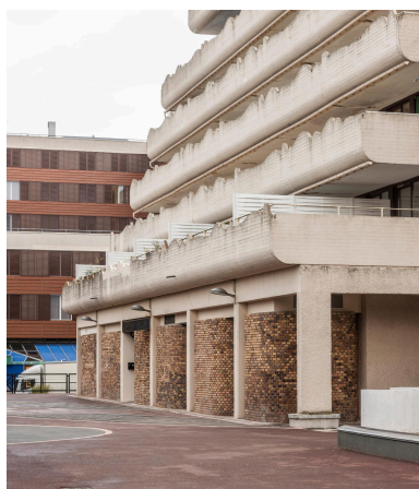
Le cœur de la dalle des Sept-Mares, dont la colonne vertébrale est formée par une rue encadrée de quatre immeubles d'habitations en gradins se faisant face avec des commerces en rez-de-chaussée. Ces immeubles, dont l'architecture évoque celle des paquebots, présentent, à chacune de leur extrémité, une entrée et une tour d'escalier, qui permettent de desservir les logements grâce à des coursives extérieures sculptées en forme de nuages (architectes : Martine et Philippe Deslandes). Phot. Laurent Kruszyk IVR11_20207800367NUC4A
