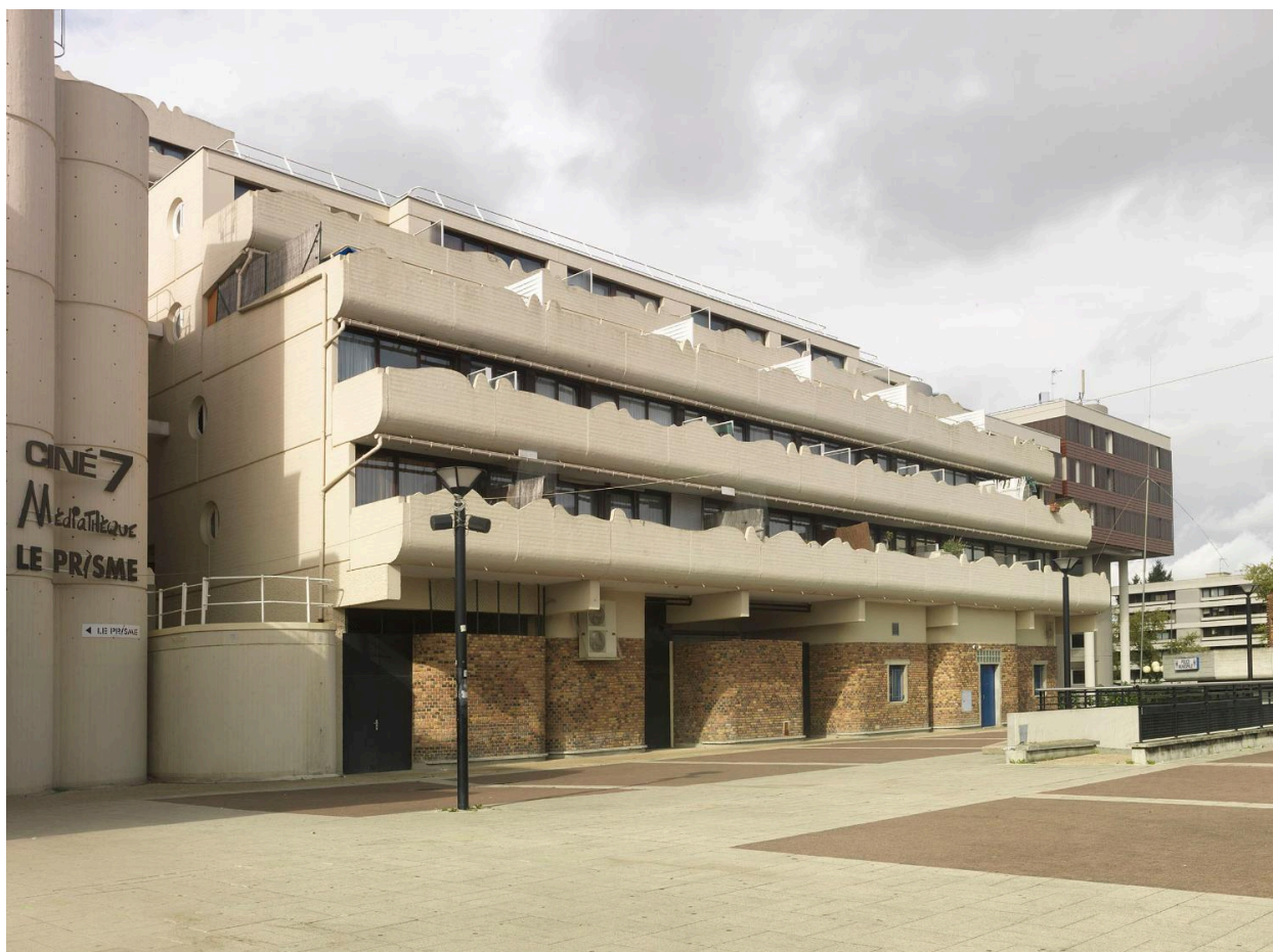
Les immeubles en gradins du cœur de la dalle des Sept-Mares (architectes : Martine et Philippe Deslandes).
