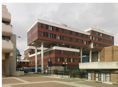
Le centre administratif des Sept-Mares. Inauguré en 1978, il est l'œuvre des architectes Jacques Kalisz, Roger Salem et François Doucot. Phot. Philippe Ayrault IVR11_20147800445NUC4A
