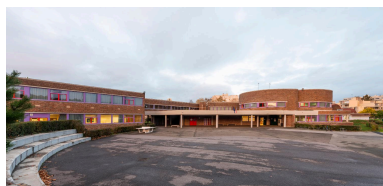
Vue générale du lycée, depuis le parvis d'entrée situé à l'est de l'édifice, du côté du parc.
