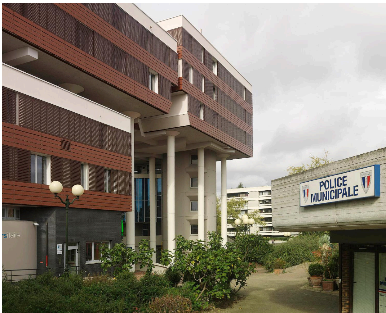
Le centre administratif des Sept-Mares.
