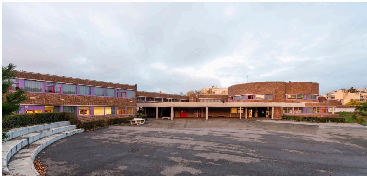
Vue générale du lycée, depuis le parvis d'entrée situé à l'est de l'édifice, du côté du parc.
