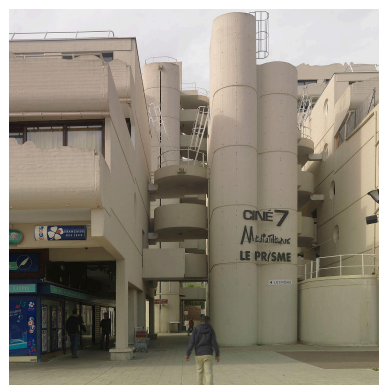
La dalle des Sept-Mares et sa rue principale. Phot. Philippe Ayrault IVR11_20147800444NUC4A
