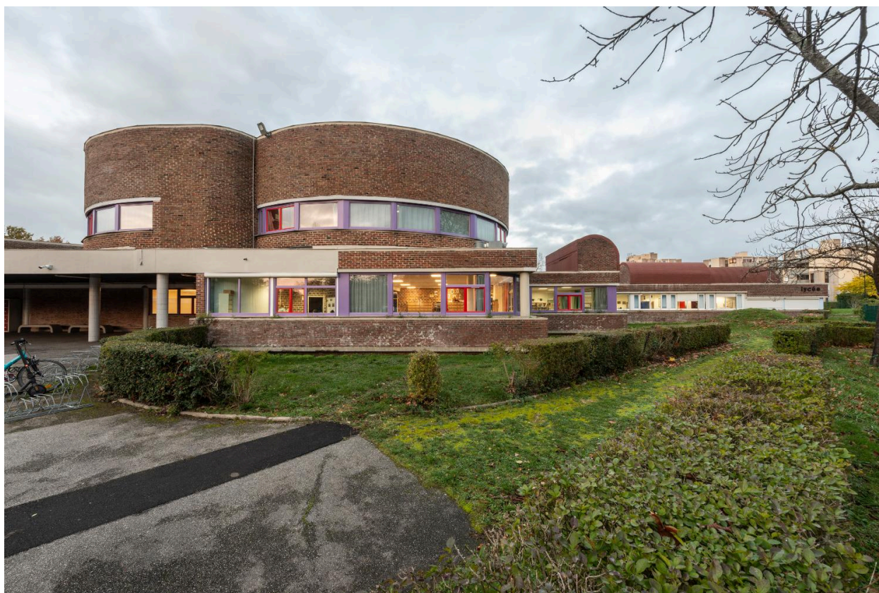
L'entrée du lycée, surplombée des deux volumes semi-cylindriques emboîtés du centre socio-culturel.
