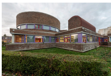
Le pôle socio-culturel et les bureaux de l'administration. Béton brut et brique de Montmorency laissée apparente se conjuguent pour souligner la simplicité des formes géométriques qui composent l'édifice.
