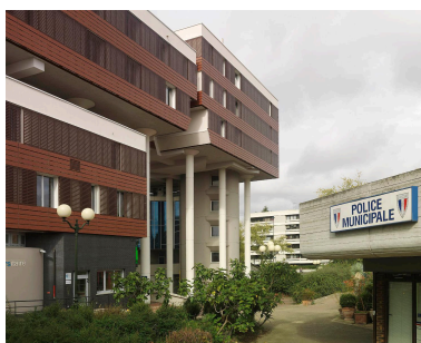
Le centre administratif des Sept-Mares. Phot. Philippe Ayrault IVR11_20147800446NUC4A
