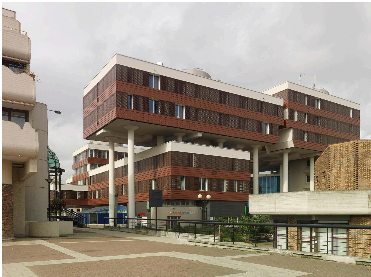
Le centre administratif des Sept-Mares. Inauguré en 1978, il est l'œuvre des architectes Jacques Kalisz, Roger Salem et François Doucot.
