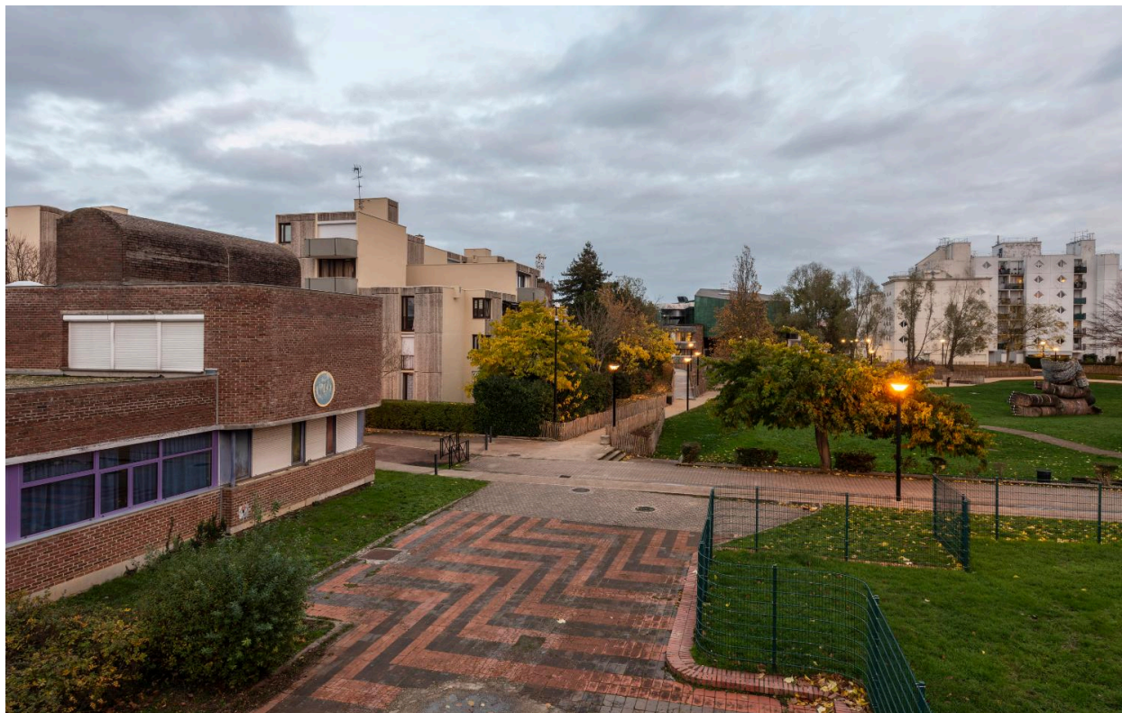
Le cheminement piéton du 1% artistique, conduisant vers la dalle des Sept-Mares et le cœur du centre-ville.
