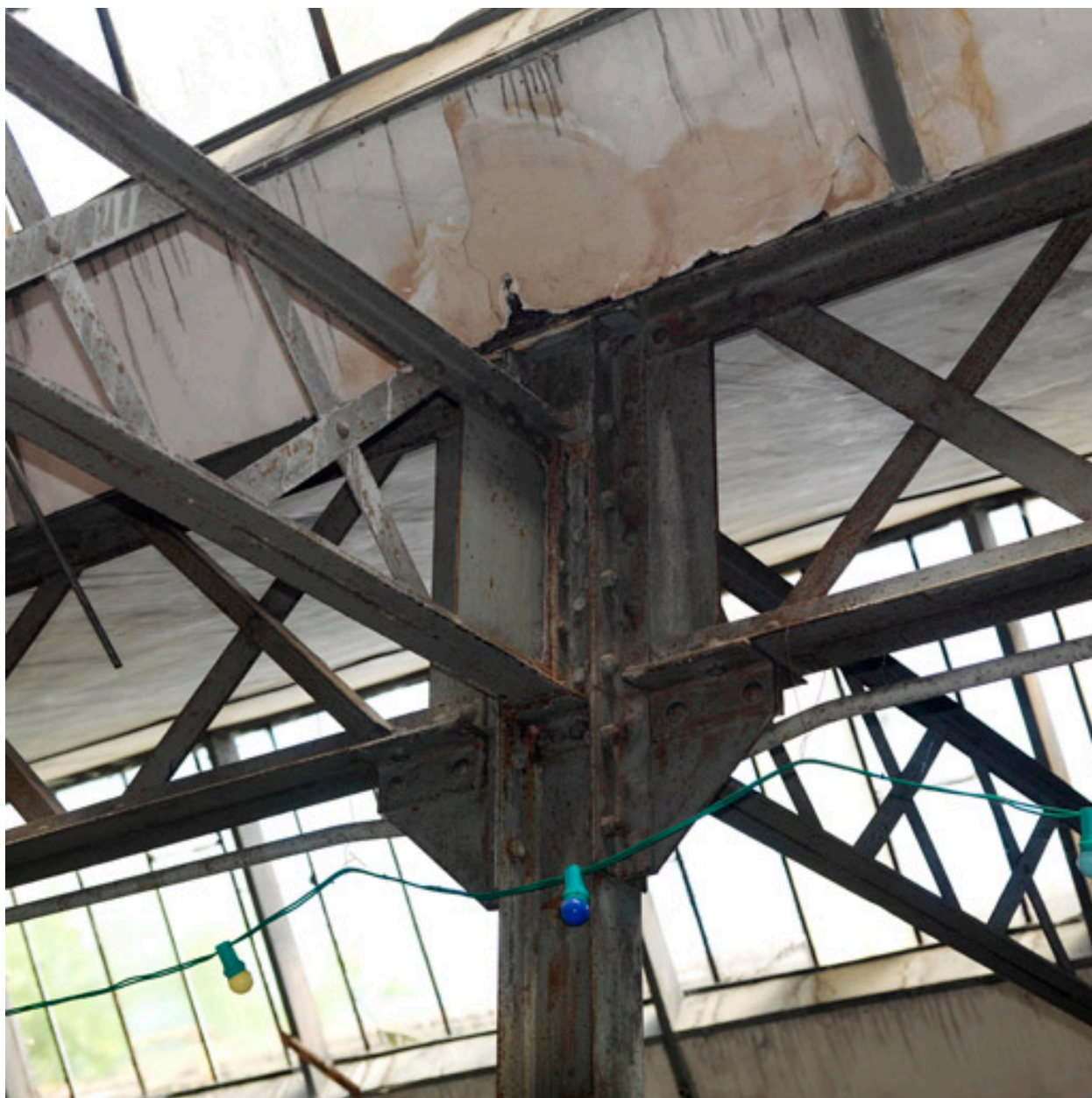
Vue intérieure. Verrière, détail de la structure métallique.
