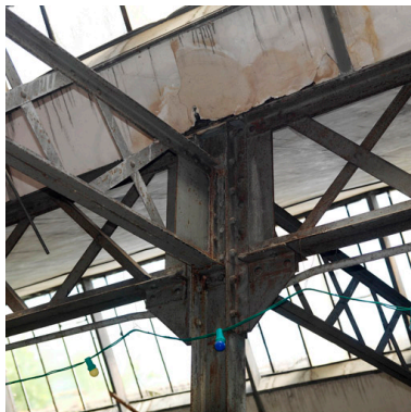
Vue intérieure du bâtiment. Verrière et structure métallique. Phot. Philippe Ayrault IVR11_20087701108NUC4A
