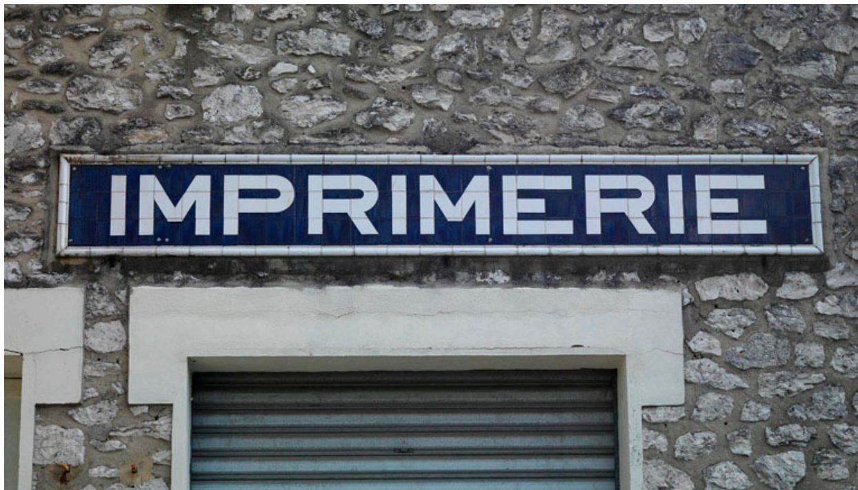
Détail de la façade avec l'enseigne de l'imprimerie.
