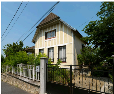
Le pavillon construit par l'entreprise Netter, dans les années 1930, au 9 rue Victor-Hugo : vue d'ensemble, avec son jardin. Phot. Jean-Bernard Vialles IVR11_20179500312NUC4A
