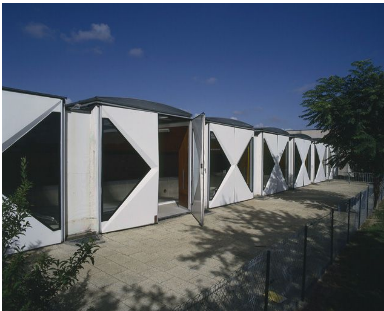
Vue latérale de la façade formée de structures modulaires préfabriquées.
