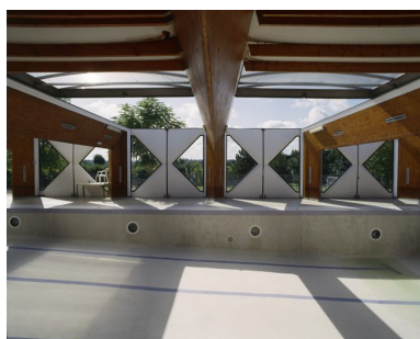
Vue intérieure : charpente en bois, panneaux-portes en polyester armé avec vitrage, éléments de toiture mobiles en PVC au dessus du bassin en béton armé.
