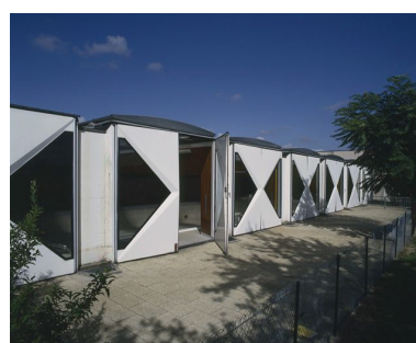
Vue latérale de la façade formée de structures modulaires préfabriquées. Phot. Philippe IVR11_20069101111XA
