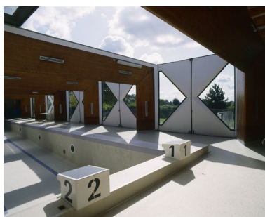
Vue intérieure : la super structure est formée de panneaux et de poutres et poteaux.
