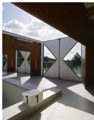
Vue intérieure : un panneau-porte en polyester armé avec vitrage entre deux éléments poutres et poteaux.
