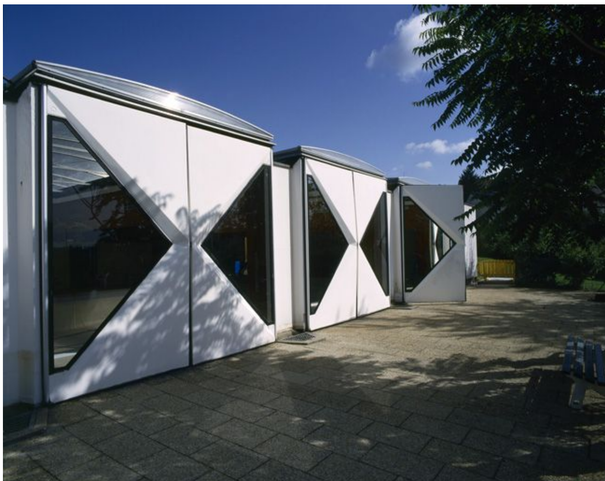
Détail des structures modulaires préfabriquées : parement extérieur.
