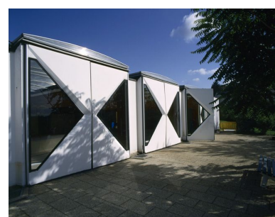
Détail des structures modulaires préfabriquées : parement extérieur. Phot. Philippe IVR11_20069101113XA
