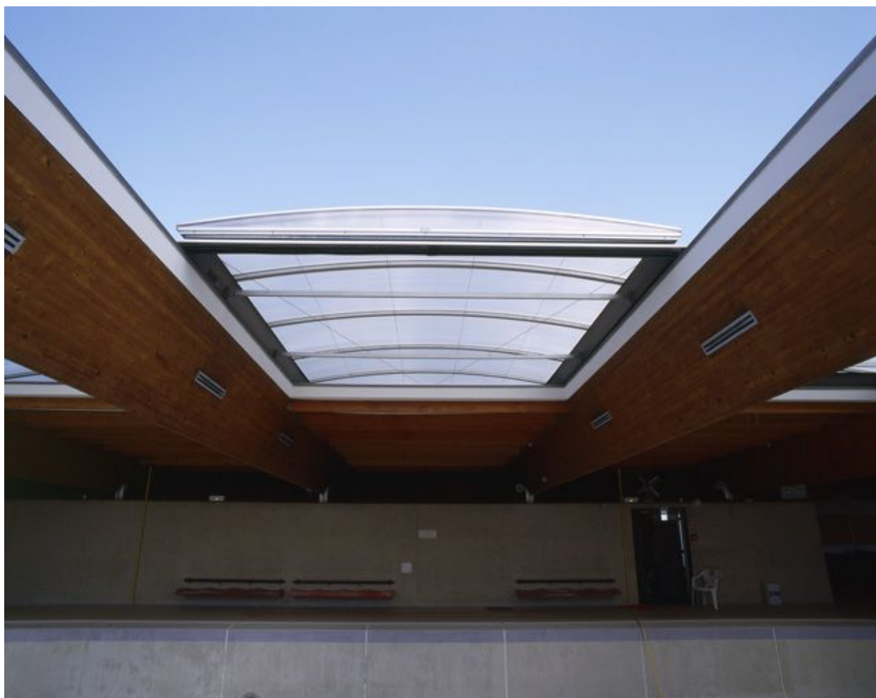
Vue intérieure : détail d'un élément de toiture mobile en PVC, double paroi, et manoeuvré électriquement.
