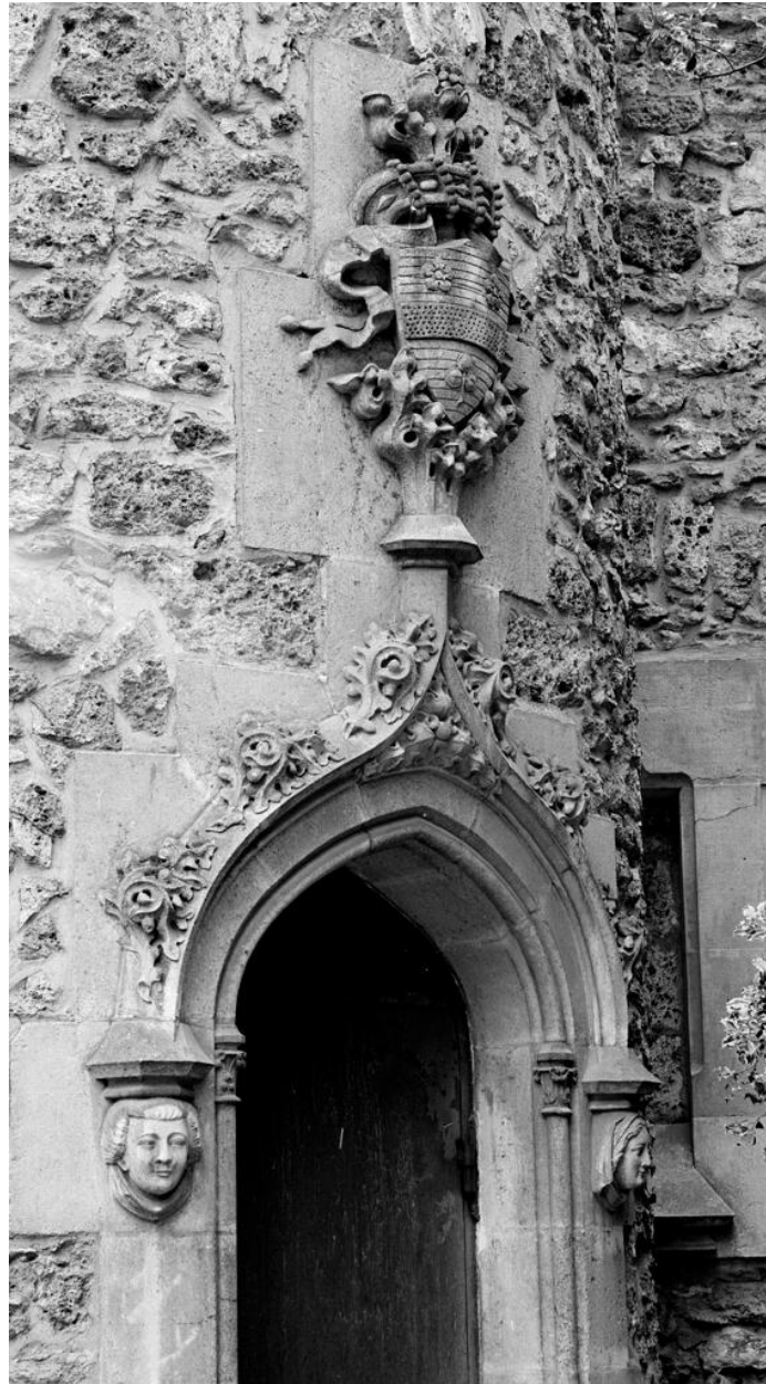
Détail de la porte donnant accès à une tour d'escalier.
