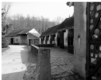
Les écuries. Phot. Christian Décamps IVR11_20007800194X
