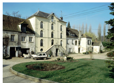
A gauche, l'ancien moulin. Au centre, le moulin reconstruit transformé en habitation. A droite, l'ancienne habitation du meunier. Phot. Christian Décamps IVR11_20007800176XA
