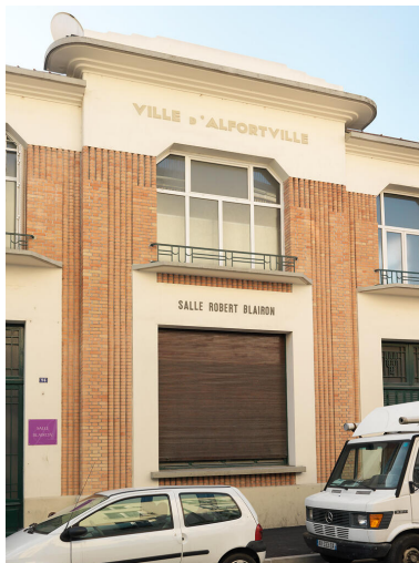
Élévation sur rue. Lavoir, Bains douches dit salle Robert Blairon Phot. Asseline Stéphane IVR11_20119400307NUC4A
