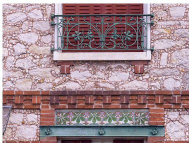
Détail de la façade du 31 rue du Général de Gaulle. Phot. Asseline Stéphane IVR11_20259100905NUC4A
