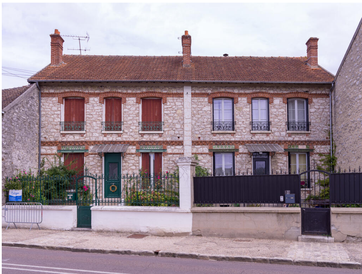
Vue générale des maisons jumelles depuis l'ouest.
