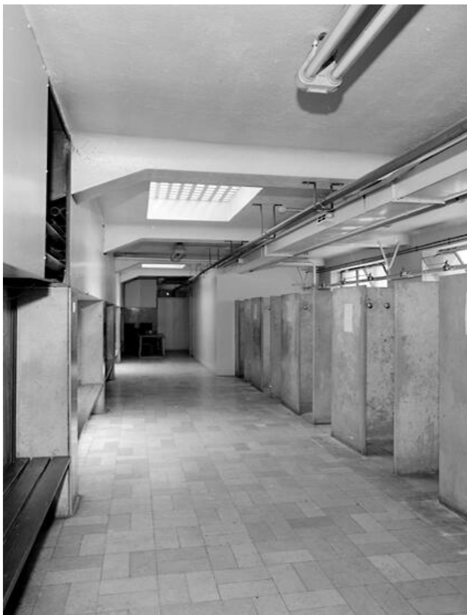
Douches et vestiaires du gymnase. Groupe scolaire dit groupe scolaire Michelet, puis Henri-Barbusse
