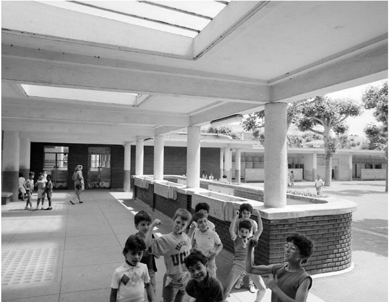
Vue du préau et de la courette d'éclairage des douches. Groupe scolaire dit groupe scolaire Michelet, puis Henri-Barbusse
