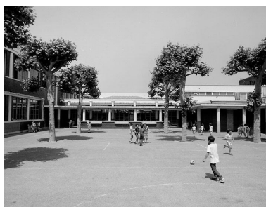
Vue de la cour de récréation, vers la courette d'éclairage des douches. Groupe scolaire dit groupe scolaire Michelet, puis Henri-Barbusse Phot. Décamps Christian IVR11_19869400540X
