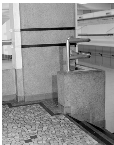
Vestibule d'accès au gymnase. Détail des rambardes en inox et du carrelage. Groupe scolaire dit groupe scolaire Michelet, puis Henri-Barbusse Phot. Décamps Christian IVR11_19869400544X
