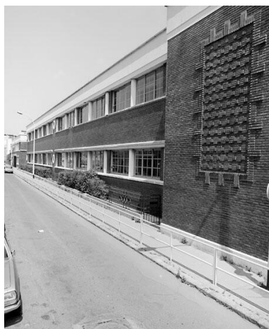
Vue de la façade, rue Alexis-Chaussinand. Groupe scolaire dit groupe scolaire Michelet, puis Henri-Barbusse Phot. Décamps Christian IVR11_19869400539X
