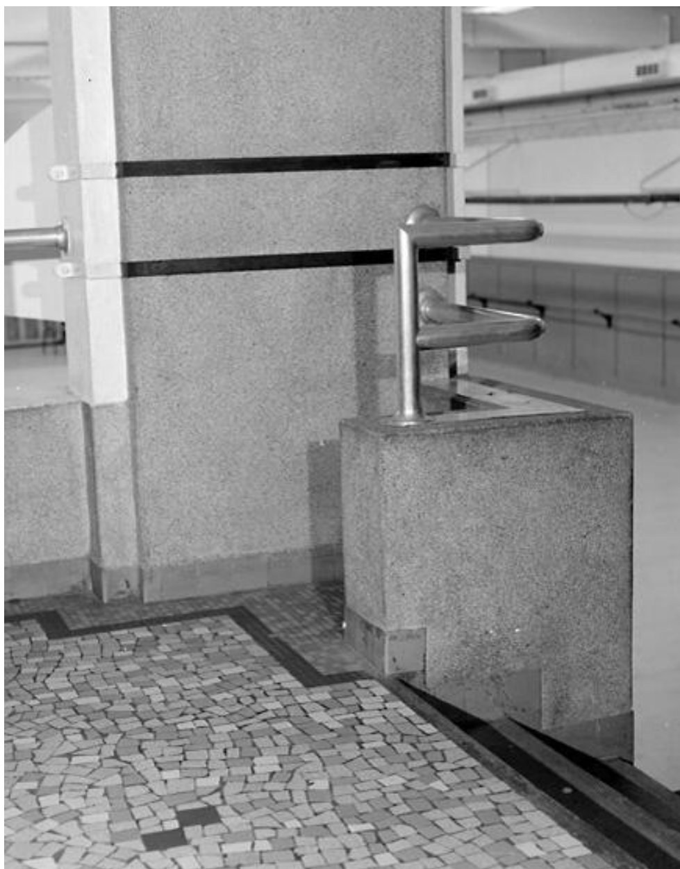
Vestibule d'accès au gymnase. Détail des rambardes en inox et du carrelage. Groupe scolaire dit groupe scolaire Michelet, puis Henri-Barbusse
