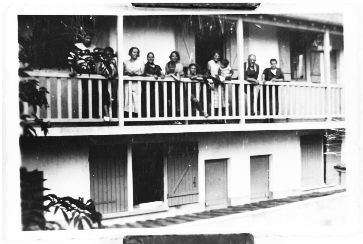
Vue du bâtiment d'habitation en aile, composé de six chambres et deux cuisines, détruit par le bombardement.
