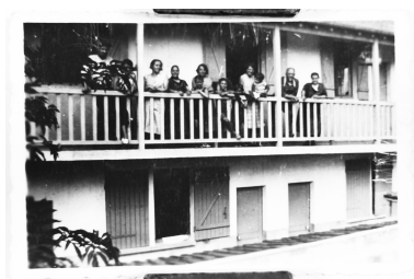
Vue du bâtiment d'habitation en aile, composé de six chambres et deux cuisines, détruit par le bombardement. IVR11_20039100164XB
