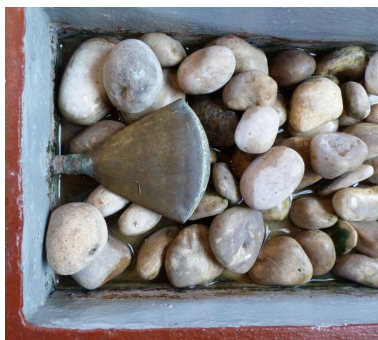
Vue de détail sur le déversoir des fonts baptismaux. Phot. Thierry Lefébure IVR32_20170205437NUCA
