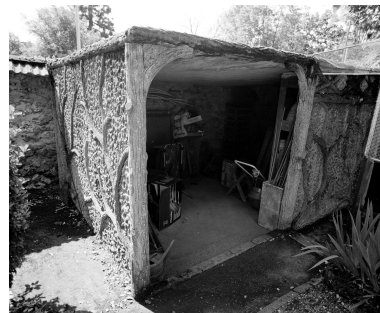
Cabane de jardin en ciment imitant le bois écoté. Phot. Philippe Ayrault IVR11_20029100820X
