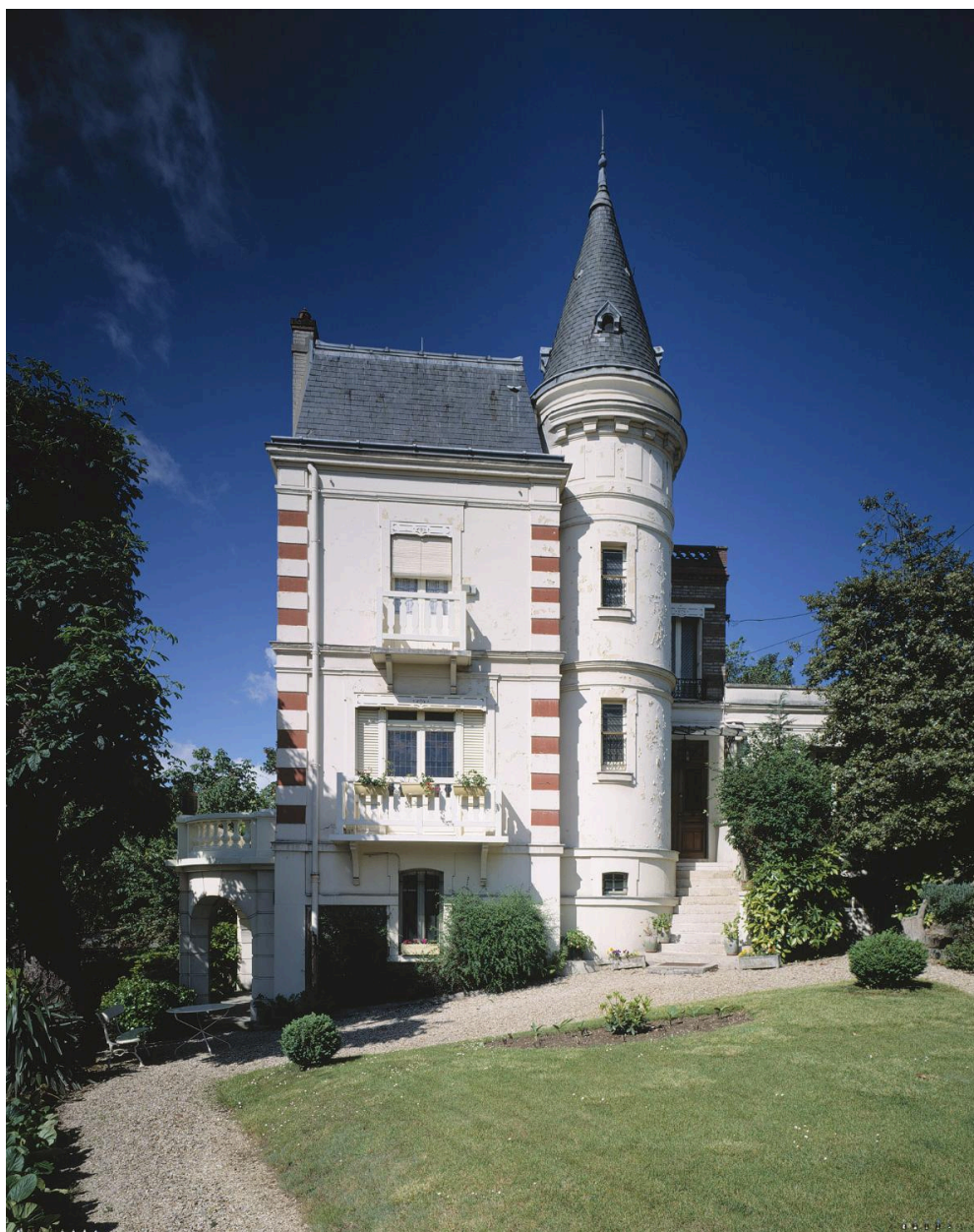
Vue de la façade latérale est.
