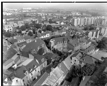
Au premier plan les quartiers anciens et au fond la résidence de la Tour et la résidence Saint-Maclou. Phot. Pascal Corbière IVR11_19777800701X
