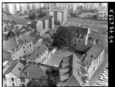
Vue de la couture entre les quartiers anciens et les Bas quartiers reconstruits en 1960. Phot. Pascal Corbière IVR11_19777800699X
