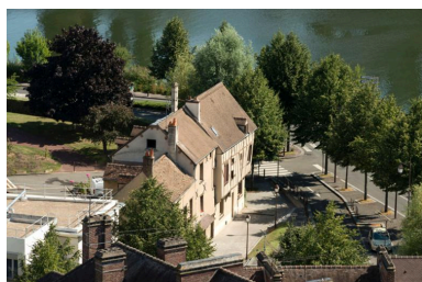
Les seules maisons restées en place à la suite de la résorption de l'habitat insalubre. Phot. Laurent Kruszyk IVR11_20177800885NUC4A
