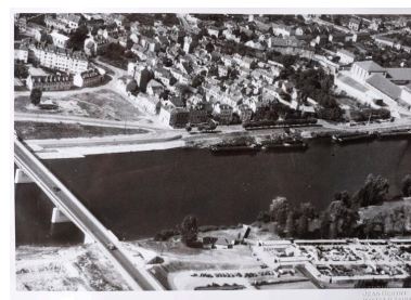
Vue de la limite des destructions dues aux bombardements. L'îlot à l'arrière de la rue de la Gabelle est intact. (Fonds CREDOP. Cliché Bertin) Phot. Laurent Kruszyk, Phot. Bertin IVR11_20177800529NUC4A
