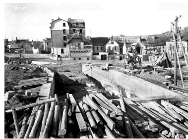
Les bas quartiers en cours de reconstruction. Au second plan, la partie non détruite par les bombardements. (Fonds Bertin). Phot. Bertin IVR11_20177800624NUC2B
