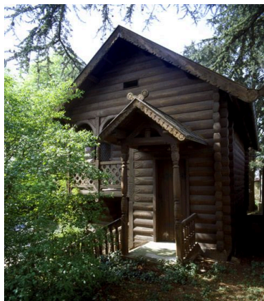
Détail de l'entrée. Phot. Stéphane Asseline IVR11_20079400287XA
