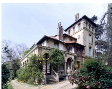
Vue générale de la villa. Phot. Stéphane Asseline IVR11_20079400277VA
