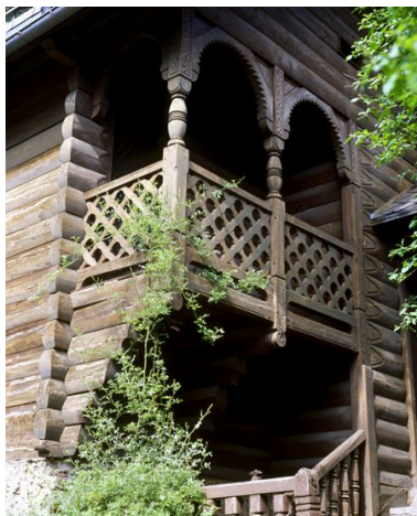
Détail de la galerie du pavillon. Phot. Stéphane Asseline IVR11_20079400291XA
