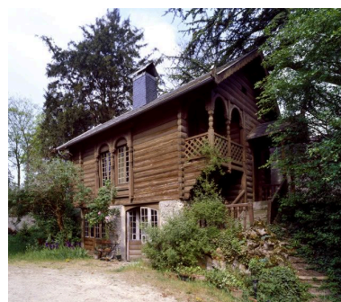
Le pavillon scandinave construit par Charles Garnier pour la section de "L'Histoire de l'habitation humaine" sur le Champs de Mars à l'Exposition universelle de 1889. Phot. Stéphane Asseline IVR11_20079400283VA
