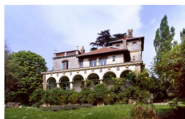
Vue générale de la façade sud où se lisent les quatre volumes principaux de la maison, constituée d'une galerie, un corps de logis flanqué d'une aile latérale, et une tour belvédère à l'arrière. Phot. Stéphane Asseline IVR11_20079400275VA
