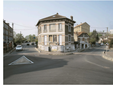
Vue d'ensemble. Phot. Philippe Ayrault IVR11_20029100457XA
