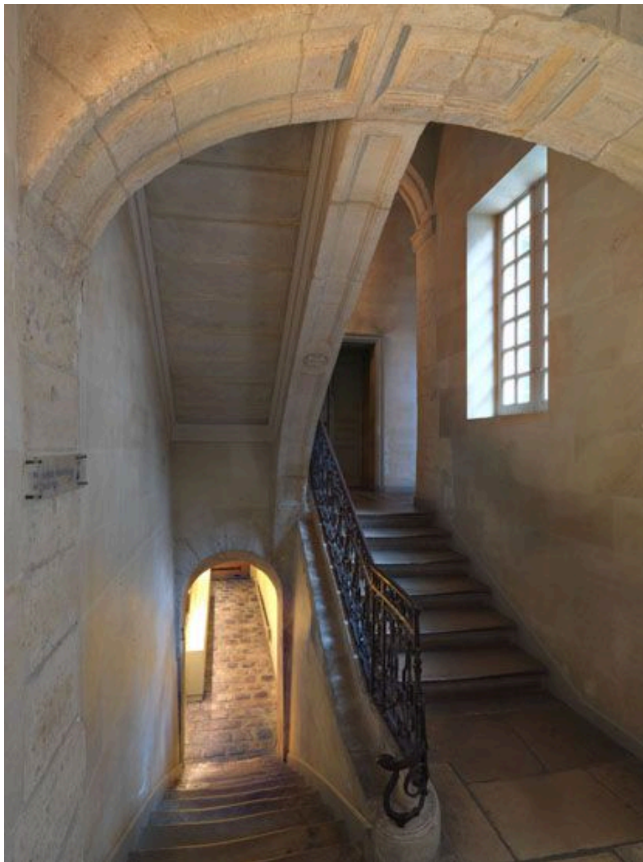
Vue d'ensemble du départ de l'escalier et de l'accès au jardin.
