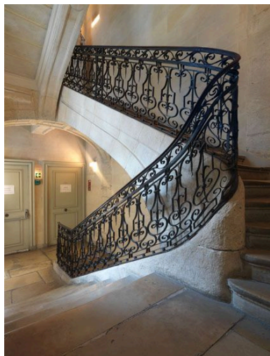
Vue d'ensemble des deux premières volées. Phot. Laurent Kruszyk IVR11_20097501905NUC4A
