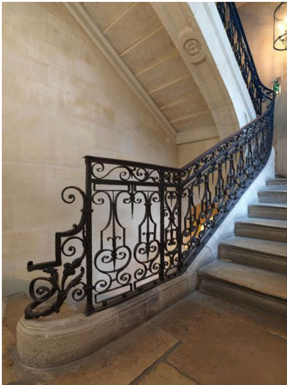
Vue du départ de l'escalier avec la console, un panneau droit et des panneaux rampants.
