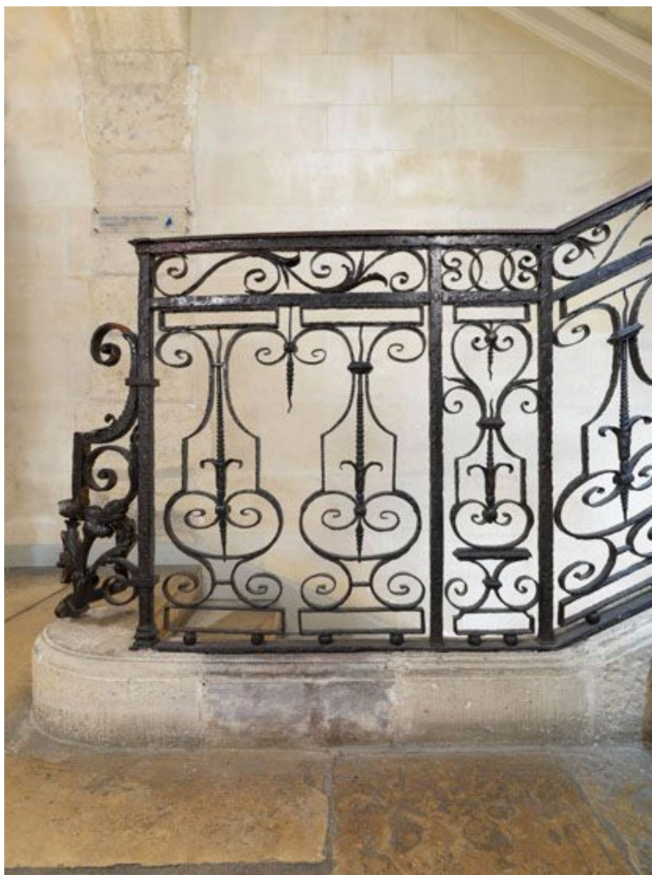
Vue de la console de départ, du panneau droit et du premier pilastre.
