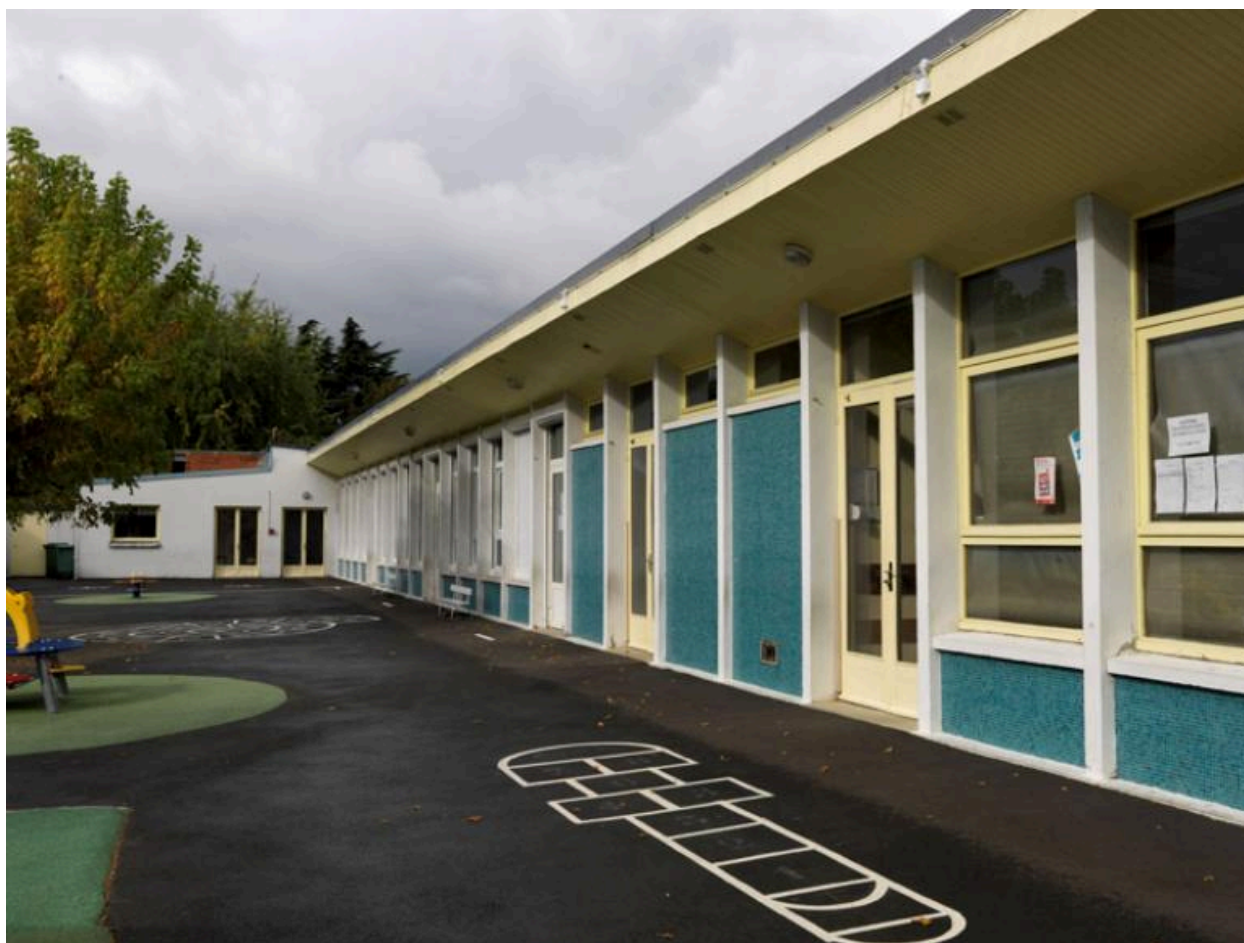
Vue d'ensemble de la façade sur cour
