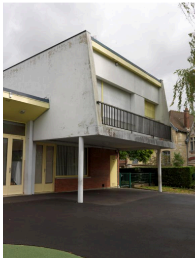
Vue du logement de fonction Phot. Laurent Kruszyk IVR11_20167800572NUC4A
