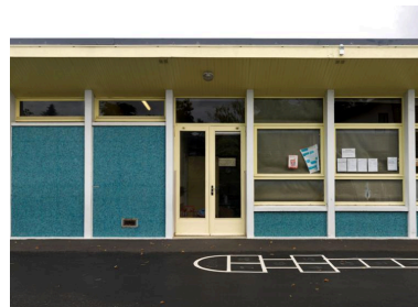
Façade d'une classe dans son état d'origine Phot. Laurent Kruszyk IVR11_20167800574NUC4A
