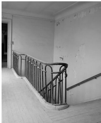
La rampe d'escalier, au niveau de l'étage. Phot. Décamps Christian IVR11_19989400167X
