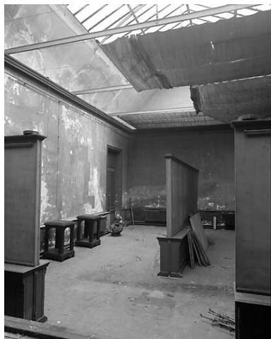
Vue intérieure du pavillon du "musée" avant restauration. Phot. Décamps Christian IVR11_19989400170X
