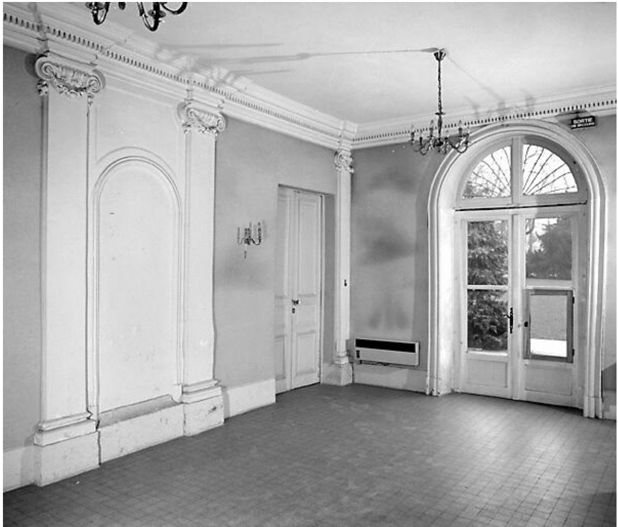
Vue d'ensemble du vestibule.
