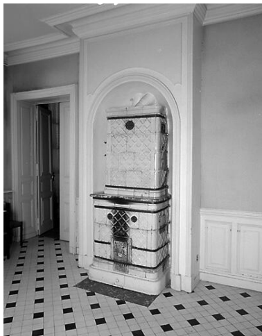
Le poêle de la salle à manger. Phot. Décamps Christian IVR11_19989400168X
