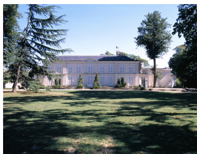
Vue d'ensemble de la façade sur le parc. Phot. Asseline Stéphane IVR11_20029400131XA
