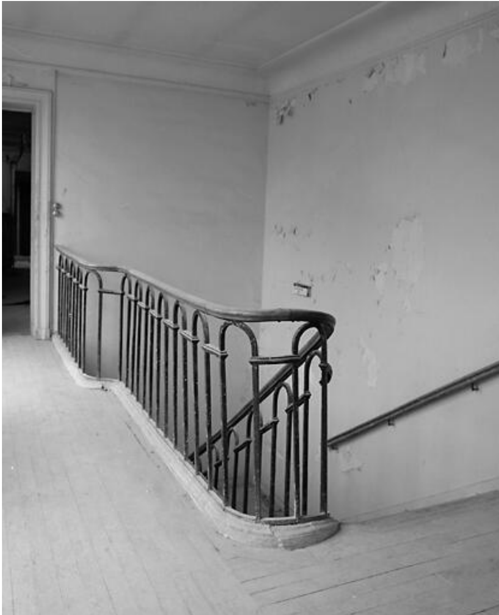
La rampe d'escalier, au niveau de l'étage.
