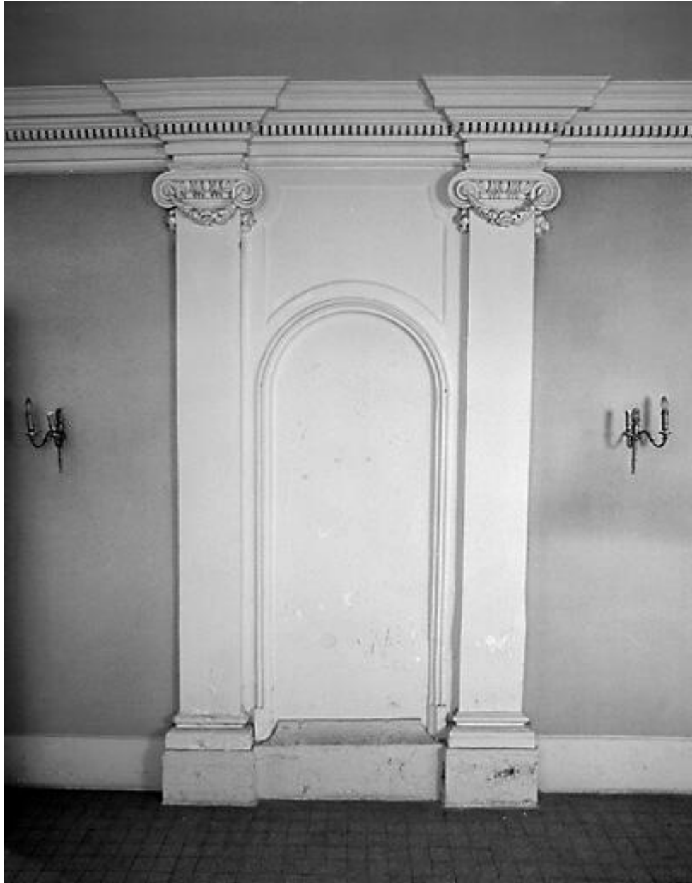
Le vestibule : niche encadrée de pilastres ioniques.
