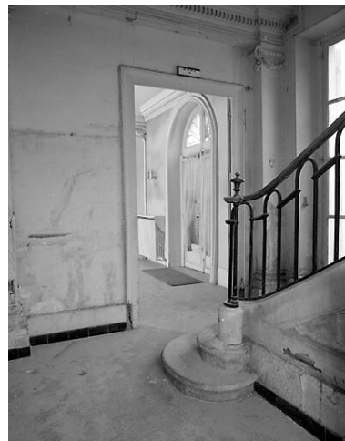
Le départ de l'escalier. La rampe, typique de la seconde moitié du XVIIIe s., est composée de simples arcades reliées par des étriers. Phot. Décamps Christian IVR11_19989400166X
