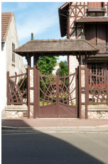
Le portail d'entrée a conservé son décor en pitchpin et ses épis de faîtage. Phot. Laurent Kruszyk IVR11_20177800358NUC4A
