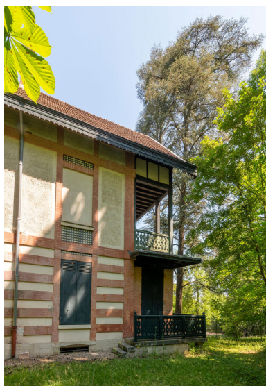
Façade postérieure. IVR11_20237800169NUC4A
