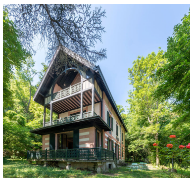
La façade latérale est, qui concentre tout le caractère pittoresque de la maison, a des allures de façade principale. IVR11_20237800167NUC4A
