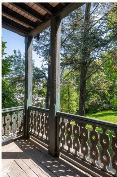
Le balcon de la chambre d'Ivan Tourgueniev, avec vue sur la maison Viardot et sur la Seine au loin. IVR11_20237800170NUC4A
