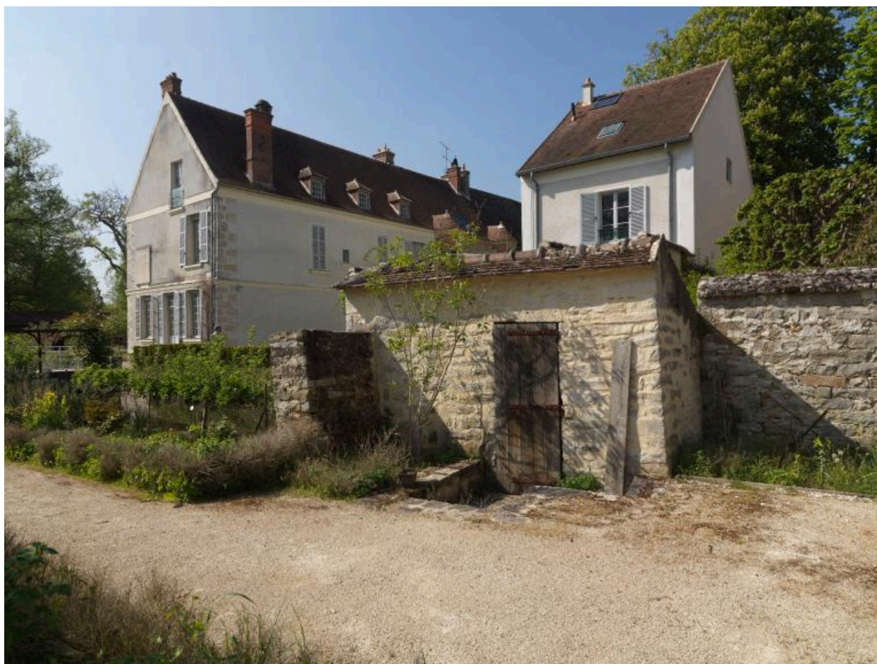
Vue du mur de cloture
