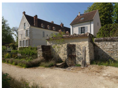
Vue du mur de clôture Phot. Philippe Ayrault IVR11_20199100105NUC4A
