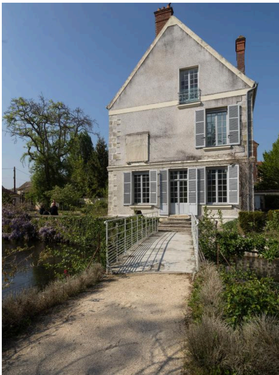
Vue du mur pignon du bâtiment principal (3)
