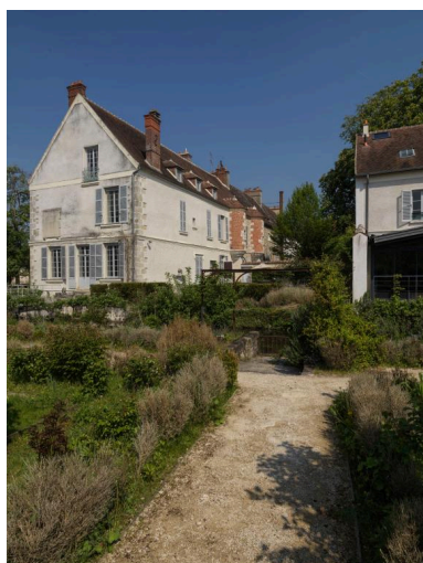
Vue d'ensemble de la propriété (3)
