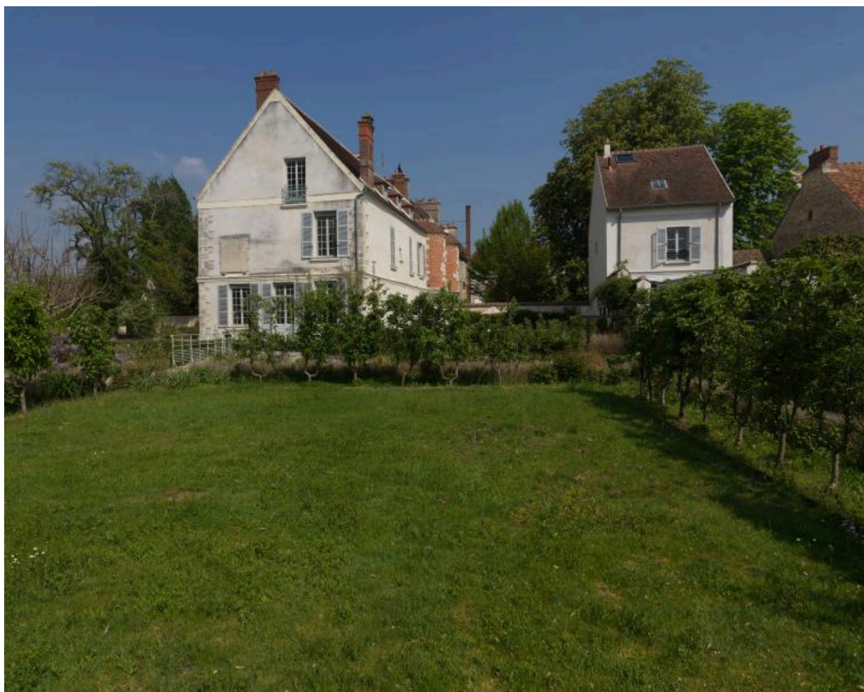
Vue d'ensemble de la propriété (2)
