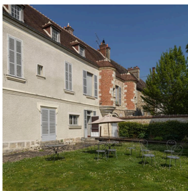
Vue de la façade du bâtiment principal
