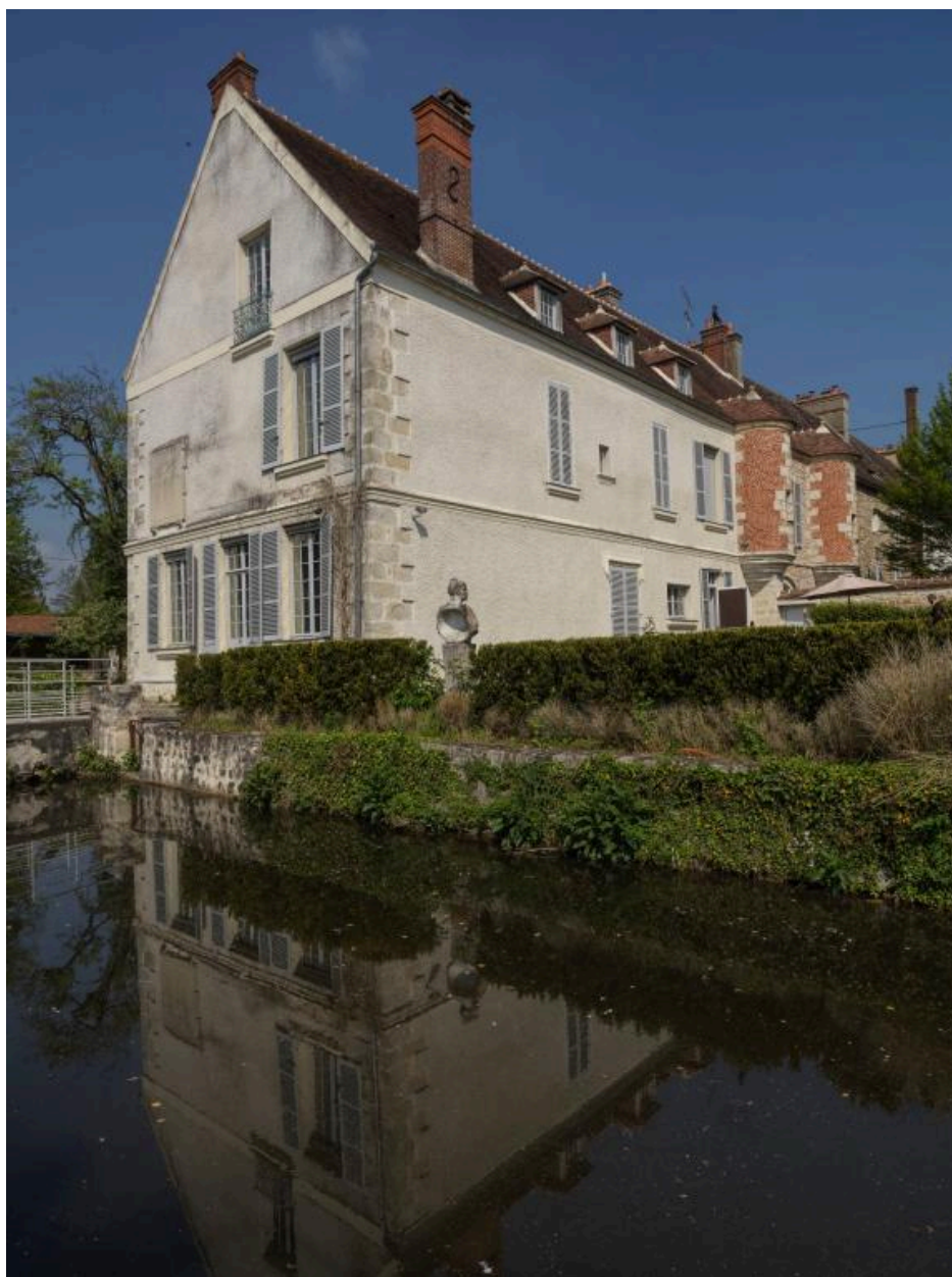
Vue du bâtiment principal (2)
