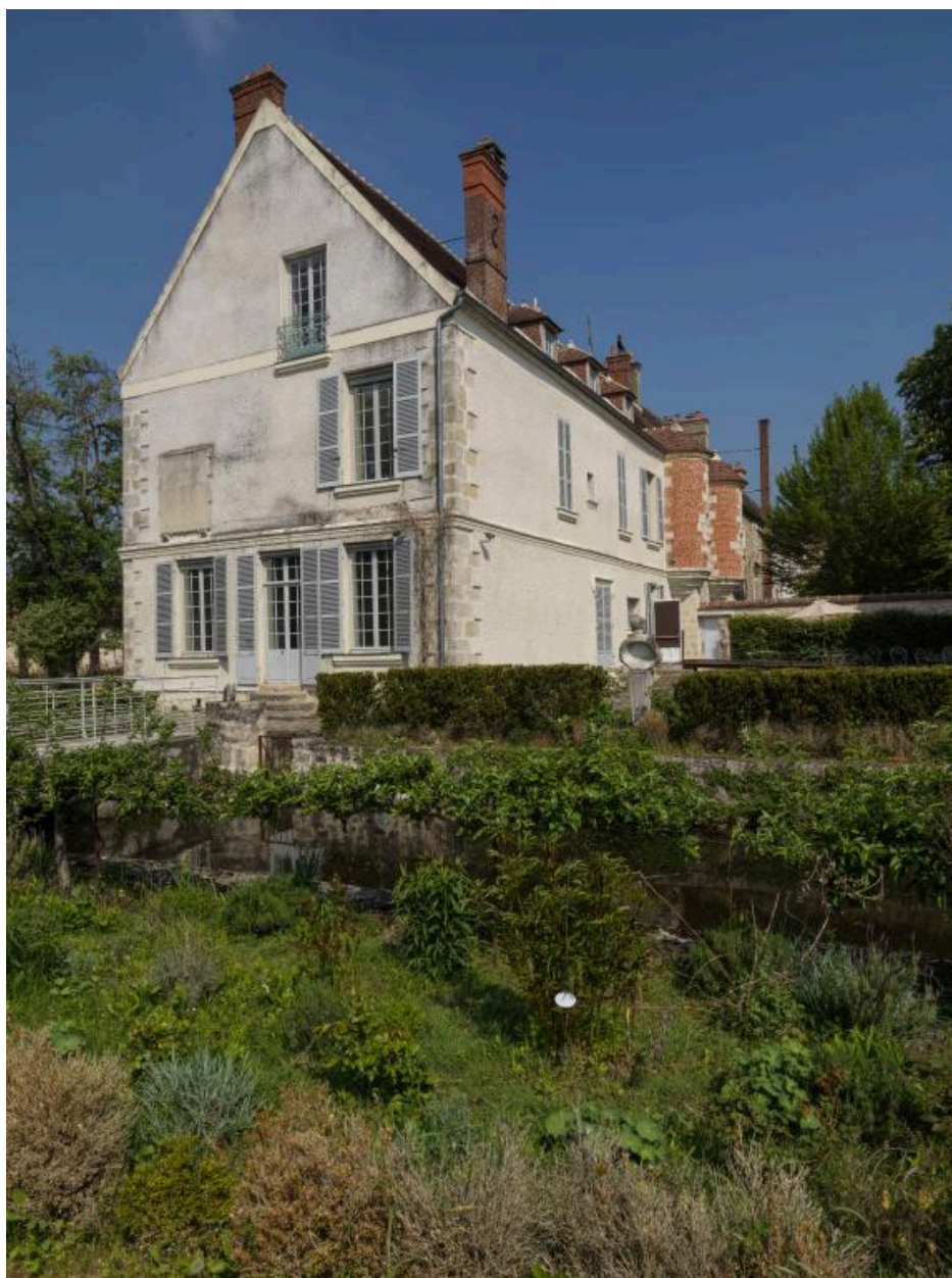
Vue du bâtiment principal (1)
