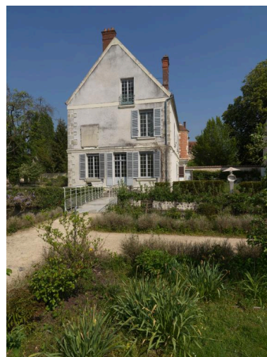
Vue du mur pignon du bâtiment principal (1) Phot. Philippe Ayrault IVR11_20199100093NUC4A
