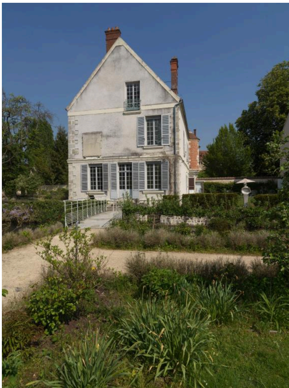
Vue du mur pignon du bâtiment principal (1)
