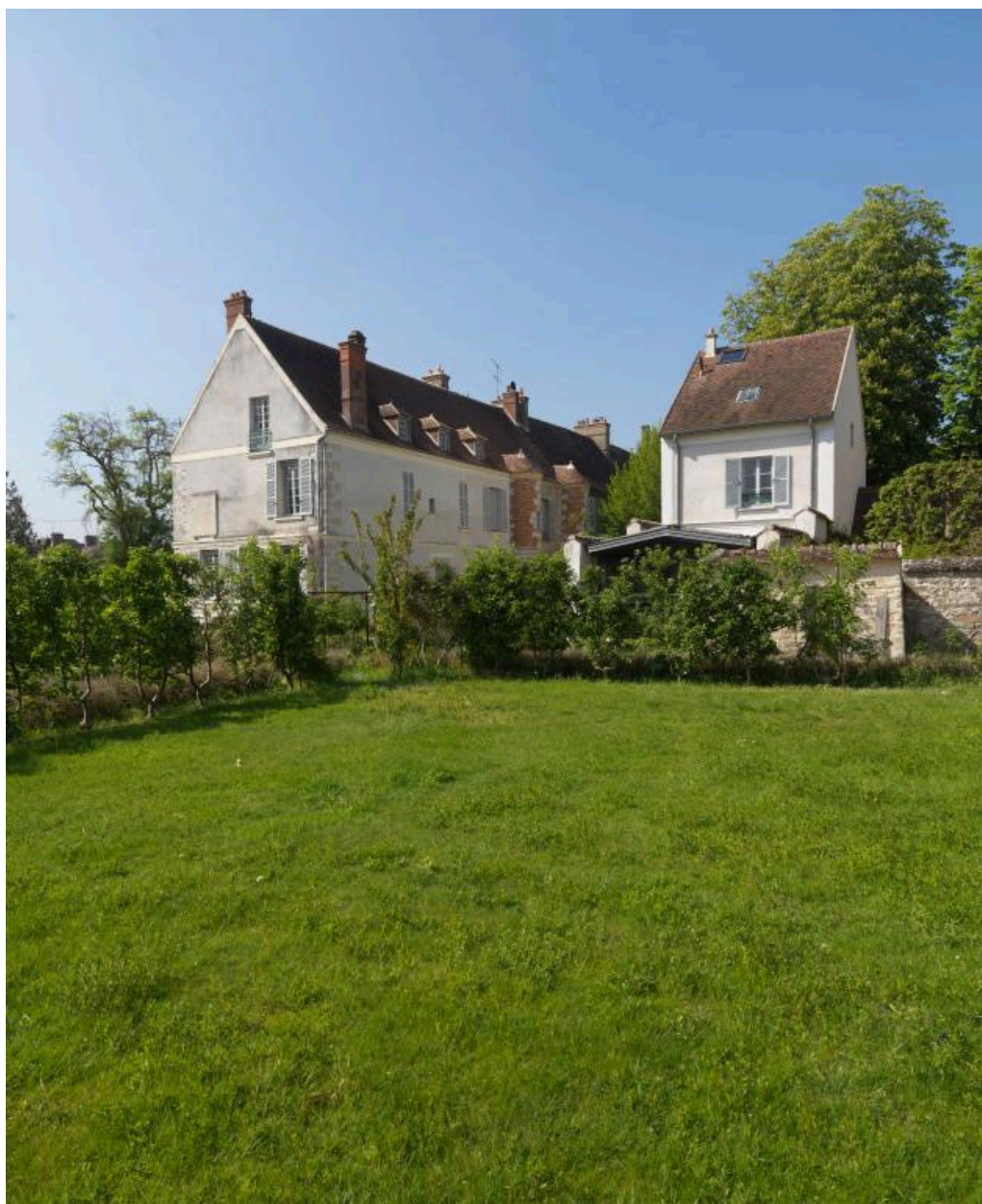
Vue du bâtiment principal et du pavillon
