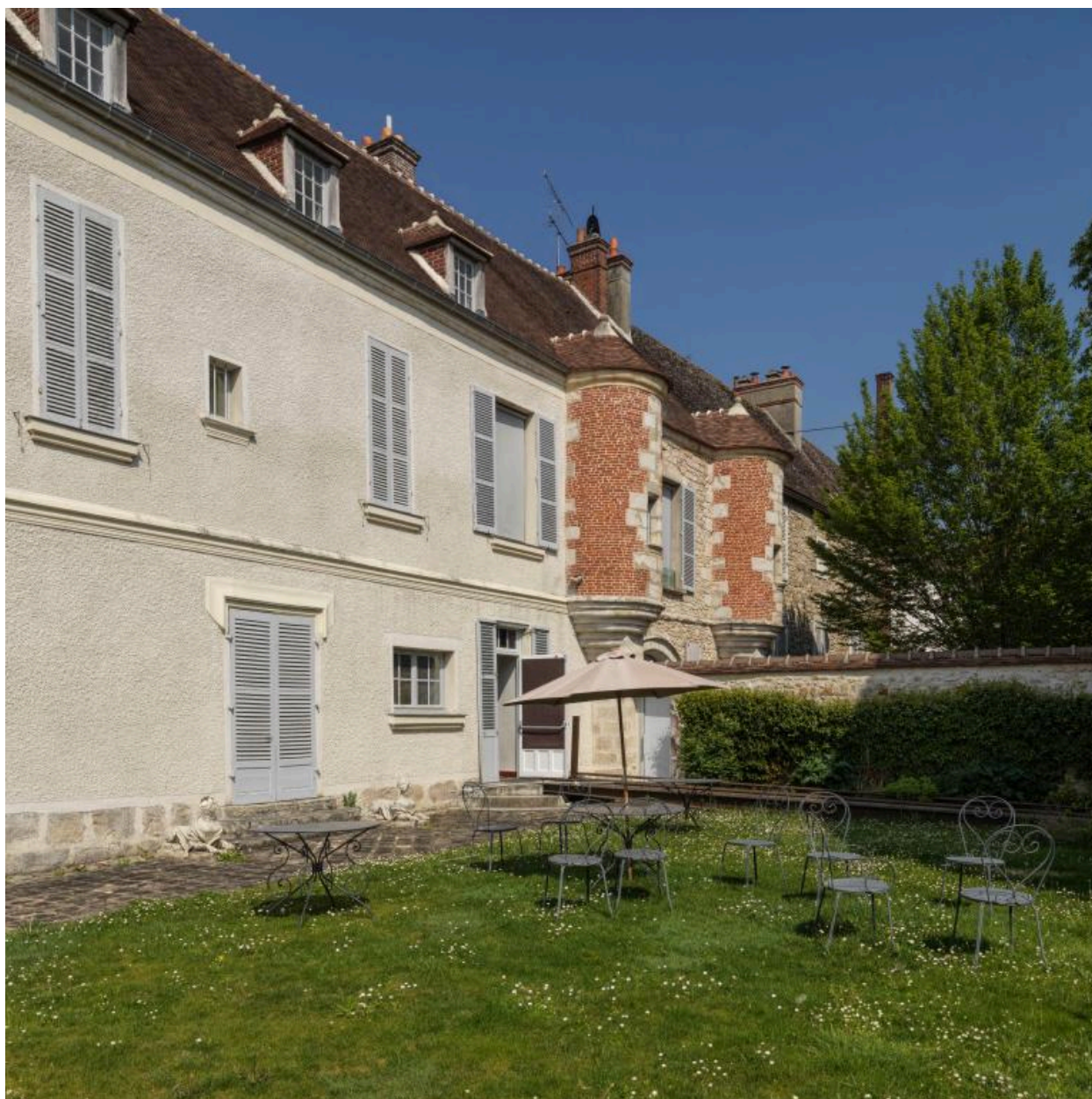
Vue de la façade du bâtiment principal
