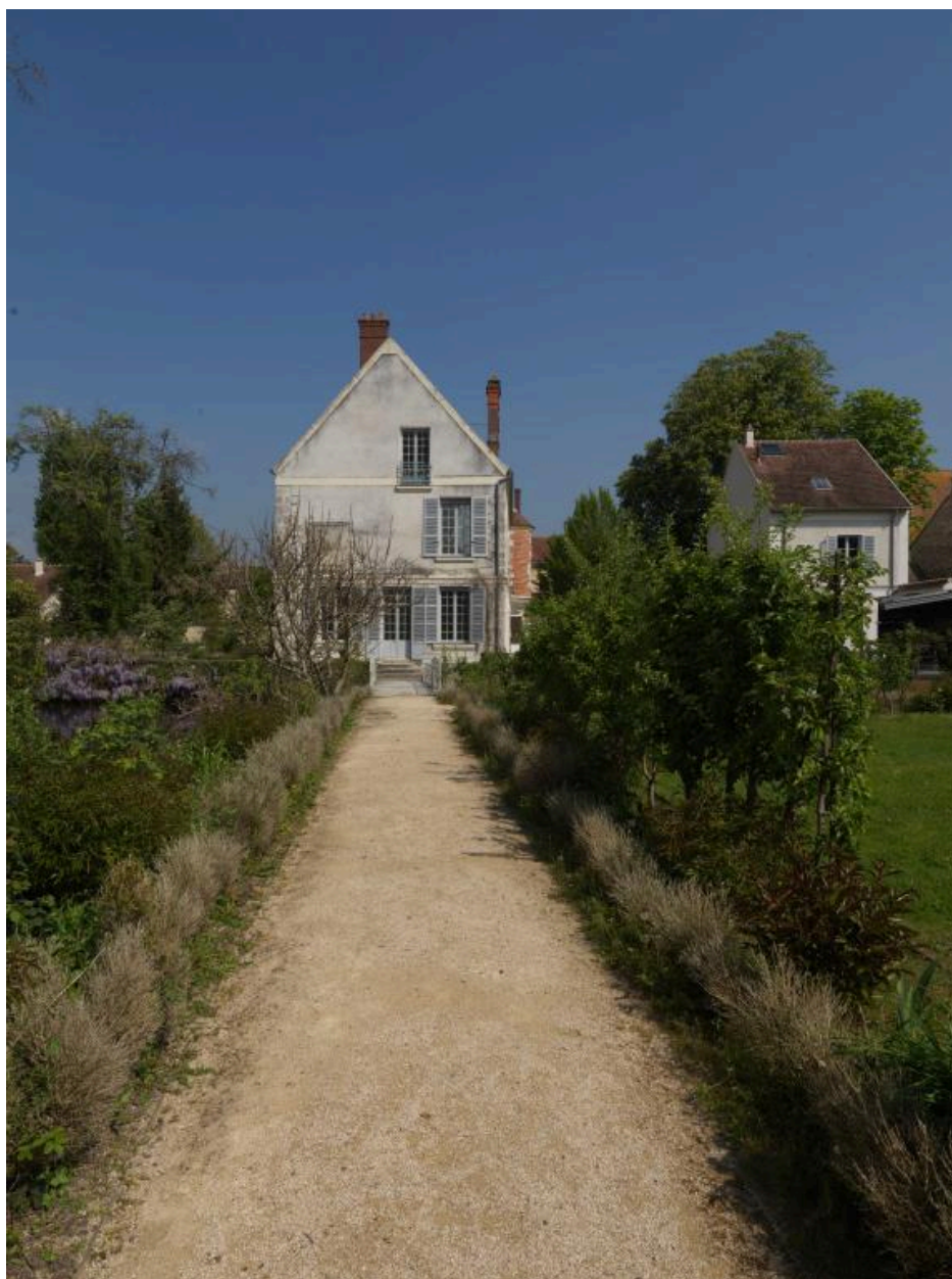
Vue du mur pignon du bâtiment principal (2)
