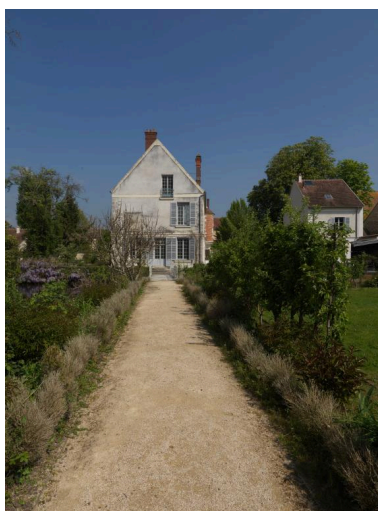
Vue du mur pignon du bâtiment principal (2) Phot. Philippe Ayrault IVR11_20199100096NUC4A
