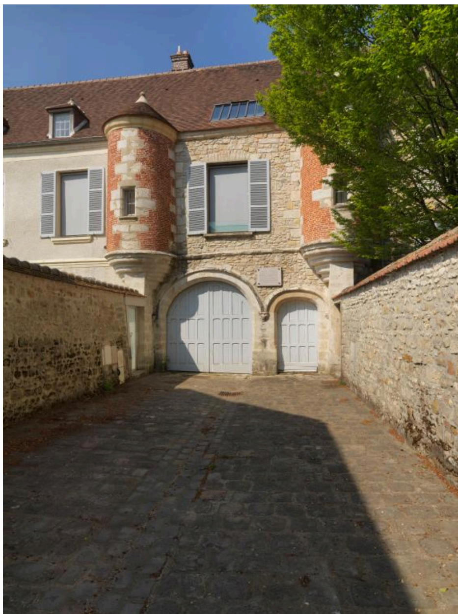
Vue de l'entrée de la Maison du Bailly, rue du Lau
