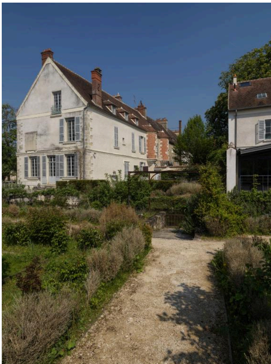
Vue d'ensemble de la propriété (3)
