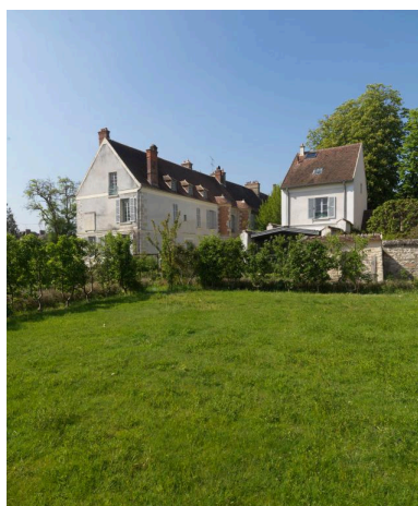
Vue du bâtiment principal et du pavillon Phot. Philippe Ayrault IVR11_20199100106NUC4A
