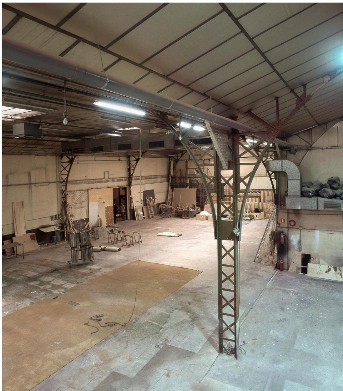
Vue intérieure de la halle d'étirage, charpente métallique (v. 1922) dérivée du type De Dion.
