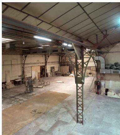
Vue intérieure de la halle d'étirage, charpente métallique (v. 1922) dérivée du type De Dion.
