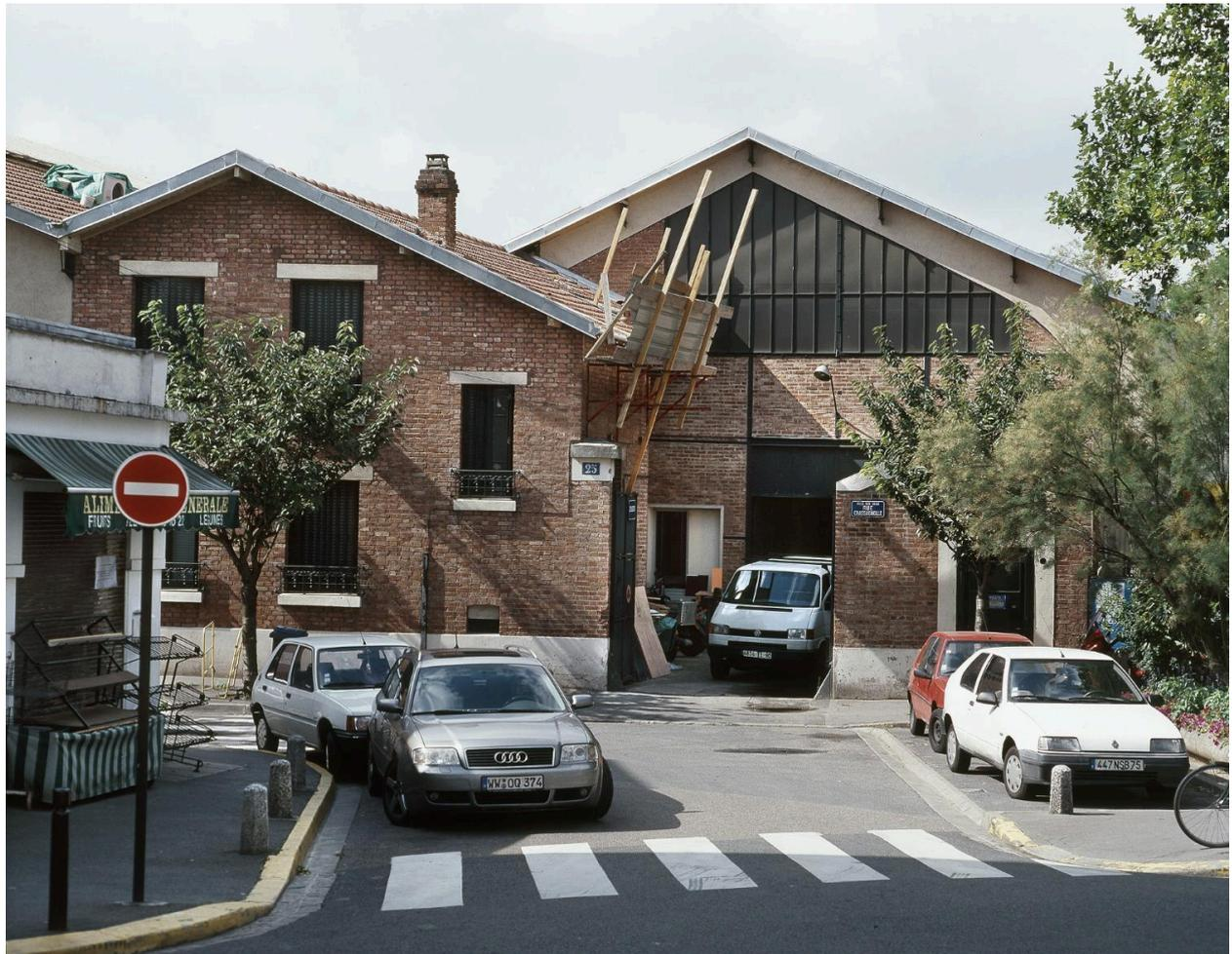
De gauche à droite, la loge du gardien, la halle du magasin à tubes et le poste transformateur. Le pignon de la halle révèle le choix d'une charpente inspirée du type De Dion.
