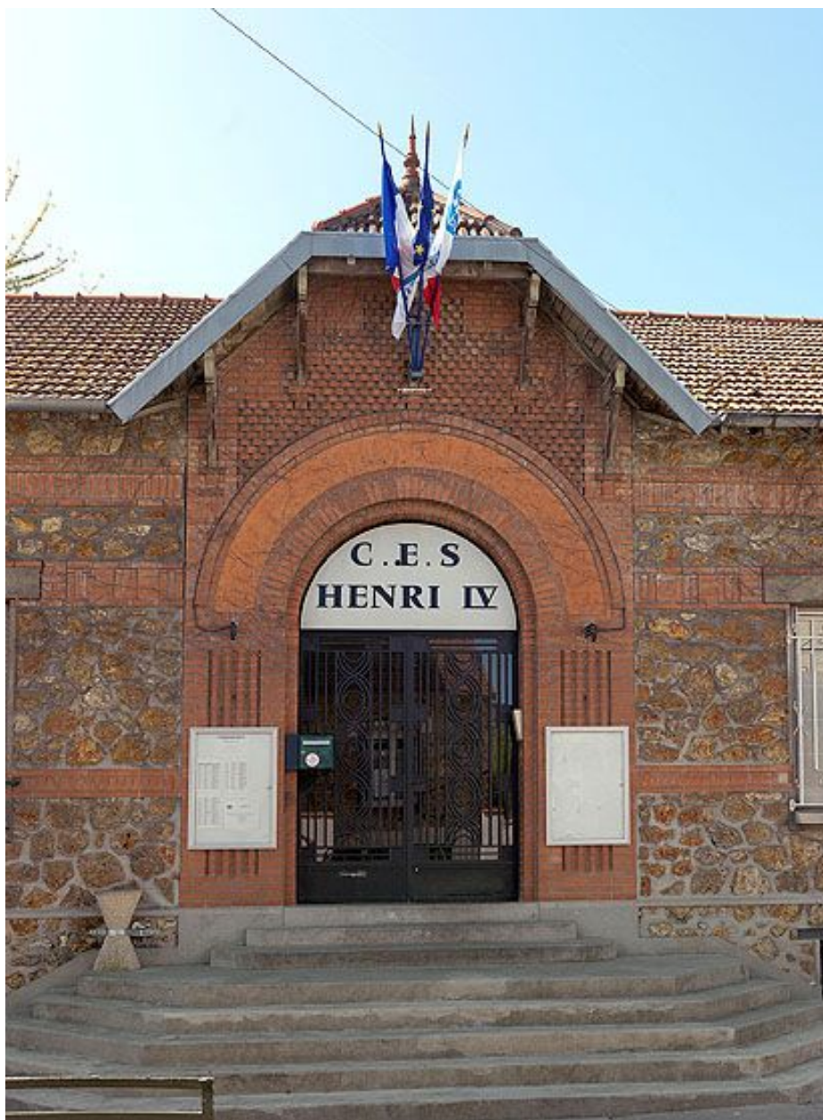
La façade du collège Henri IV : vue de la porte d'entrée.
