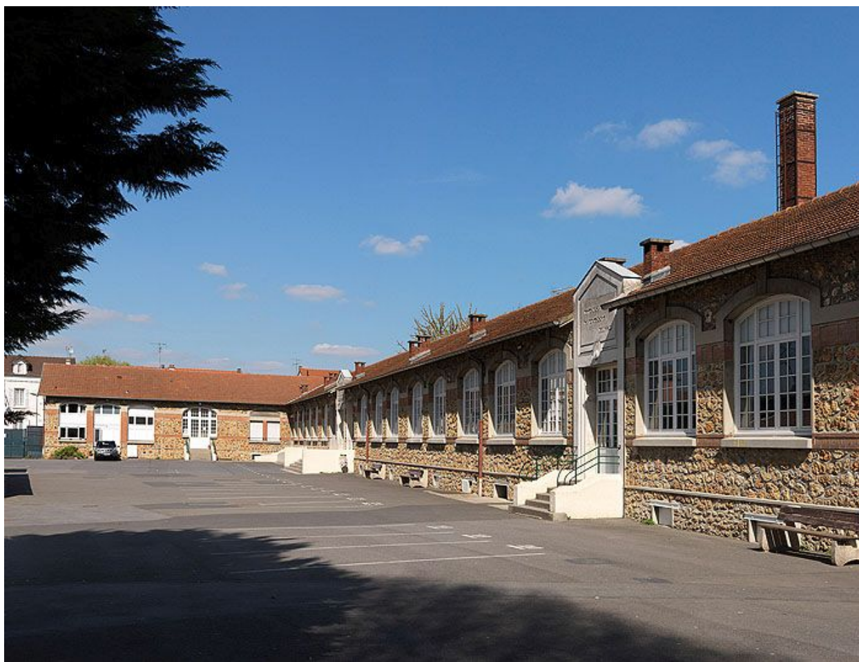
Le collège Henri IV : vue d'ensemble, depuis le sud nord-ouest. Au premier plan, l'aile des classes et la cour. Dans le fond, le revers du bâtiment longeant la rue Fatou et abritant l'administration.
