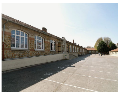
Le collège Henri IV : l'aille des classes, reliant la façade du collège sur la rue Fatou et l'école primaire Pasteur (visible au fond). Elévation occidentale, vue du nord-ouest. Phot. Jean-Bernard Vialles IVR11_20147700262NUC4A
