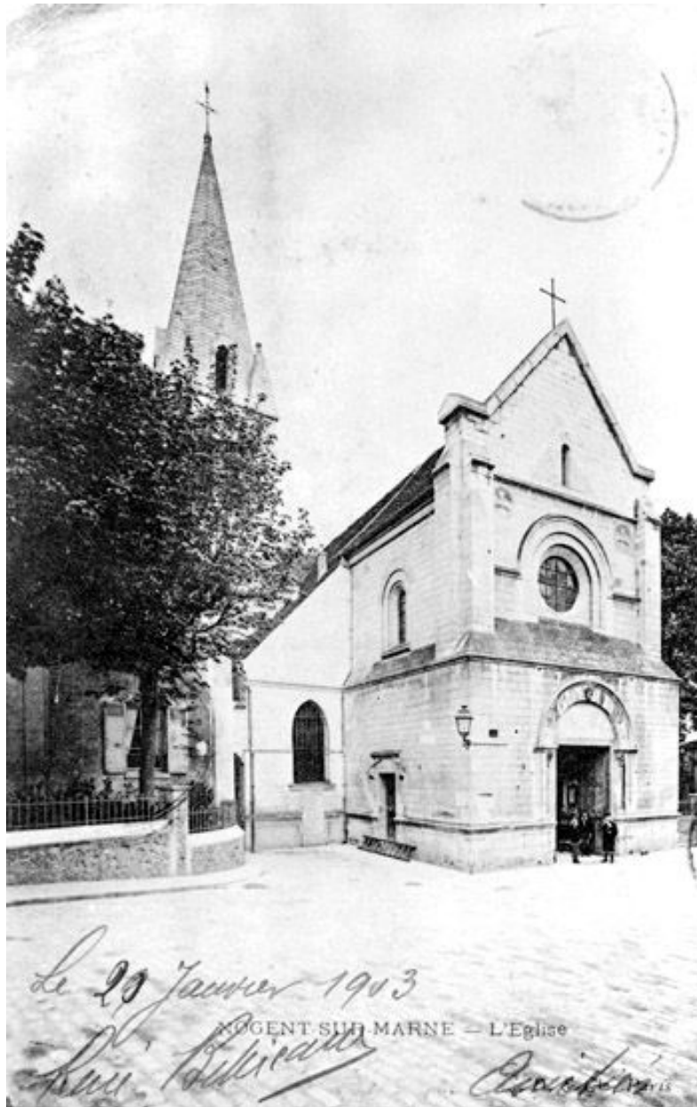
Façade occidentale. Carte postale. (AD Val-de-Marne)
