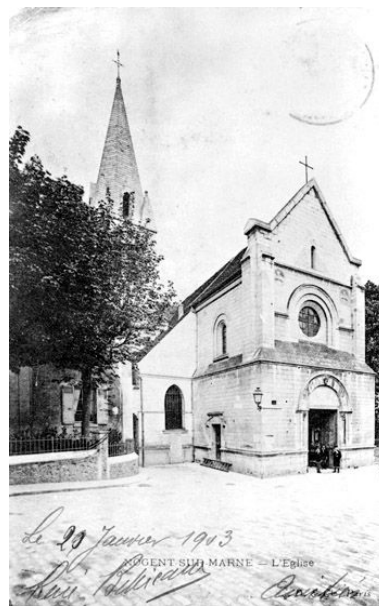
Façade occidentale. Carte postale. (AD Val-de-Marne) IVR11_19859400237XB
