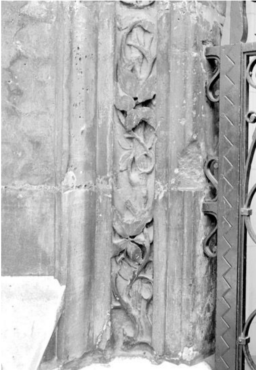
Détail du porche nord: partie inférieure de l'ébrasement gauche.
