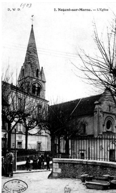
Vue de situation prise du nord- ouest. Photographie ancienne, avant 1913. (BNF. Estampes, topo Va 94 fol., t.7, B 14856) IVR11_19809400779ZB
