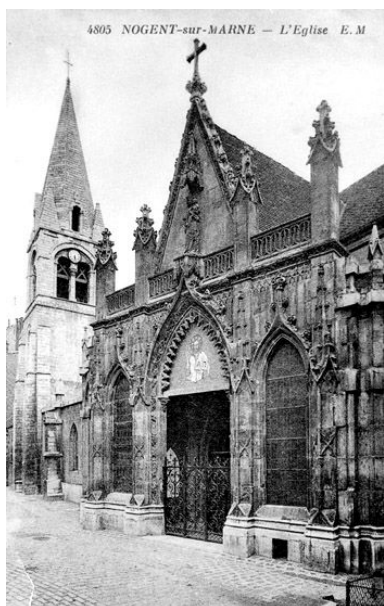
Porche nord mis en place en 1913 provenant d'un couvent de la rue de Varenne à Paris. Carte postale. (AD Val-de-Marne) IVR11_19859400240XB
