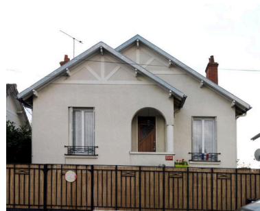
Vue de la maison située au n°17 rue Saint-Fiacre. Phot. Laurent Kruszyk IVR11_20167800692NUC4A
