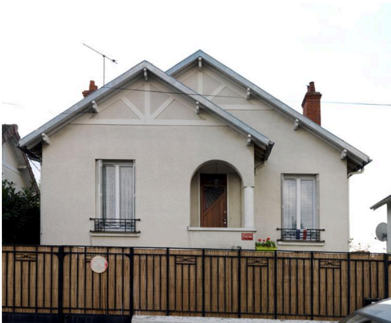
Vue de la maison située au n°17 rue Saint-Fiacre.
