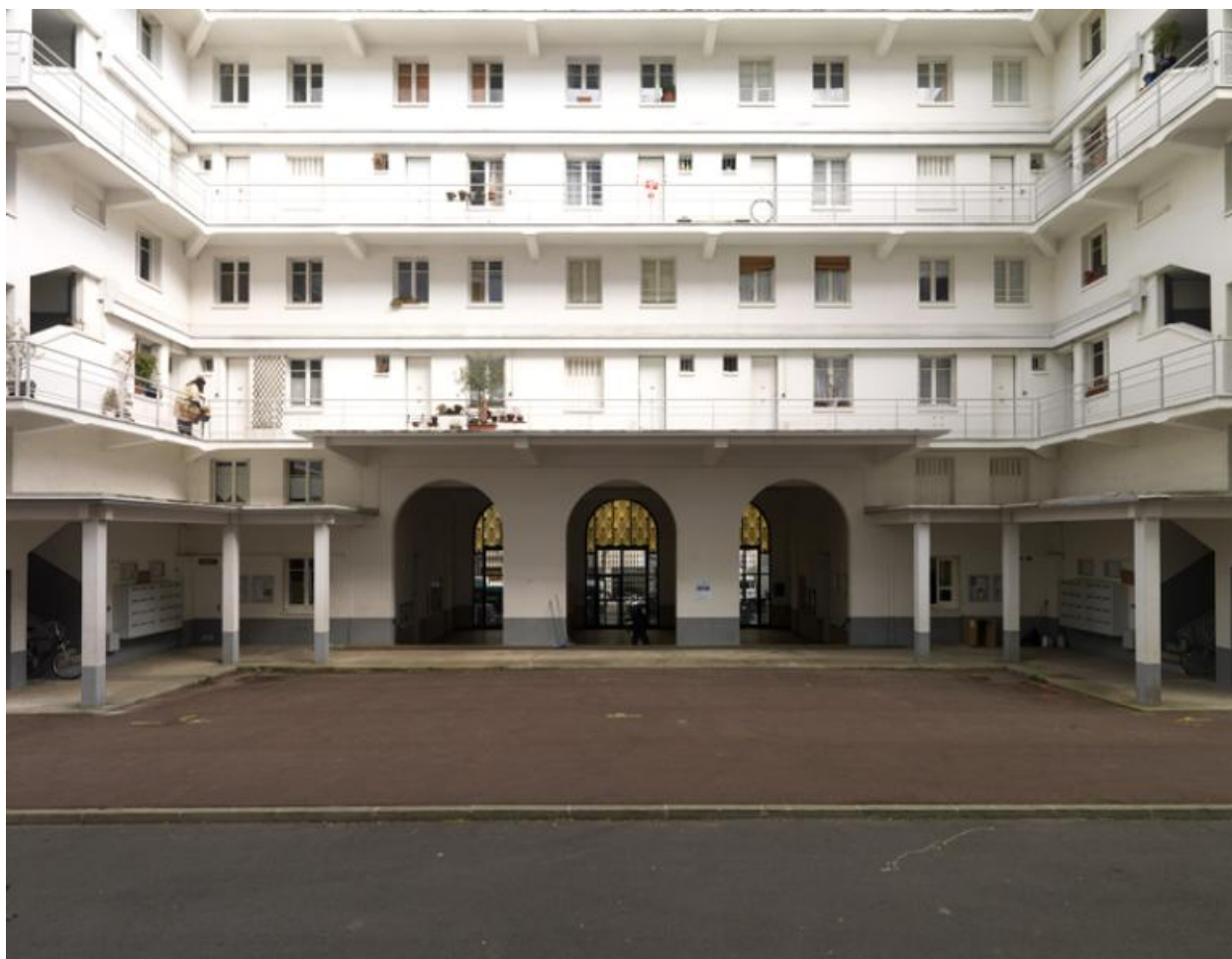
Vue des coursives (arrière du bâtiment principal)
