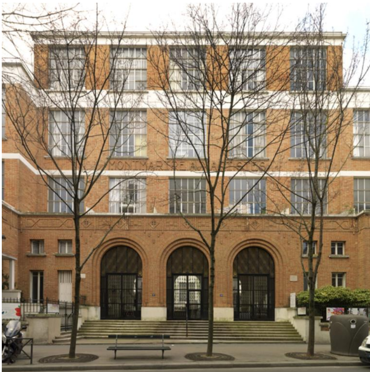
Vue rapprochée du bâtiment central
