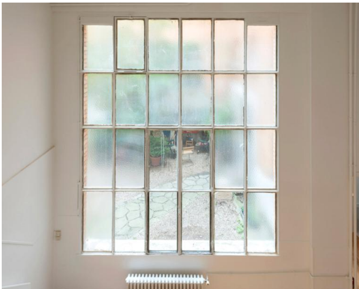
Verrière d'un atelier (inoccupé) en rez-de-chaussée (bâtiment A, côté droit)
