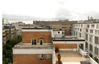
Toit terrasse du bâtiment A Phot. Laurent Kruszyk IVR11_20187500007NUC4A
