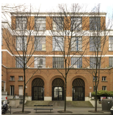
Vue rapprochée du bâtiment central Phot. Laurent Kruszyk IVR11_20187500038NUC4A
