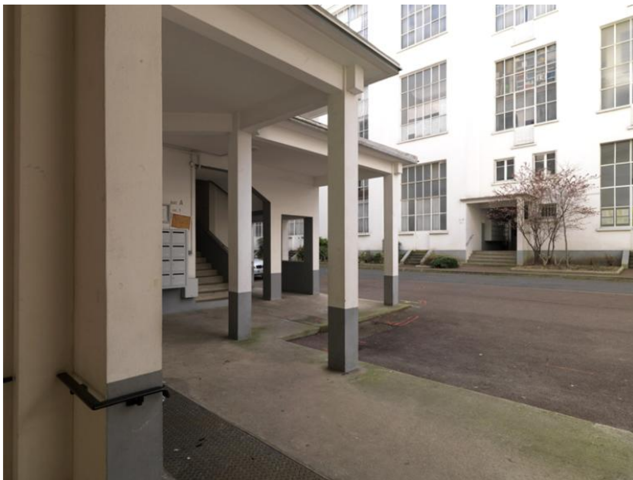
Vue des toits sur pilotis protégeant les accès aux escaliers du bâtiment principal
