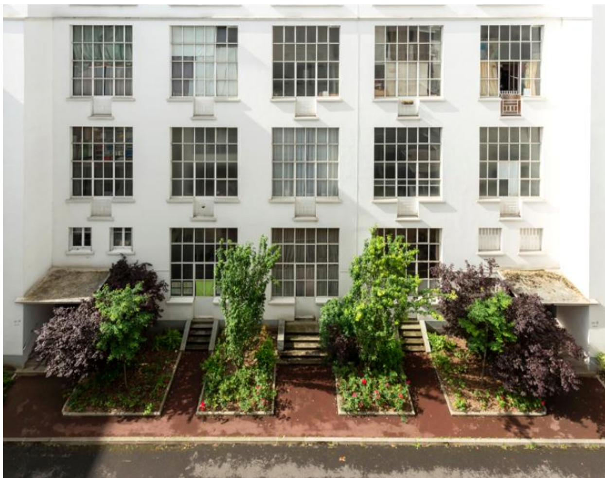
Vue des verrières du bâtiment central (B) prise depuis les coursives du bâtiment A
