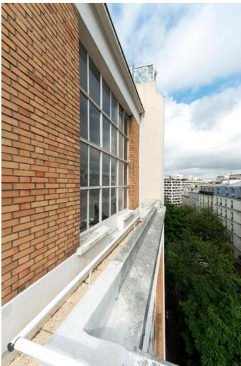
Verrière de l'atelier-logement situé sur le toit terrasse du bâtiment A (coté rue Ordener)
