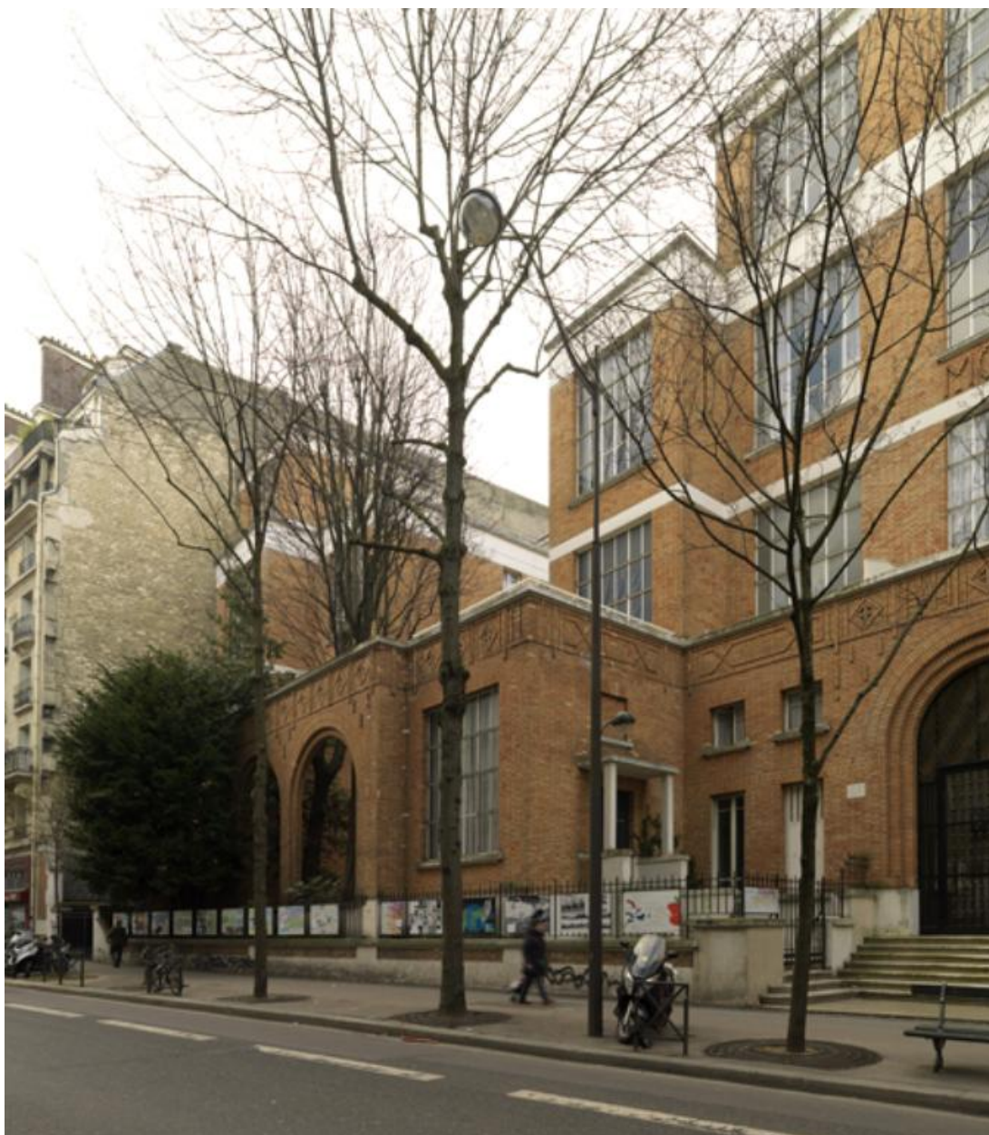
Vue du pavillon latéral prise depuis la rue
