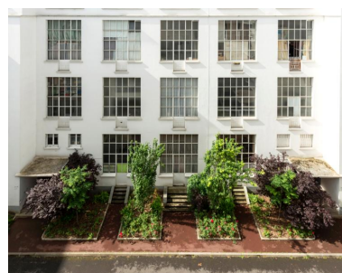
Vue des verrières du bâtiment central (B) prise depuis les coursives du bâtiment A Phot. Laurent Kruszyk IVR11_20187500003NUC4A
