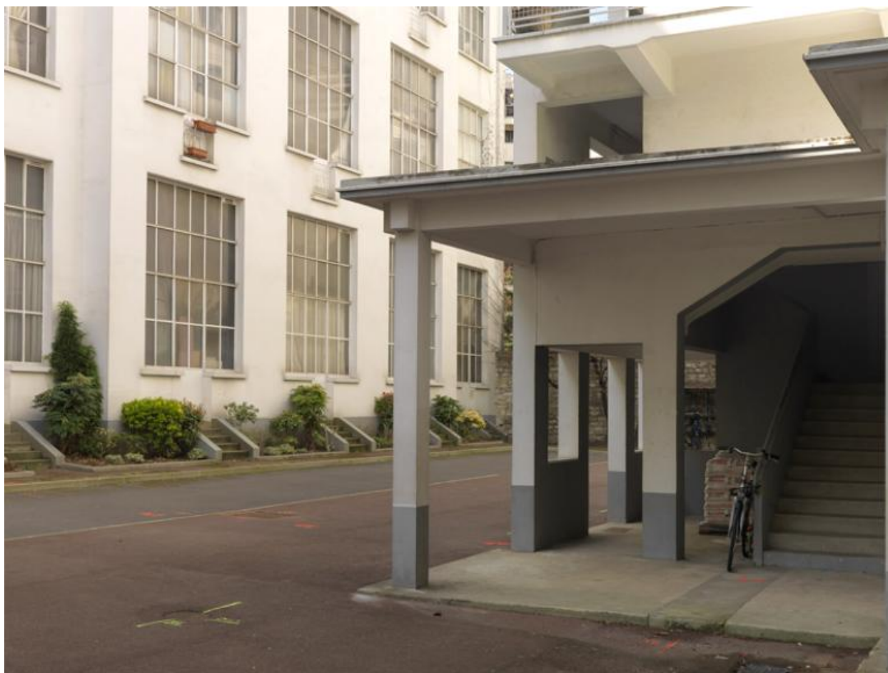
Vue des toits sur pilotis (côté droit)
