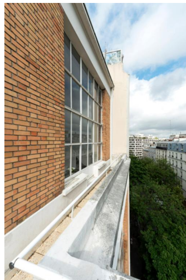
Verrière de l'atelier-logement situé sur le toit terrasse du bâtiment A (coté rue Ordener) Phot. Laurent Kruszyk IVR11_20187500009NUC4A
