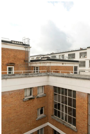
Toit terrasse et verrière du dernier étage du bâtiment A Phot. Laurent Kruszyk IVR11_20187500008NUC4A
