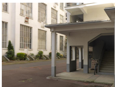
Vue des toits sur pilotis (côté droit) Phot. Laurent Kruszyk IVR11_20187500050NUC4A
