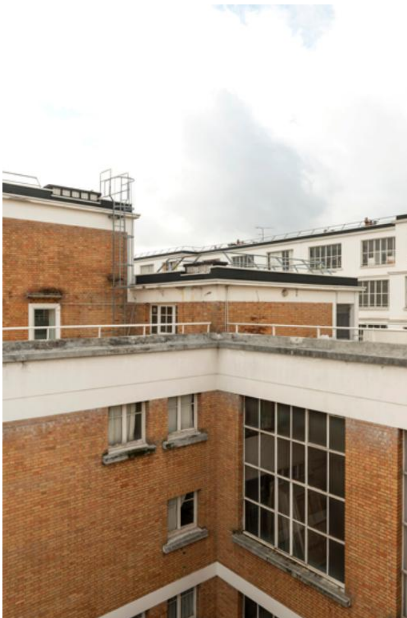
Toit terrasse et verrière du dernier étage du bâtiment A
