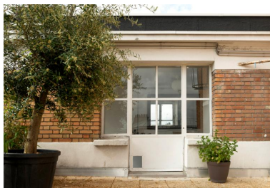
Entrée de l'atelier-logement situé sur le toit terrasse du bâtiment A Phot. Laurent Kruszyk IVR11_20187500010NUC4A
