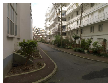
Vue de la cour reliant le bâtiment principal au bâtiment central Phot. Laurent Kruszyk IVR11_20187500052NUC4A
