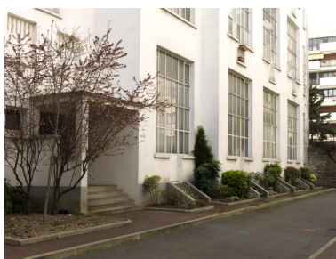
Vue des verrières des ateliers de sculpteurs (batiment central, côté droit) Phot. Laurent Kruszyk IVR11_20187500051NUC4A
