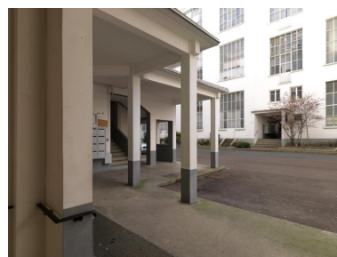
Vue des toits sur pilotis protégeant les accès aux escaliers du bâtiment principal Phot. Laurent Kruszyk IVR11_20187500049NUC4A
