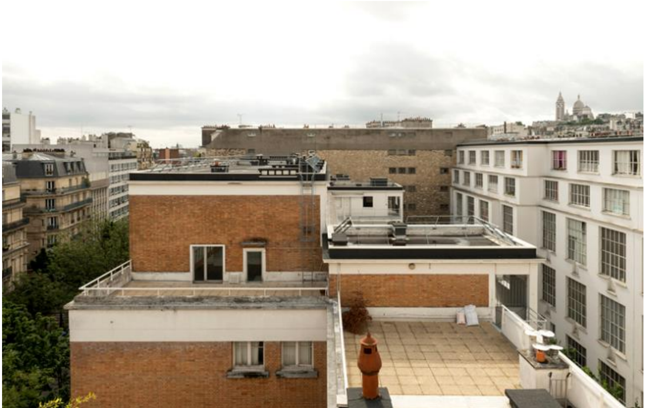
Toit terrasse du bâtiment A
