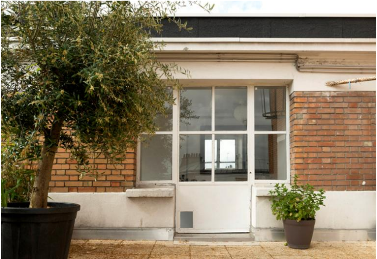
Entrée de l'atelier-logement situé sur le toit terrasse du bâtiment A
