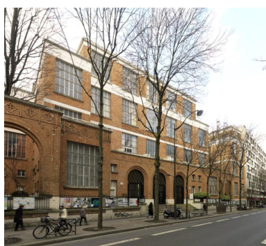
Vue générale de la façade côté rue Phot. Laurent Kruszyk IVR11_20187500037NUC4A
