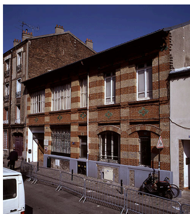
Vue de la façade.
