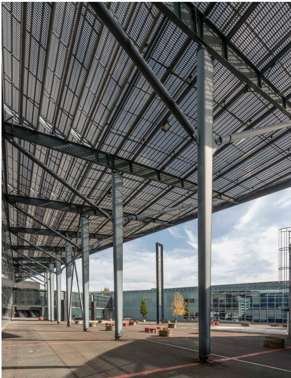
Détail du brise-soleil.
