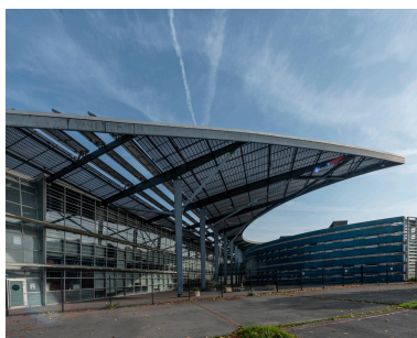
Vue générale du lycée. Verre et acier, des matériaux contemporains, sont
