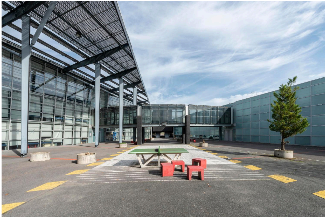
Vue générale de la cour, vers la passerelle reliant les différentes unités du lycée.
