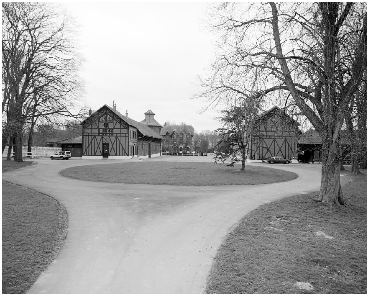
Vue vers la cour d'honneur et l'entrée. Granges et maison de l'administrateur. Haras de Jardy
