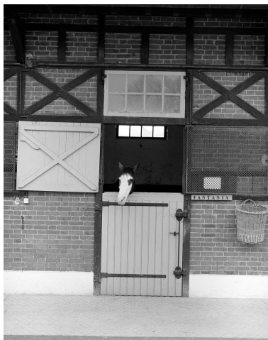
Détail d'un box. Haras de Jardy Phot. Décamps Christian IVR11_19879200304X
