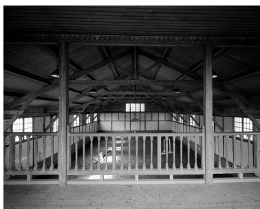
Manège. Vue intérieure depuis la tribune. Haras de Jardy Phot. Décamps Christian IVR11_19879200308V
