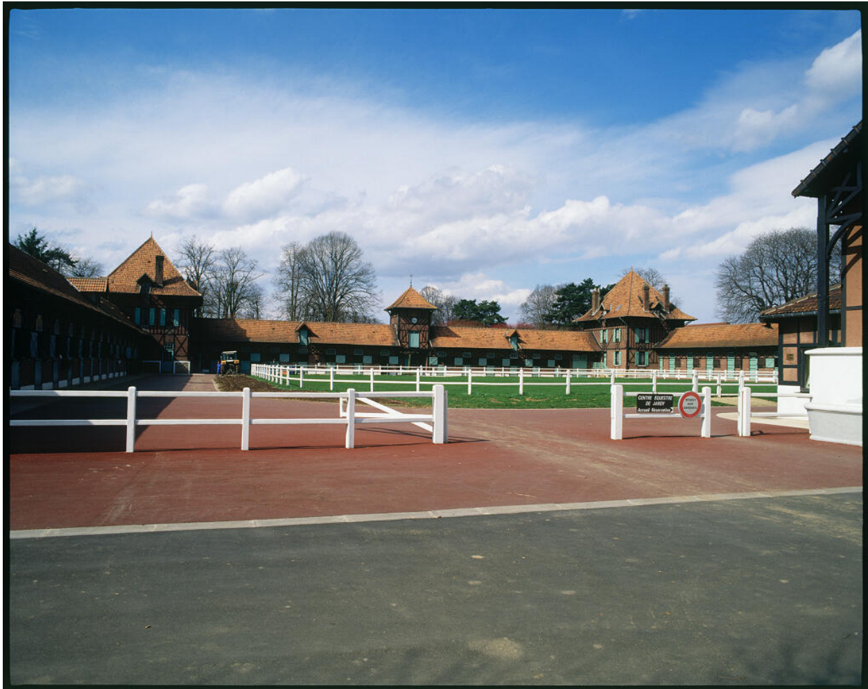
Vue générale de la cour des 49, prise depuis la cour d'honneur. Corps ouest, nord et est dit haras de Jardy, actuellement Parc de Sports et de Loisirs
