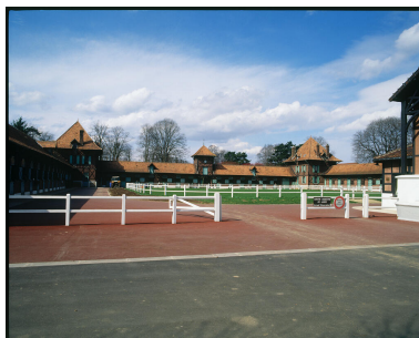
Vue générale de la cour des 49, prise depuis la cour d'honneur. Corps ouest, nord et est dit haras de Jardy, actuellement Parc de Sports et de Loisirs Phot. Décamps Christian IVR11_19879200296XA
