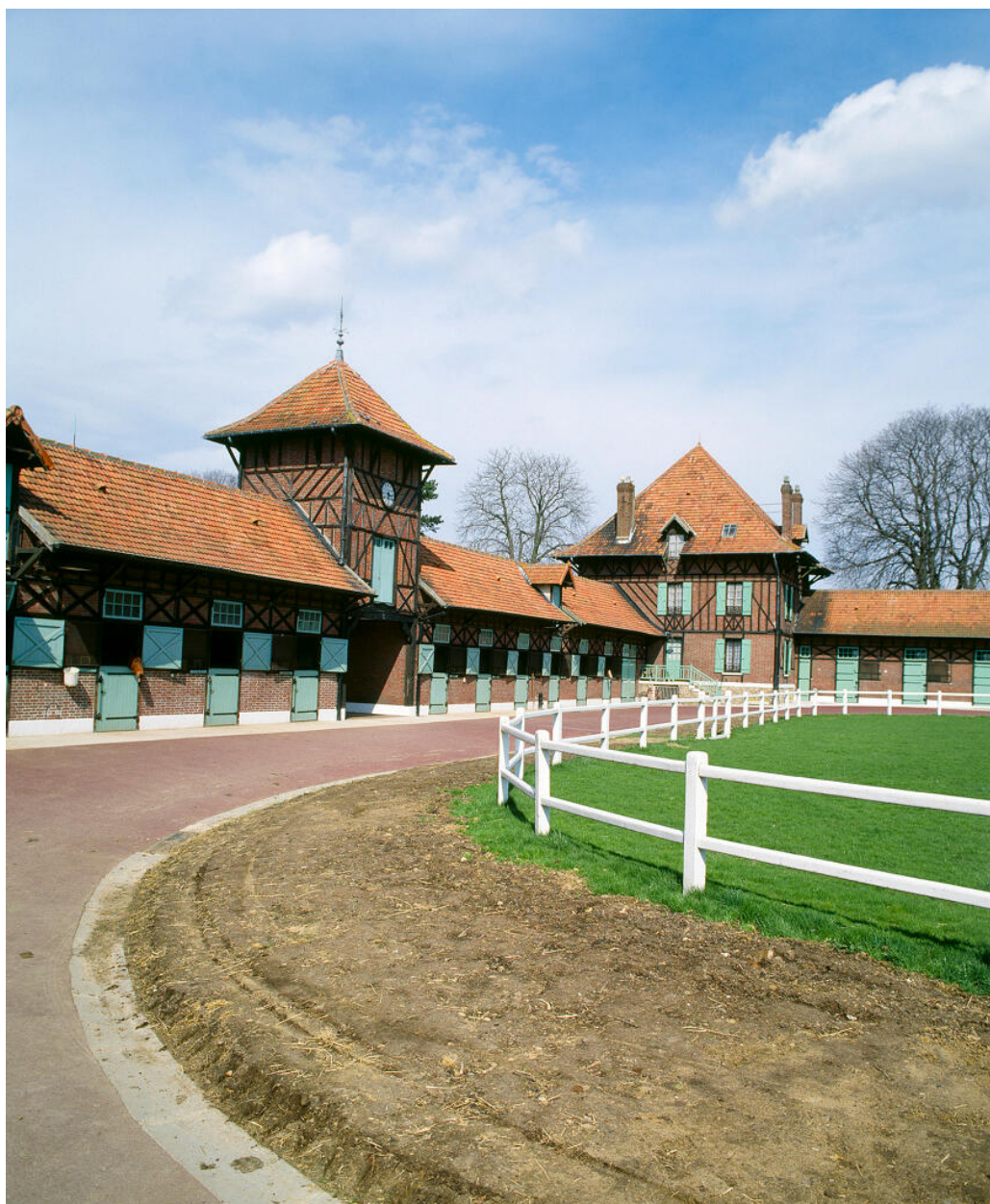
Cour des 49 : fenil, porche et logement des palfreniers.
