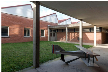
Lycée Rostand : vue des sheds depuis la cour.
