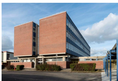
Lycée Rostand : on notera le fort contraste entre les murs pignons aveugles et les façades-écran. Phot. Laurent Kruszyk IVR11_20177800312NUC4A
