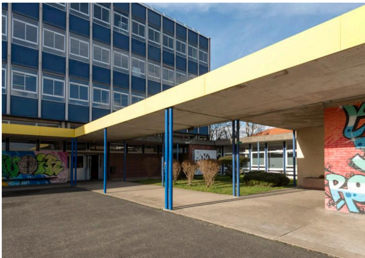
Lycée Rostand : l'angle Nord ouest du patio.
