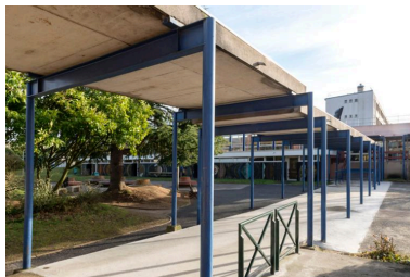
Lycée Rostand : galerie en direction des réfectoires. Phot. Laurent Kruszyk IVR11_20177800319NUC4A
