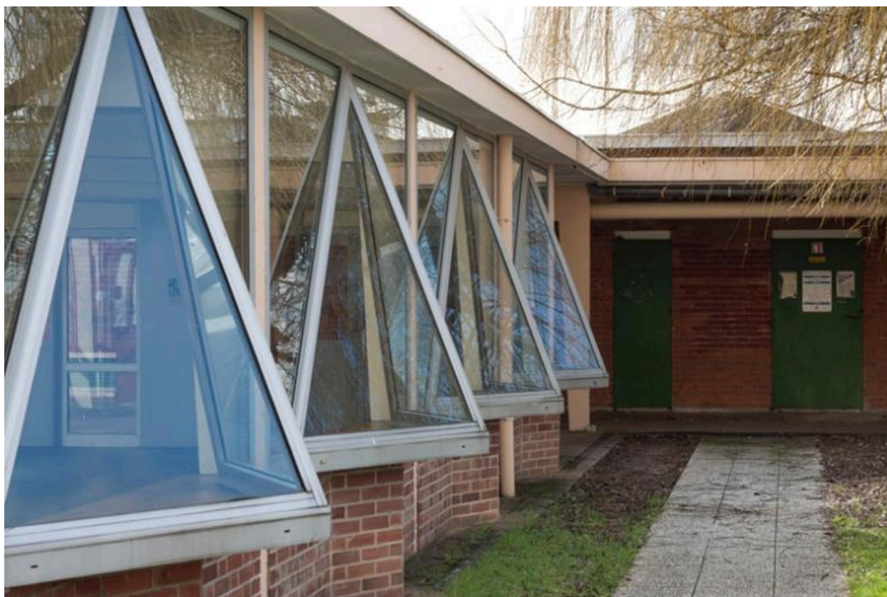
Lycée Saint-Exupéry : baies des années 70 fermant la galerie..
