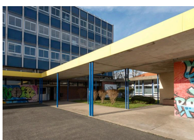
Lycée Rostand : l'angle Nord ouest du patio. Phot. Laurent Kruszyk IVR11_20177800297NUC4A
