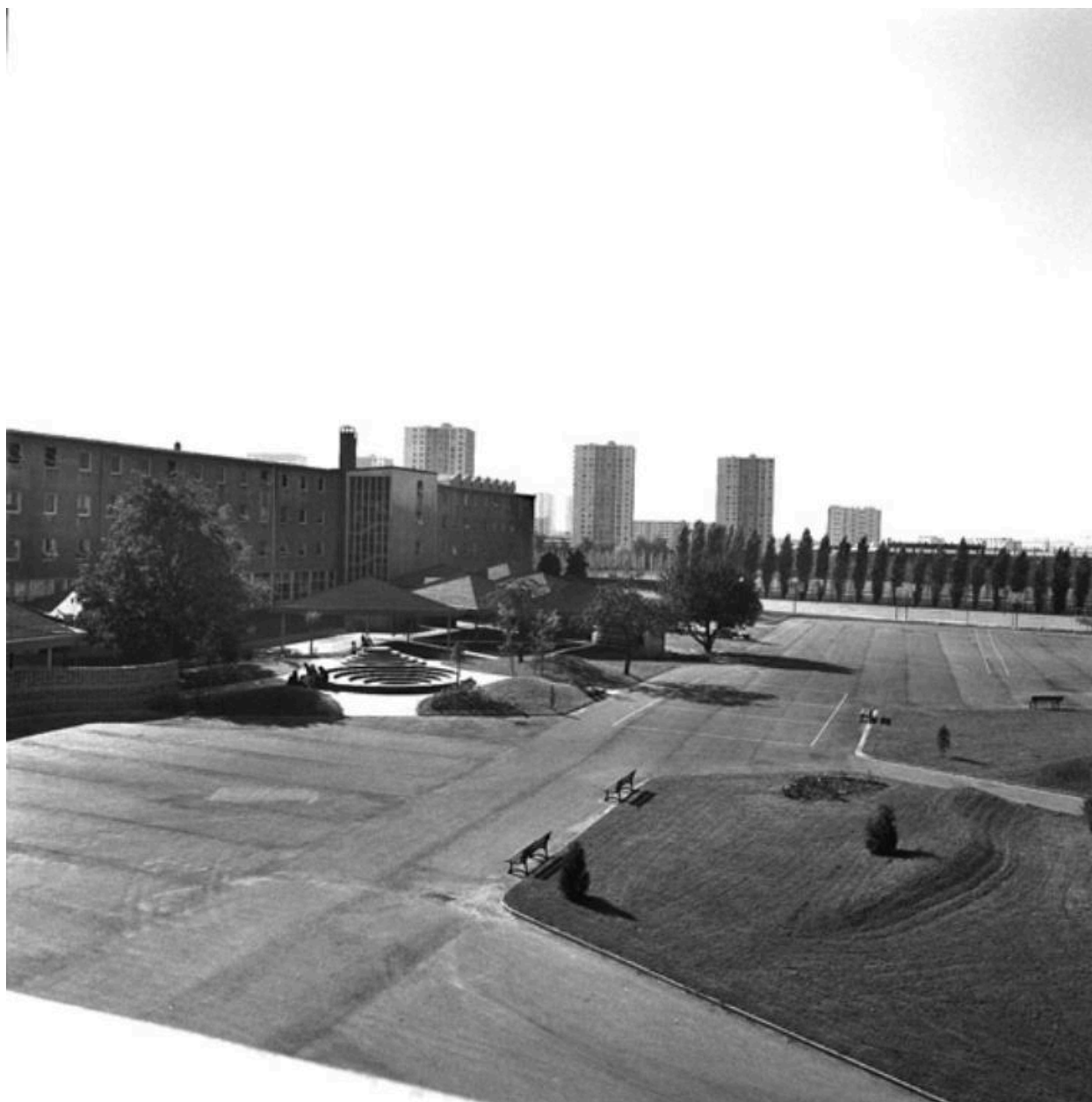
Les aménagements extérieurs liés au 1% artistique du côté du lycée Saint-Exupéry. Vue d'ensemble. (Fonds Bertin)
