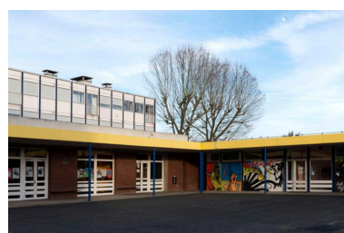
Lycée Rostand : l'angle Nord Est du patio. Phot. Laurent Kruszyk IVR11_20177800295NUC4A
