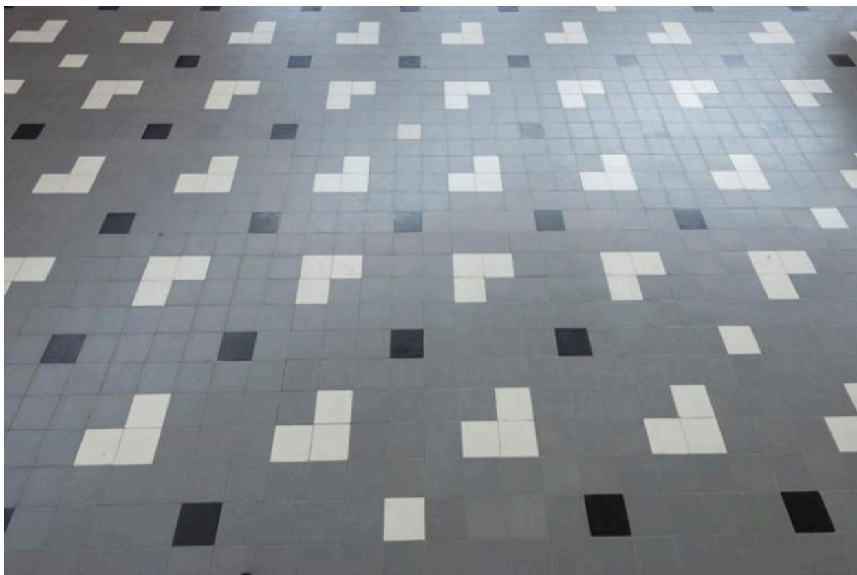
Carrelage du sol du réfectoire.
