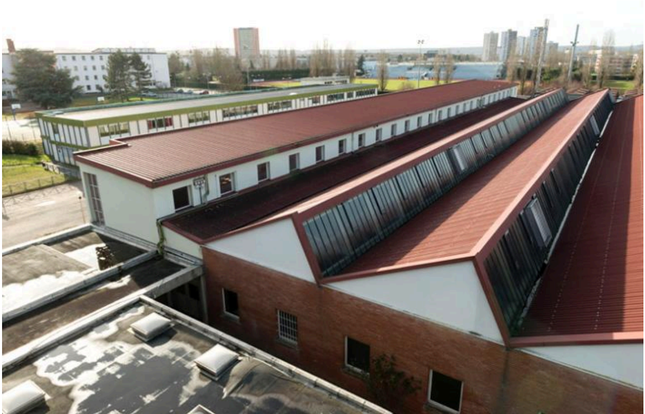
Lycée Rostand : vue des sheds depuis le bâtiment principal. Ceux que l'on aperçoit ici sont d'origine.
