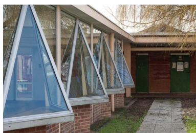
Lycée Saint-Exupéry : baies des années 70 fermant la galerie.. Phot. Laurent Kruszyk IVR11_20177800260NUC4A
