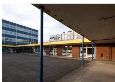
Lycée Rostand : le côté Nord du patio. Phot. Laurent Kruszyk IVR11_20177800296NUC4A
