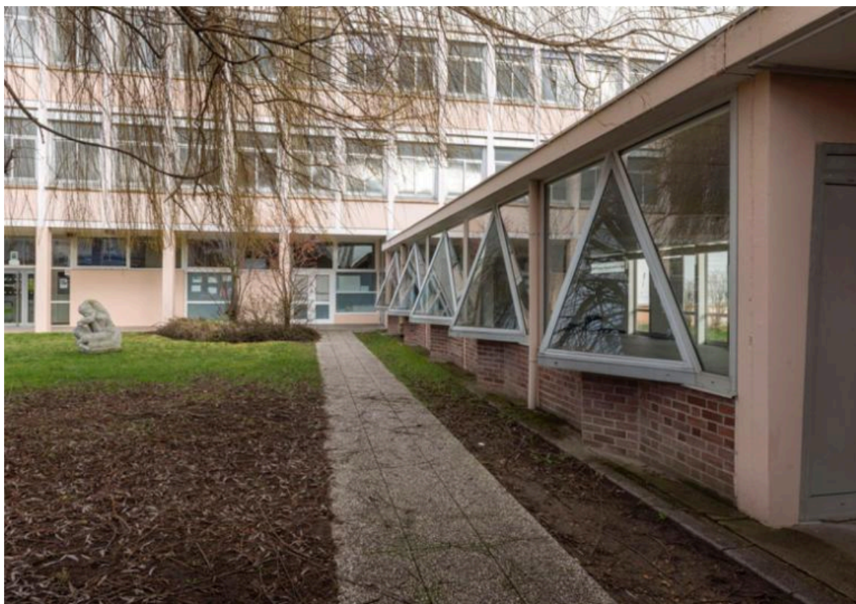
Lycée Saint-Exupéry : galerie couverte fermant le patio sur le côté est. Elle a été vitrée dans les années 70.
