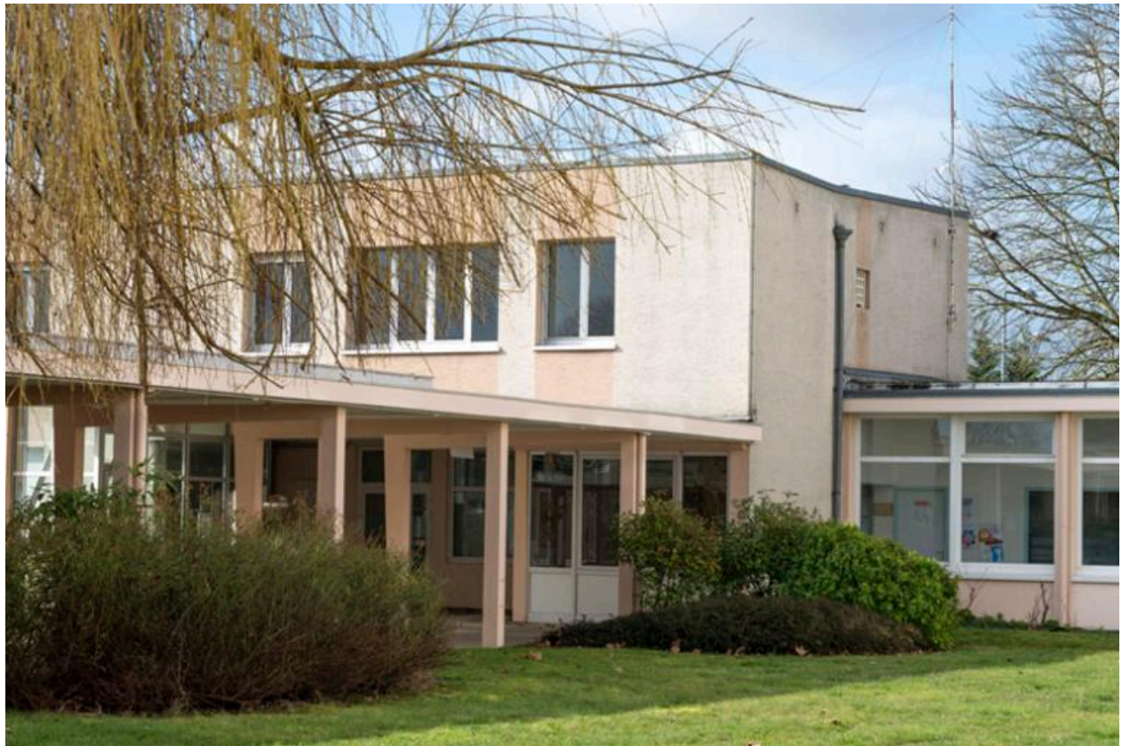
Lycée saint-Exupéry : ancien accueil, logements de fonction et galeries formant un patio le long du bâtiment de l'externat.
