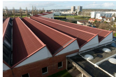
Lycée Rostand : les ateliers comportaient à l'origine 4 sheds. Les 2 sheds de droite ont été ajoutés postérieurement.
