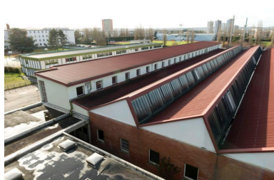
Lycée Rostand : vue des sheds depuis le bâtiment principal. Ceux que l'on aperçoit ici sont d'origine.
