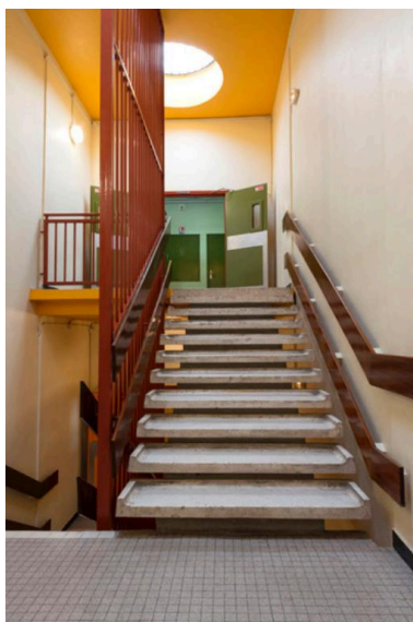
Lycée Rostand : les escaliers sont en "échelle de perroquet" c'est-à-dire soutenus par une crémaillère centrale et sans contre-marche. Phot. Laurent Kruszyk IVR11_20177800331NUC4A
