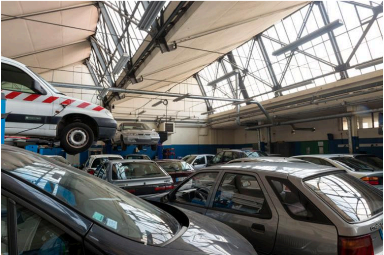
Lycée Rostand : l'atelier de la section Maintenance des Véhicules Automobiles (MVA). On notera les sheds étrésillonnés de l'extension.
