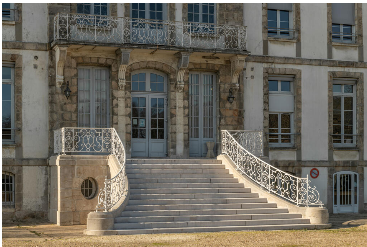
L'escalier du perron est.
