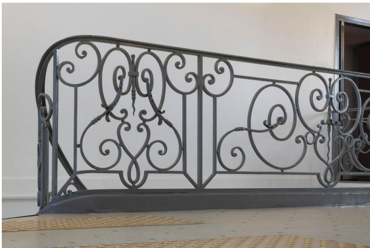
Détail du garde-corps de l'escalier au premier palier.
