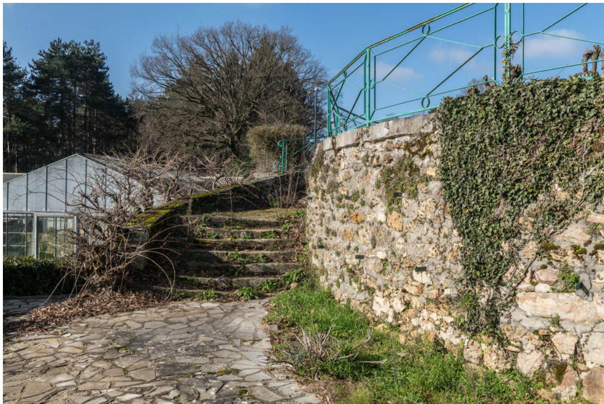
Le belvédère est constitué de plusieurs rampes concaves reliées par des escaliers. Détail de l'un des escaliers ouest.
