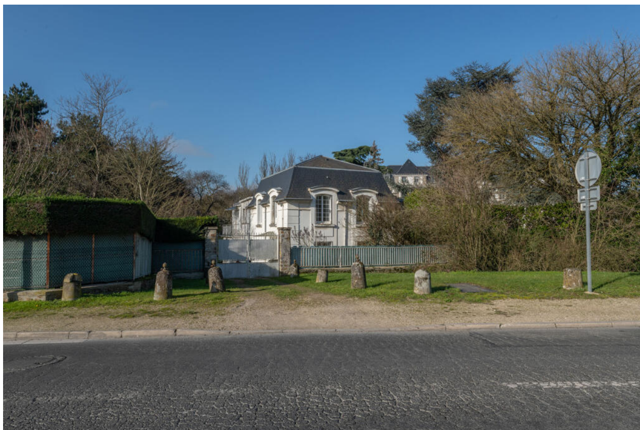
Entrée sud-est de la propriété, du côté d'une maison de gardien construite au XIXe s.
