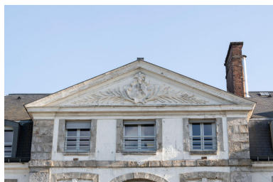
Détail du fronton ouest. IVR11_20239100017NUC4A
