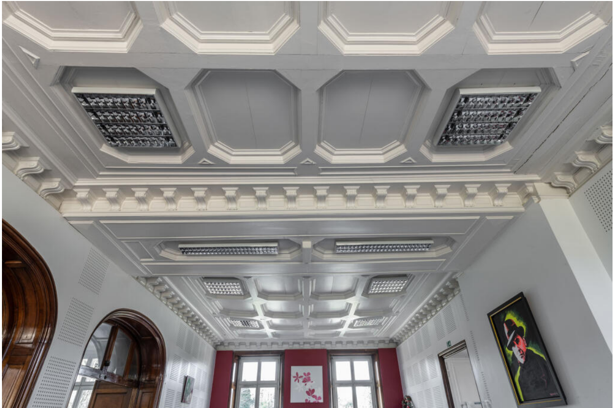
Rez-de-chaussée, détail du plafond à caissons de la salle à manger.
