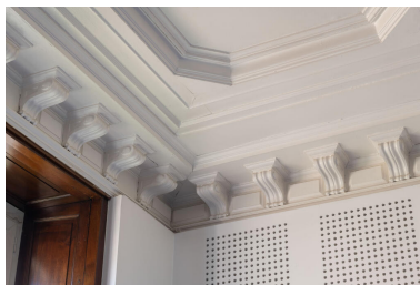
Rez-de-chaussée, détail du plafond du premier salon nord. IVR11_20239100062NUC4A
