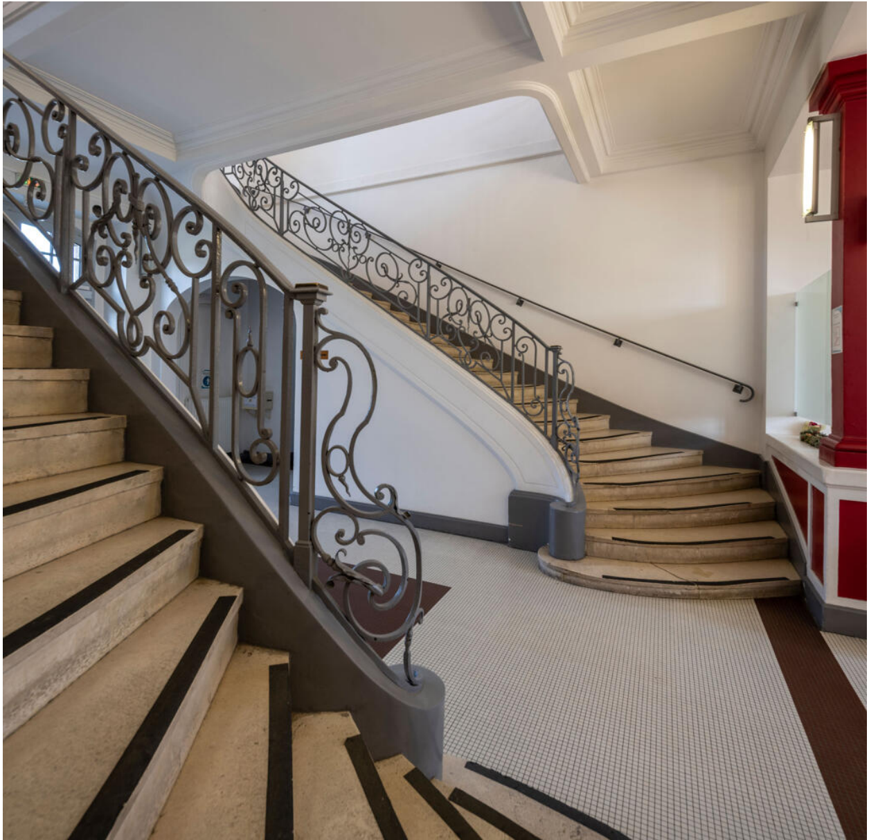
Départ de l'escalier monumental au rez-de-chaussée. L'élégante rampe d'appui en serrurerie est de style Louis XV.
