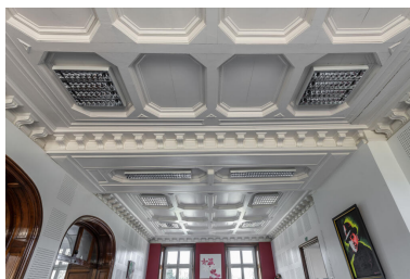
Rez-de-chaussée, détail du plafond à caissons de la salle à manger. IVR11_20239100060NUC4A
