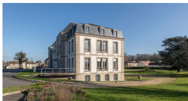
La façade sud, adjonction à l'extrémité du bâtiment. IVR11_20239100019NUC4A
