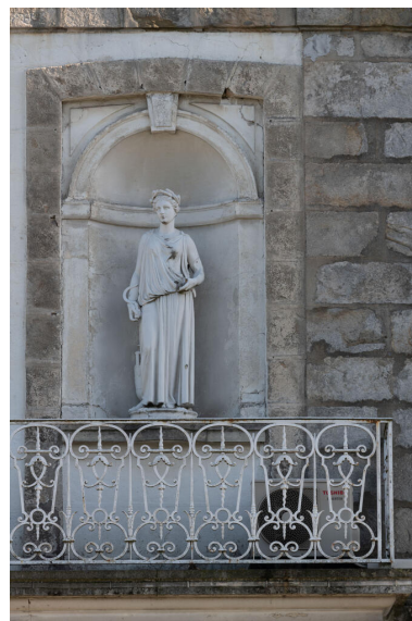
Façade ouest. De part et d'autre de la fenêtre centrale sont présentées des sculptures dans une niche. Ici Cérés ? IVR11_20239100016NUC4A
