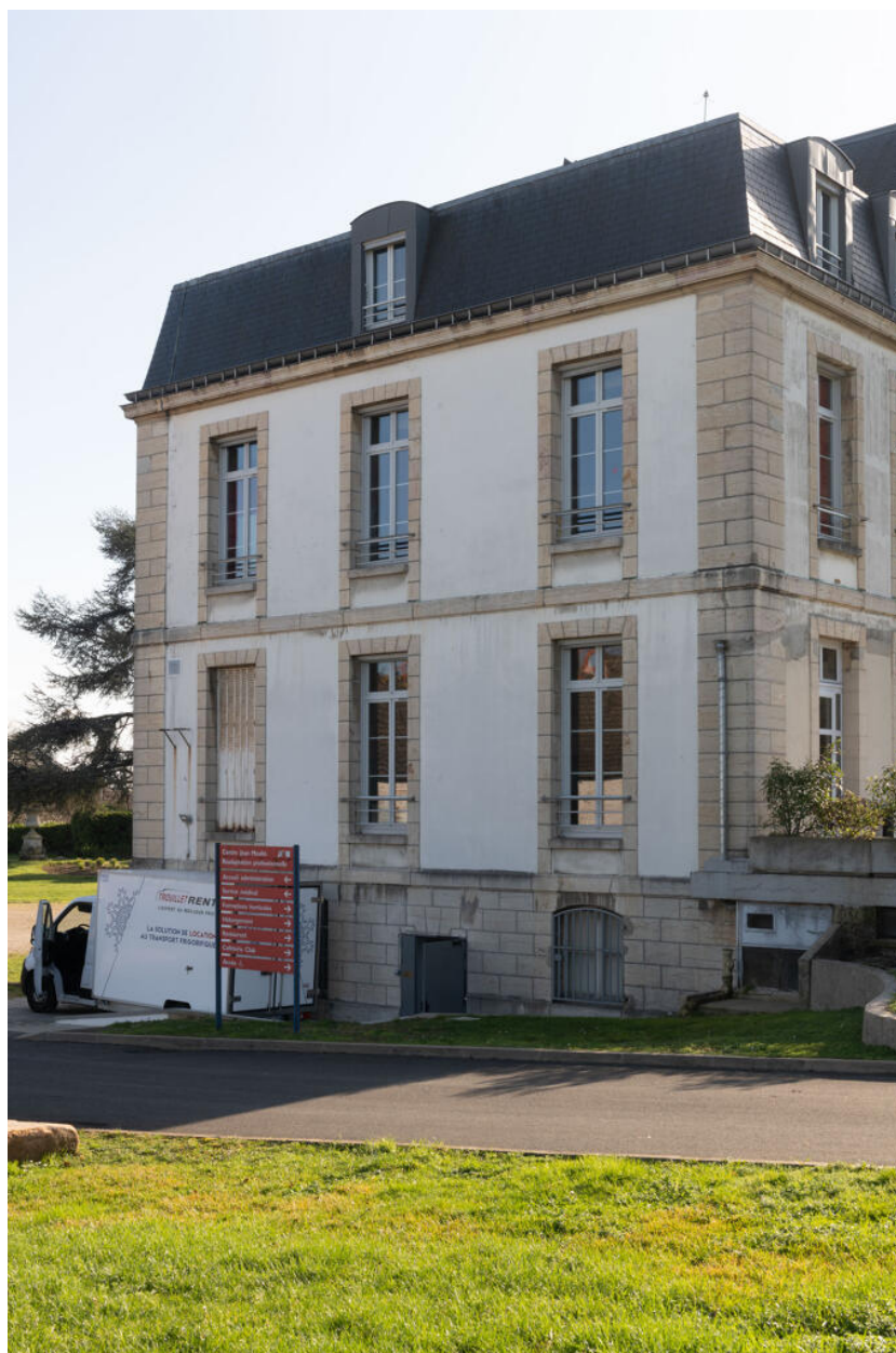
La façade nord, adjonction à l'extrémité du bâtiment.
