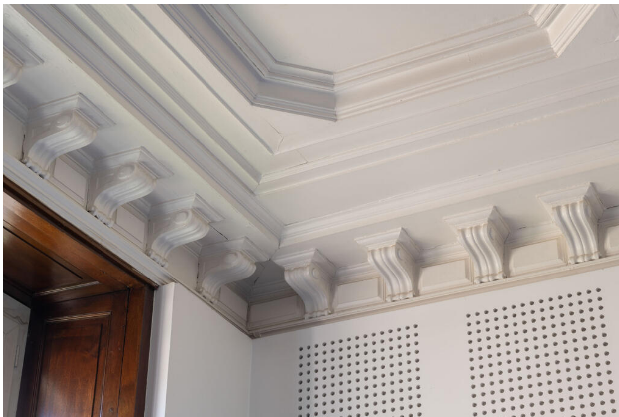
Rez-de-chaussée, détail du plafond du premier salon nord.
