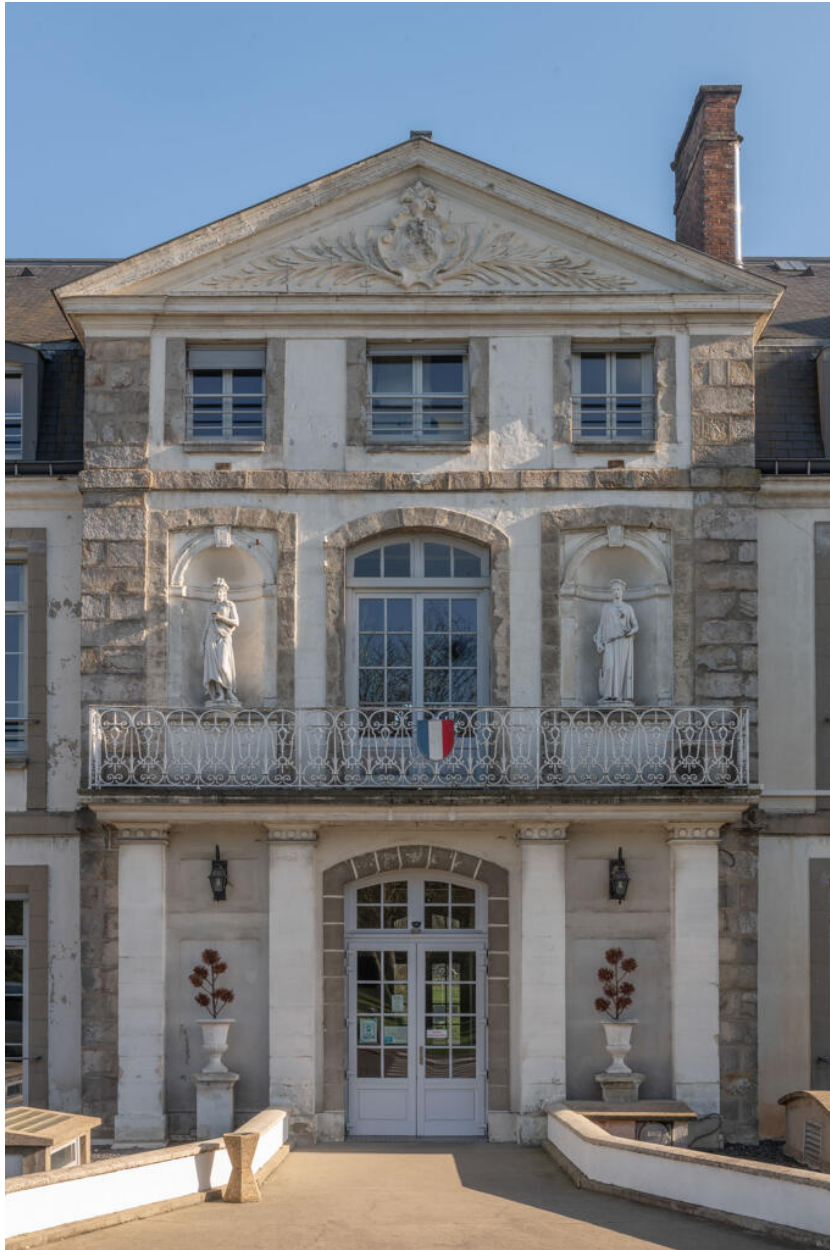
Façade ouest, le corps central.
