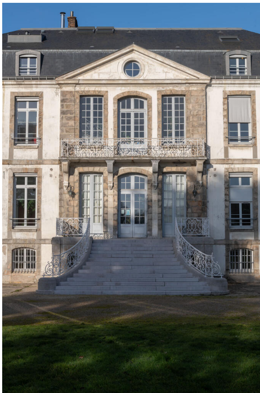
Détail du corps central de la façade est.
