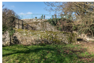
Le belvédère en forme de vertugadin, qui apparaît sur le plan cadastral de 1809, est encore en place. IVR11_20239100038NUC4A
