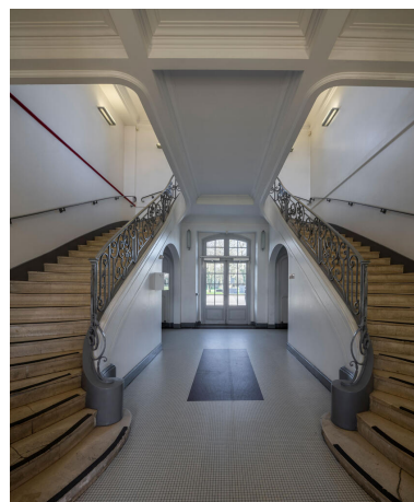
Départ des deux rampes qui se rejoignent pour former un passage suspendu qui traverse le hall. Au fond, la porte ouest, ouvrant côté jardin. IVR11_20239100045NUC4A
