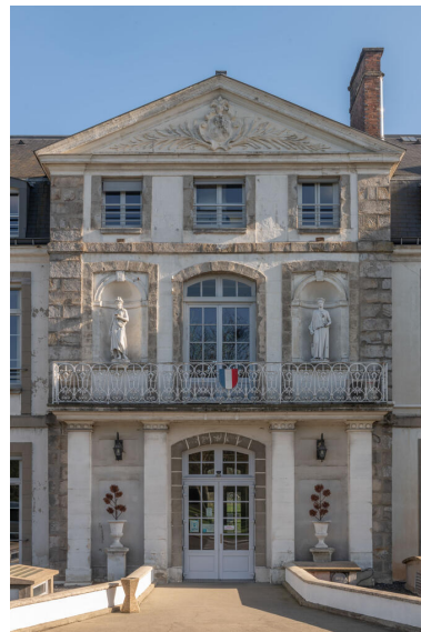
Façade ouest, le corps central. IVR11_20239100014NUC4A
